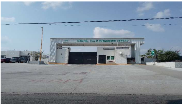
Fotografía 4.- Central termoeléctrica en octubre del 2022
