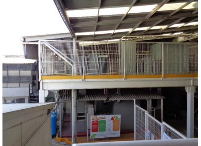
Imagen 10. Vista a equipos existentes desde planta alta [Fotografía] Elaboración propia. (2022) Edo. Mex.
