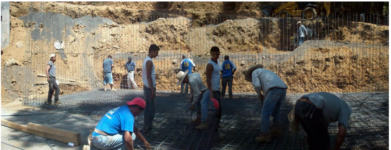
Armado de tanques Físico-Químico y de Aereación Extendida
