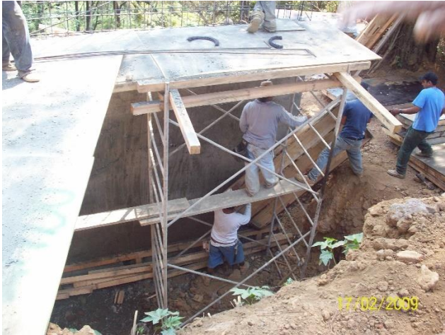
Desenfofrado de 1ª. Sección
