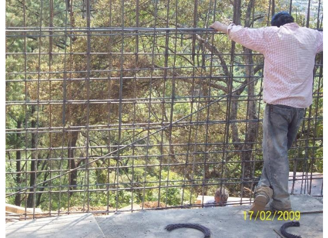
Armado de pantalla superior
