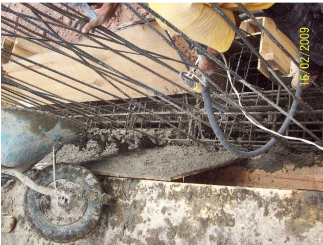
Vital la importancia del vibrado
