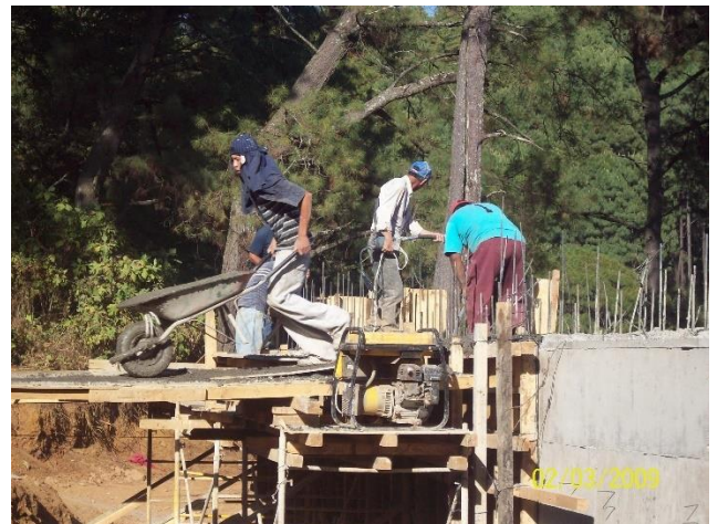
Colado pantalla superior de 2ª sección
