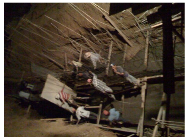
Término de colado por la noche
