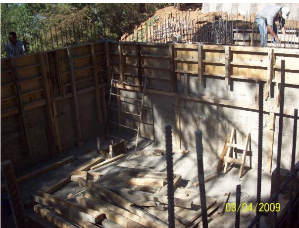
Encofrado de muros
