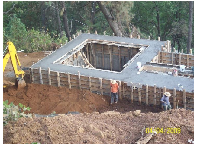
Plataforma para lecho de lodos
