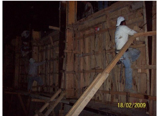
Encofrado de pantalla superior
