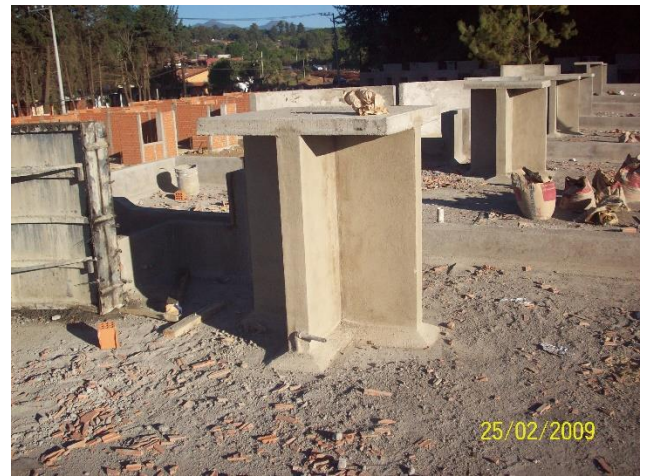
Base terminada con losa y chaflán
