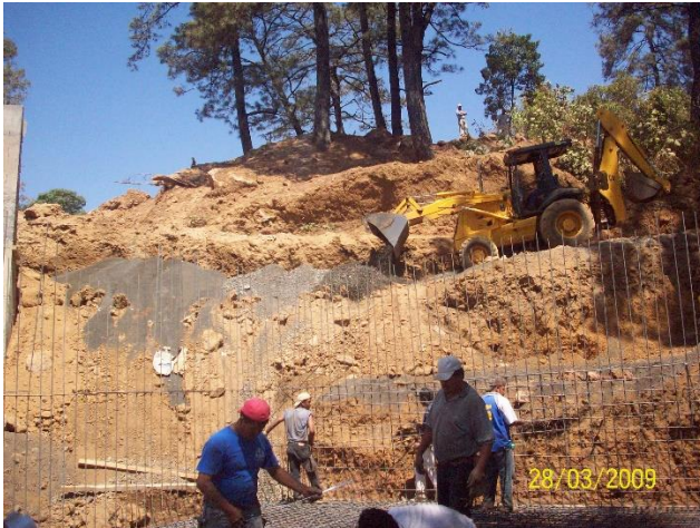
Armado de tanque de Aereación
