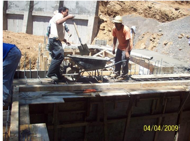
Colado de andadores y losa
