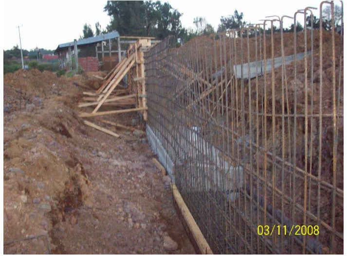
Muro de 2.00 mt. Manzana XIII
