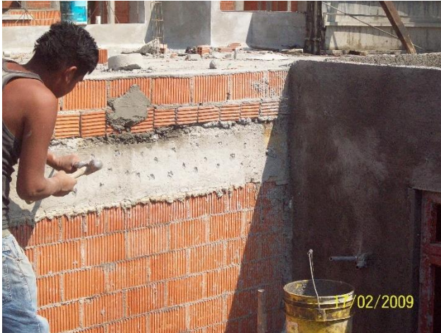
Picado de elementos de concreto
