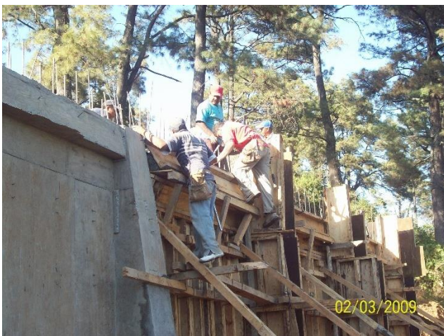
Muro de 7.20 mt. Manzana XIII (Contención de planta de tratamiento de aguas)
