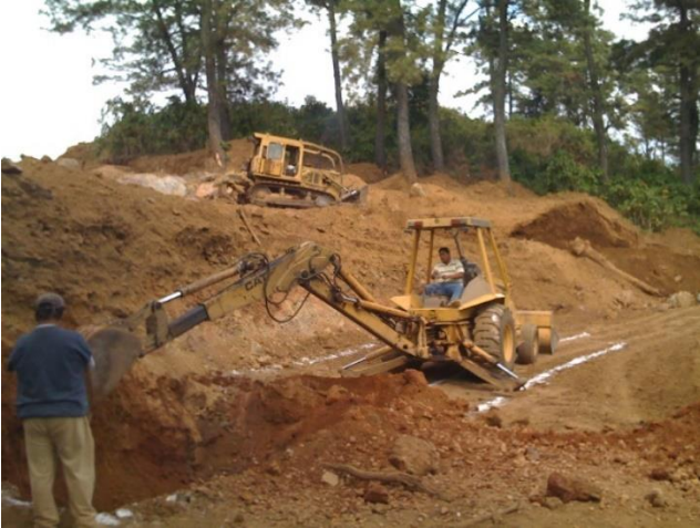
Excavación de Zapata
