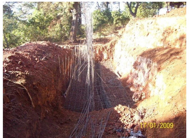
Armado de muro 2ª sección
