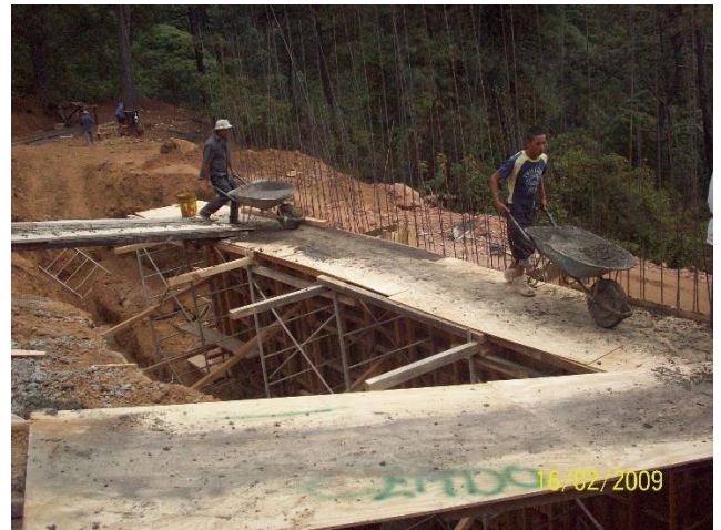
Vista de las pasarelas de colado
