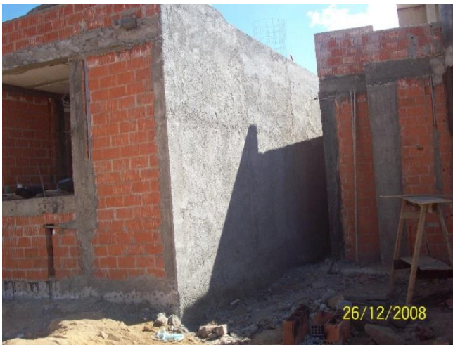
Aplanados exteriores de mortero
