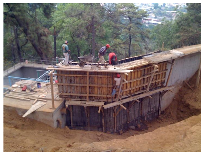
Colado 3ª sección del muro
