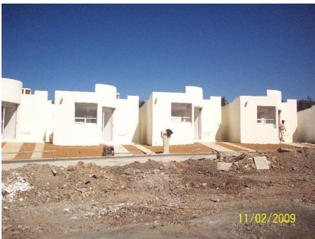
instalación de cristales
