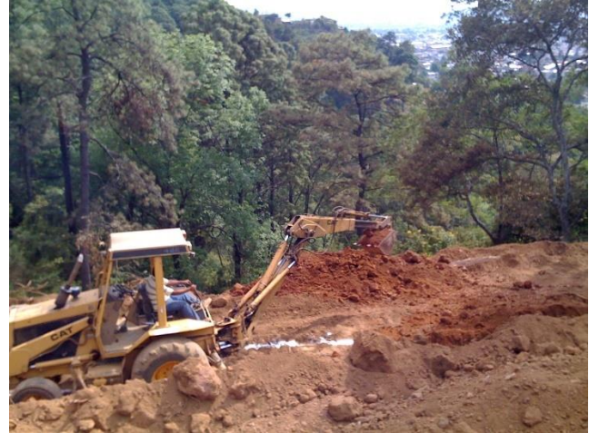
Excavación de Zapata
