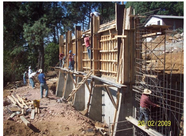
Muro de 7.20 mt. Manzana XIII (Contención de planta de tratamiento de aguas)
