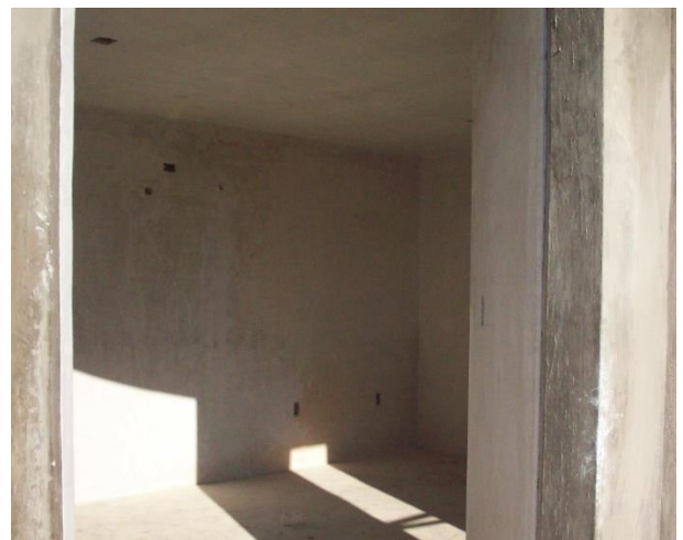
Aplanados interiores de yeso
