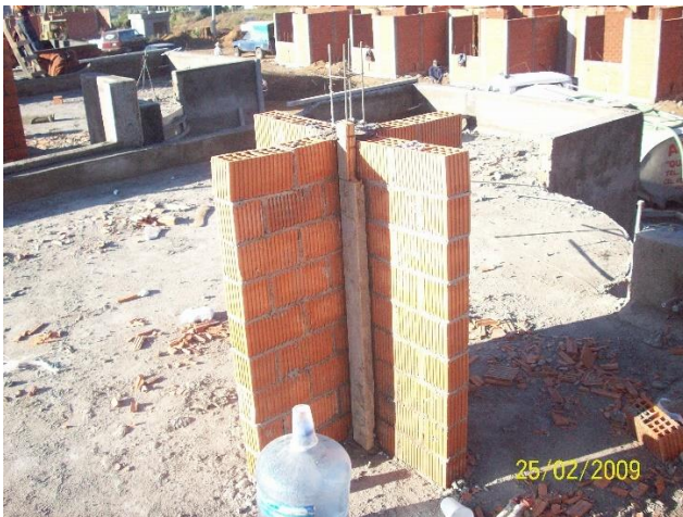
Muros y castillo de base para tinaco
