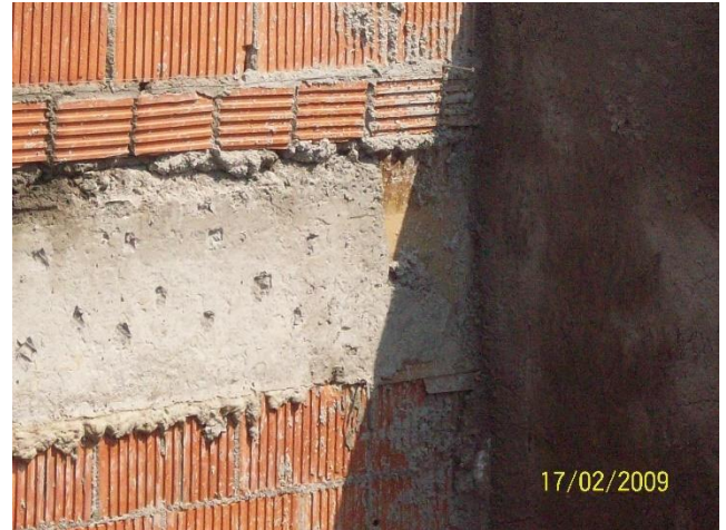
Retiro de elementos ahogados
