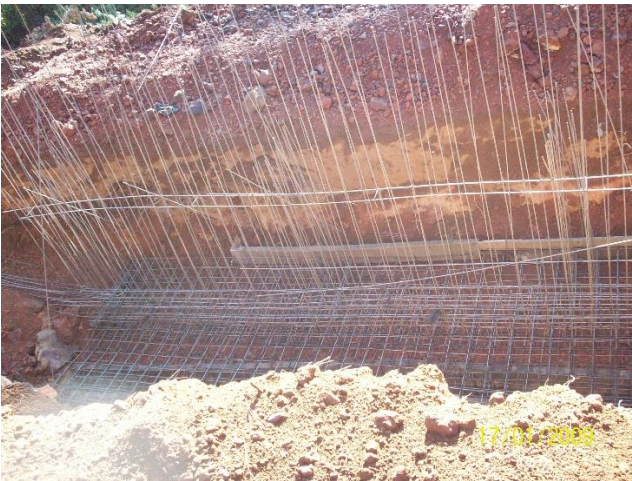
Armado de muro 1ª sección
