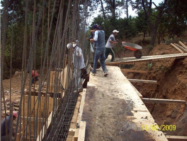
Colado de 1ª. Sección del muro
