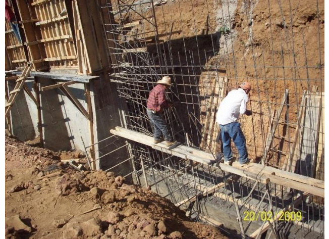
Preparación de 2ª sección de muro
