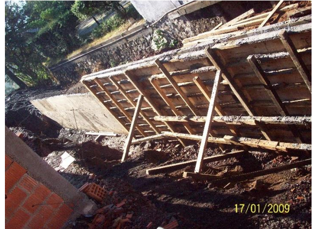
Muro de 2.00 mt. Manzana XIII
