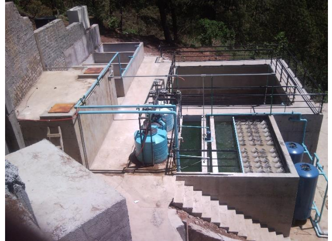
Planta de tratamiento terminada
