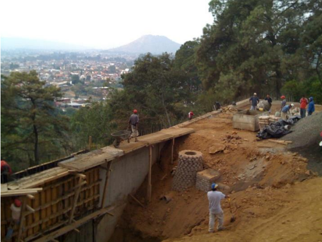
Relleno de 3ª sección del muro
