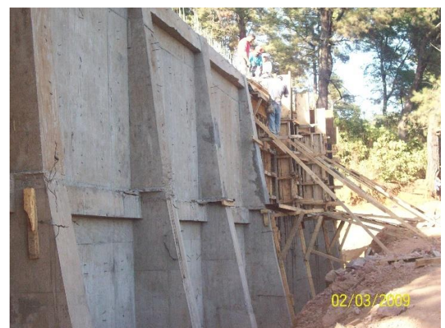
Muro de 7.20 mt. Manzana XIII (Contención de planta de tratamiento de aguas)
