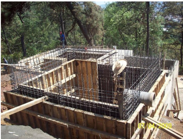
Armado y encofrado tanque de influente
