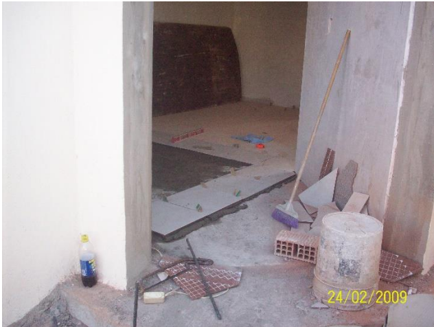
instalación de piso de cerámica
