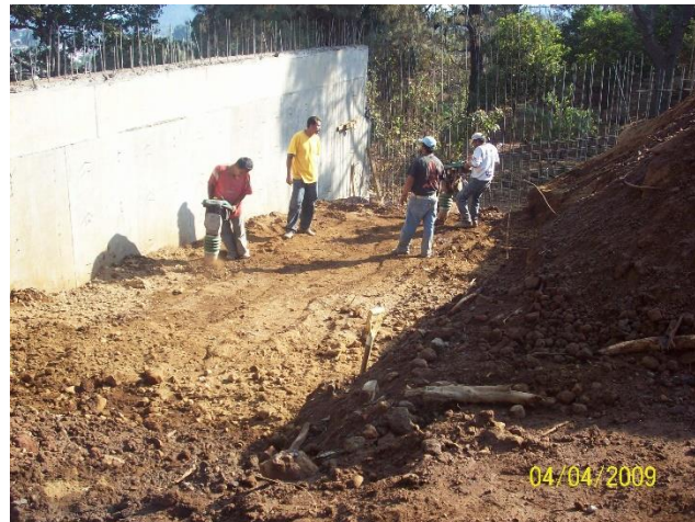
Rellenos y armado de muro lateral
