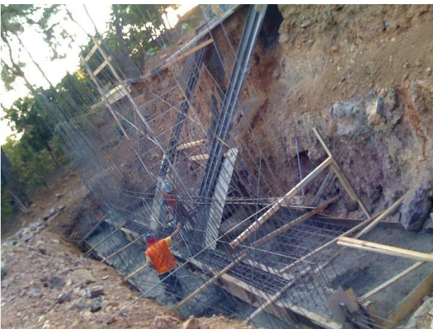
Colado de zapata y dentellón turno de día
