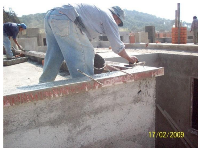
Correcta ejecución de aplanado lateral (de arriba hacia abajo) y de boquillas
