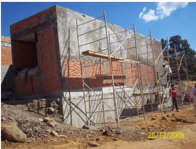
Correcta ejecución de aplanado lateral (de arriba hacia abajo) y de boquillas
