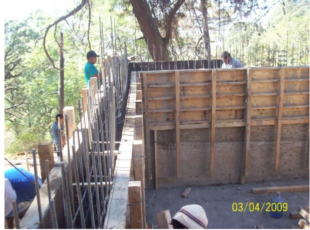
Encofrado de muros
