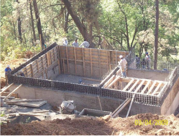
Proceso de armado de muros de tanques
