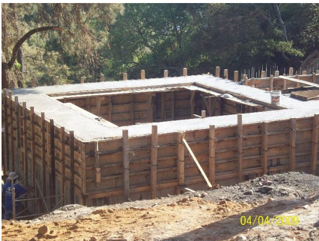
Pozos mayores terminados
