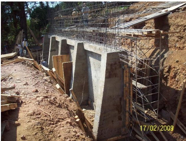
Muro de 7.20 mt. Manzana XIII (Contención de planta de tratamiento de aguas)
