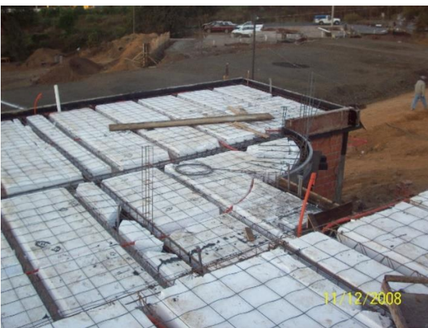
Instalaciones en losa
