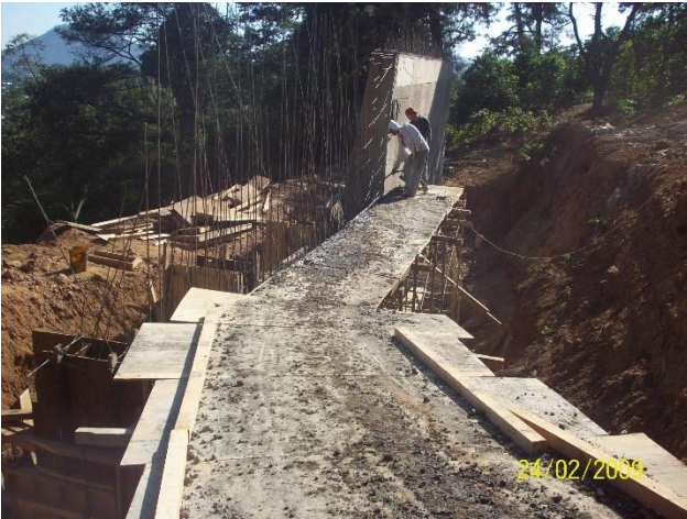
Colado de 2ª sección
