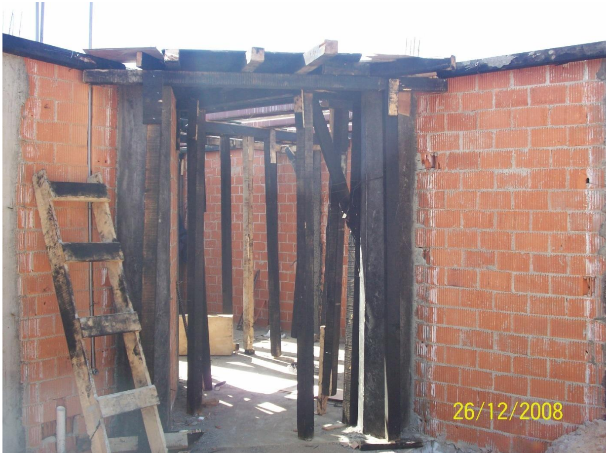
Fotografía de cimbra tipo utilizada en el desarrollo
