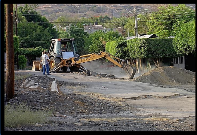
Apertura de caja con máquina retroexcavadora
