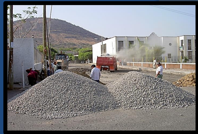
Retiro de material producto de la apertura de caja
