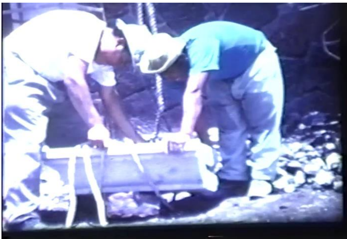
XXIV. Cornisa labrada amarrada en la polea. Amador Calderón Coria. Remodelación de la fachada de la iglesia. [Súper 8] Acervo Privado.
