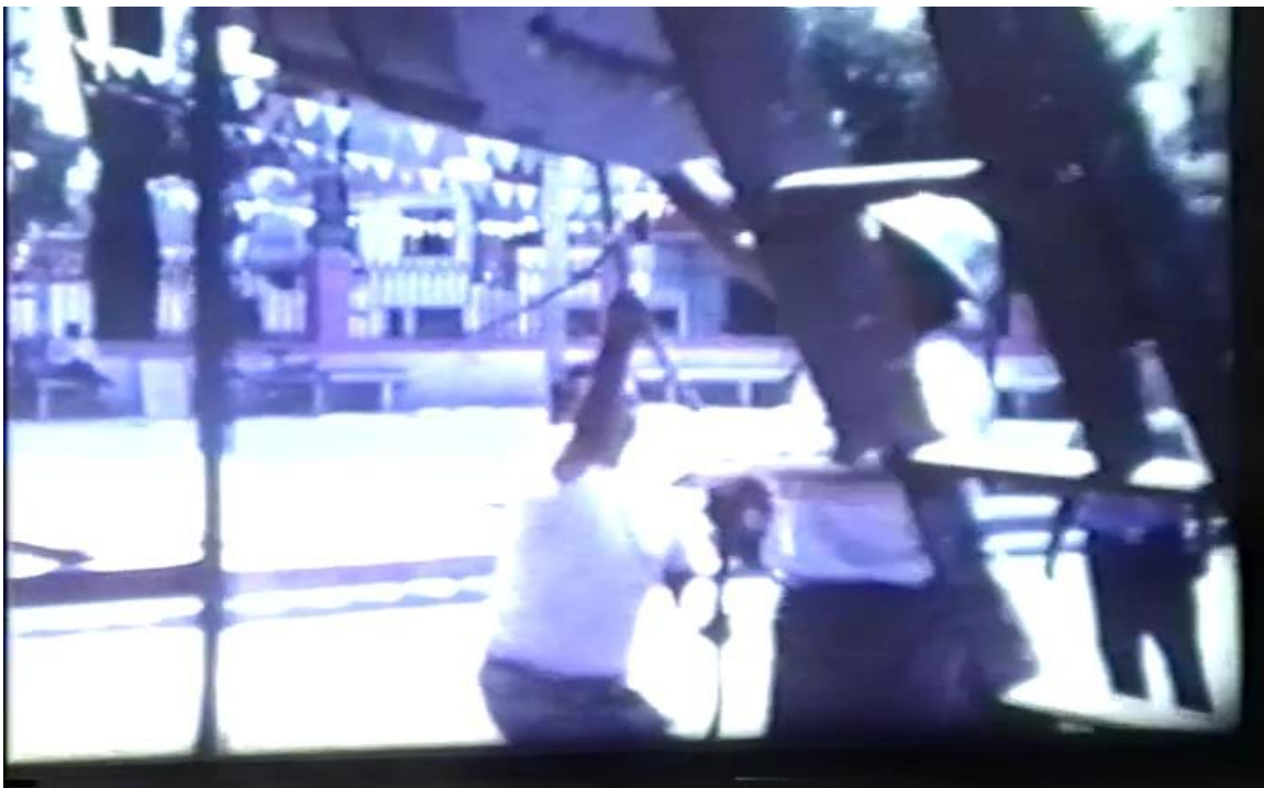
XX. Trabajadores, habitantes y artesano jalan una polea, al fondo, el pueblo de San Juanico. Amador Calderón Coria. Remodelación de la fachada de la iglesia. [Súper 8] Acervo Privado.
