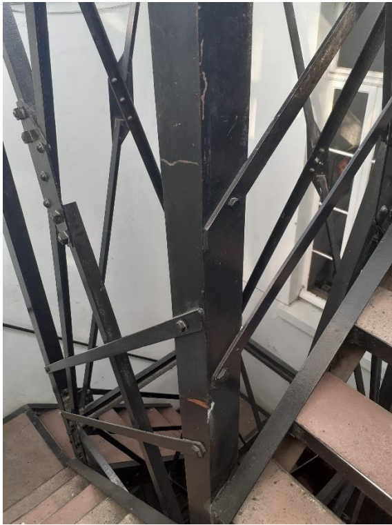
124. CUBO ESCALERAS (Miranda S. 2022)
