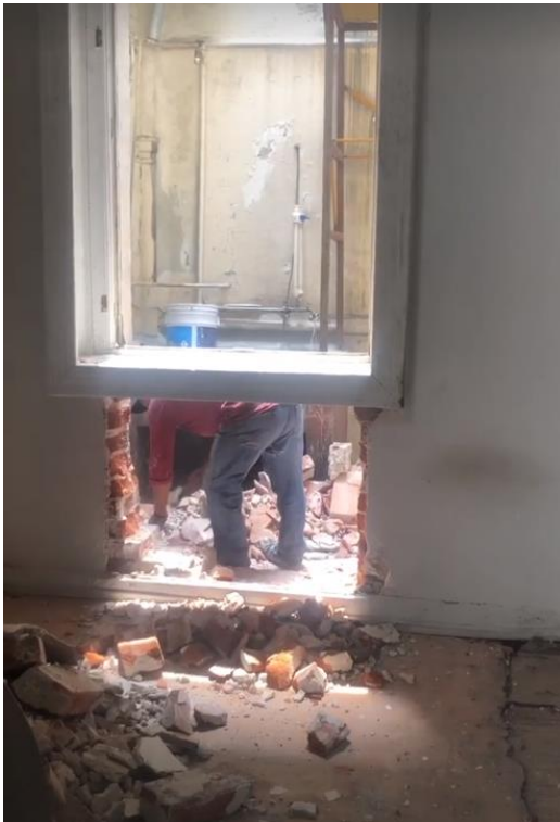
170. DESMANTELAMIENTO (Adriana Z. 2019)
