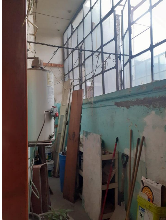
134. CUARTO DE LAVADO (Miranda S. 2022)
