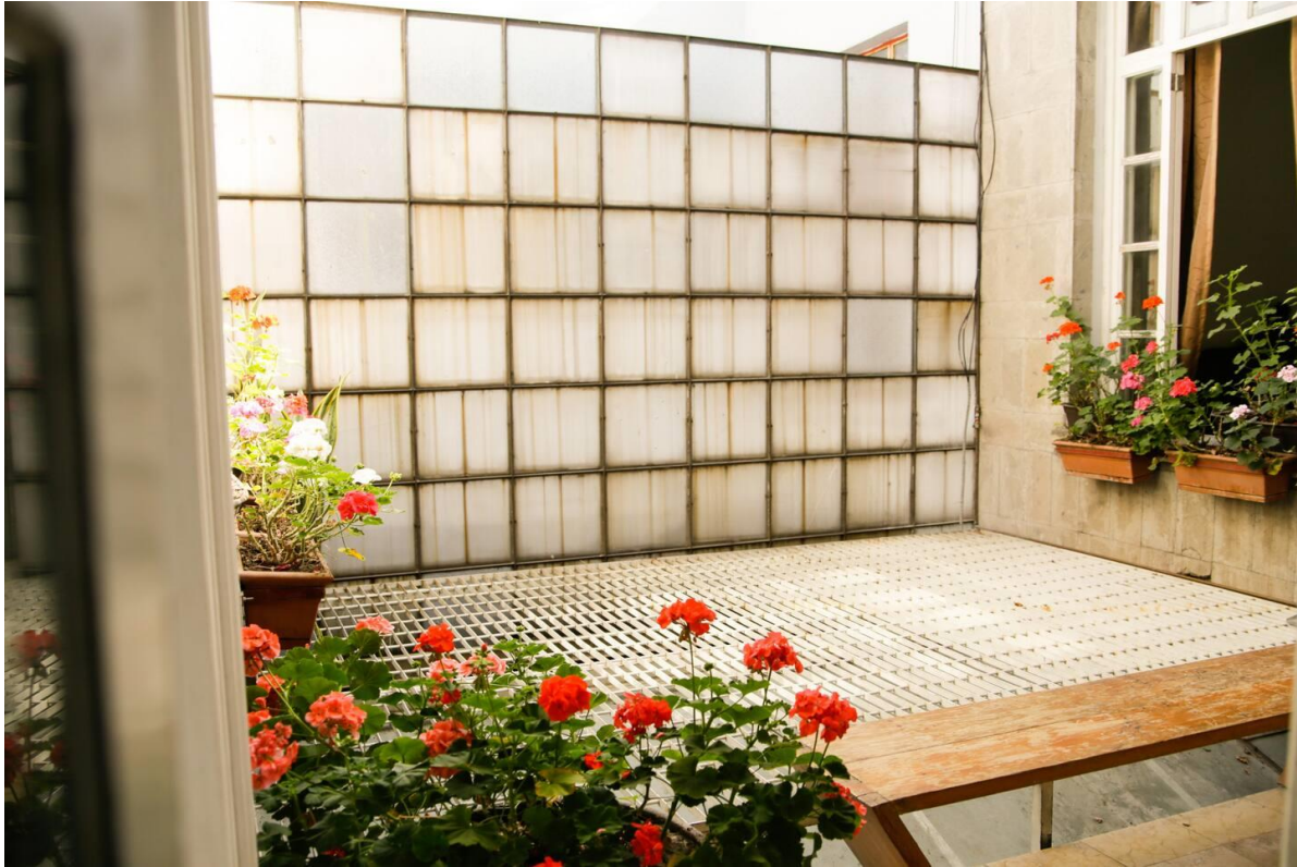
193. PATIO DE VENTILACIÓN (Adrián. 2020)
