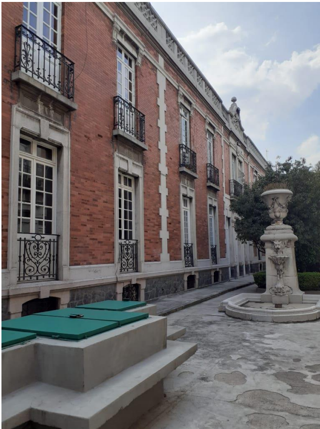
13.- FACHADA INTERIOR 2022 (Miranda S. 2022)
