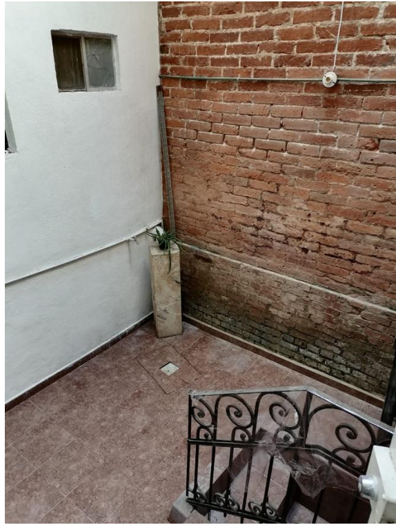
151. PATIO DE ILUMINACIÓN C13 (Miranda S. 2022)
