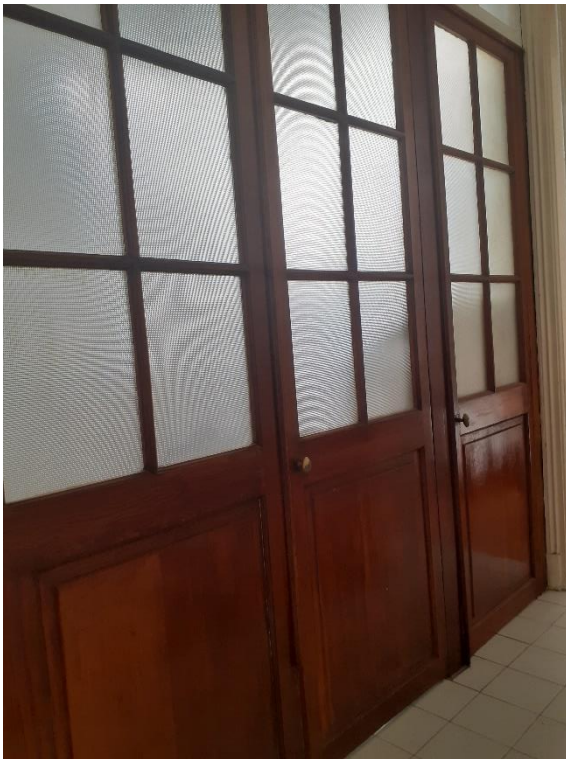
108. PUERTAS BAÑO C4 (Miranda S.2022)
