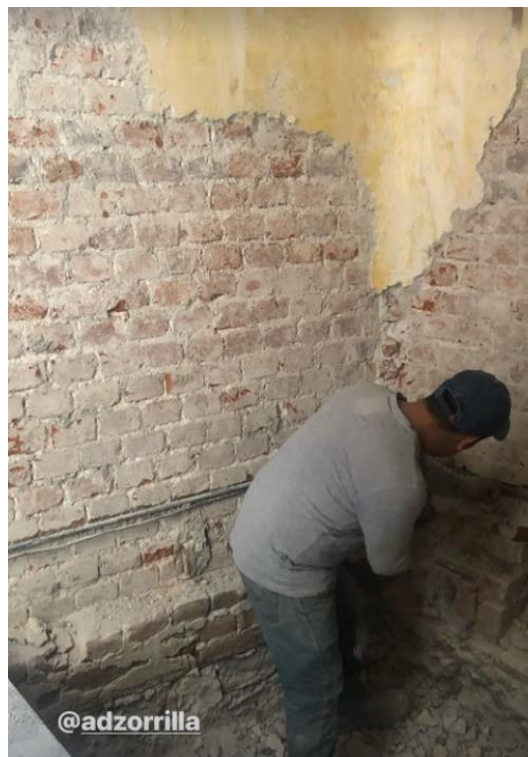
171. DESMANTELAMIENTO (Adriana Z. 2019)
