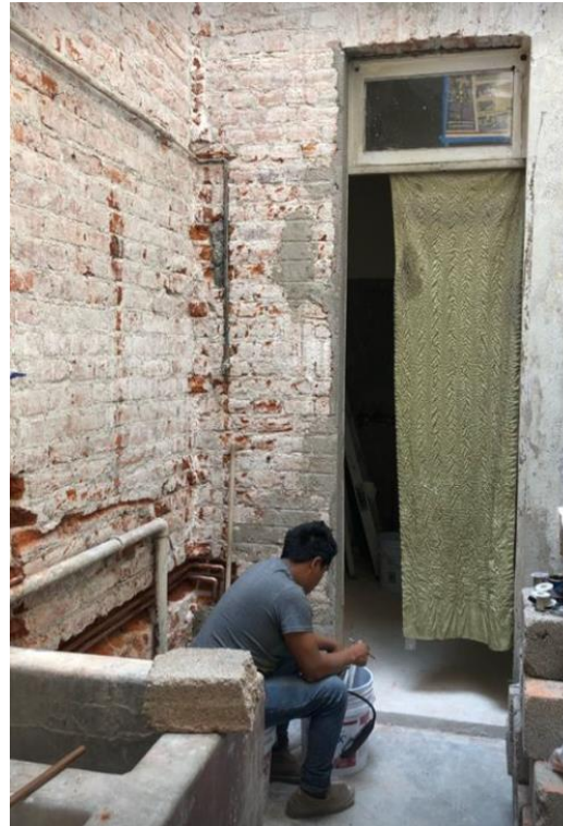
169. DESMANTELAMIENTO (Adriana Z. 2019)
