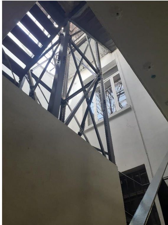
122. ACCESO/ANDADOR (Miranda S. 2022)
