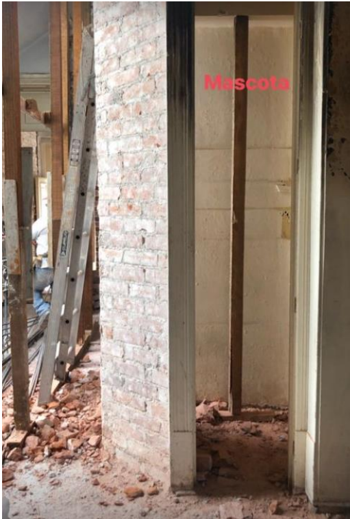
168. DESMANTELAMIENTO (Adriana Z. 2019)
