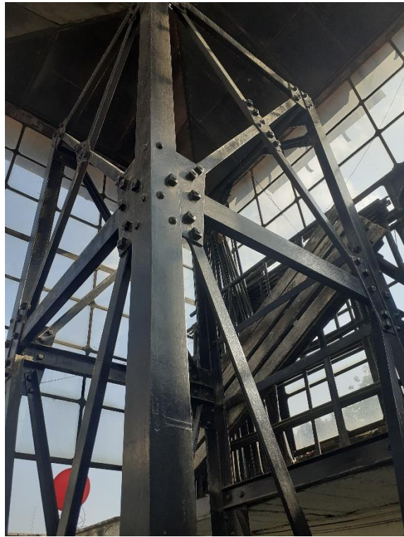
125. CUBO ESCALERAS (Miranda S. 2022)
