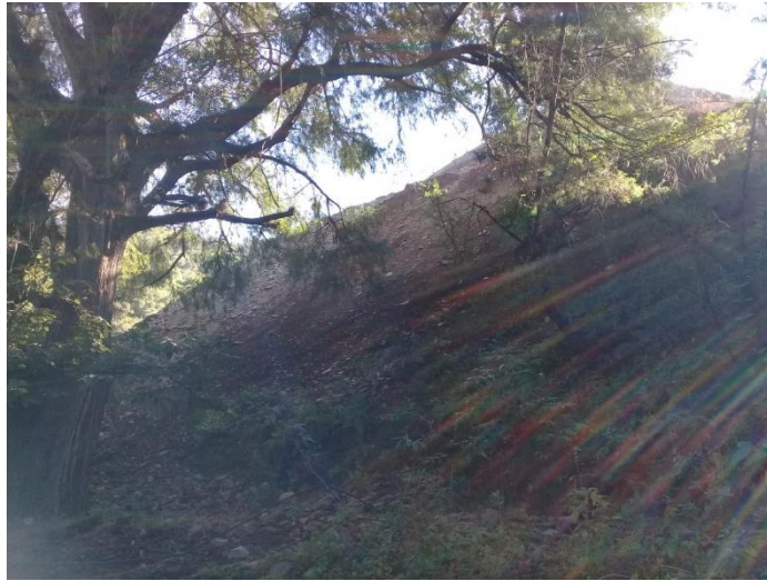
Imagen 4. Talud que da directo al río desde el jal El Fraile
