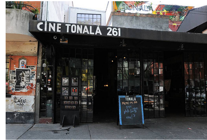
3.9 Fachada principal del centro cultural Cine Tonalá
