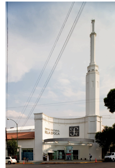
3.7 Fachada principal del centro cultural Bella Época
