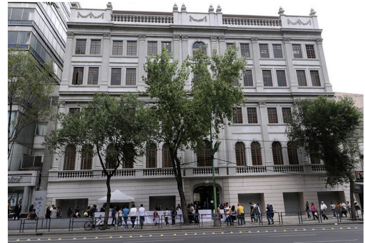
3.8 Fachada principal del centro cultural El Rule
