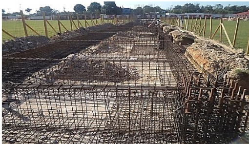
Cimentación para gradas
