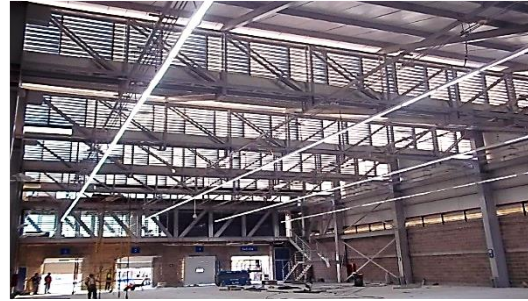
Vista de la cubierta al interior
