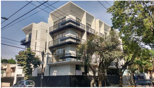
Vista general del edificio
