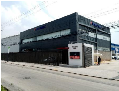
Vista general acceso principal
