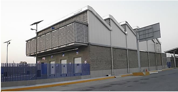
Vista general del almacén
