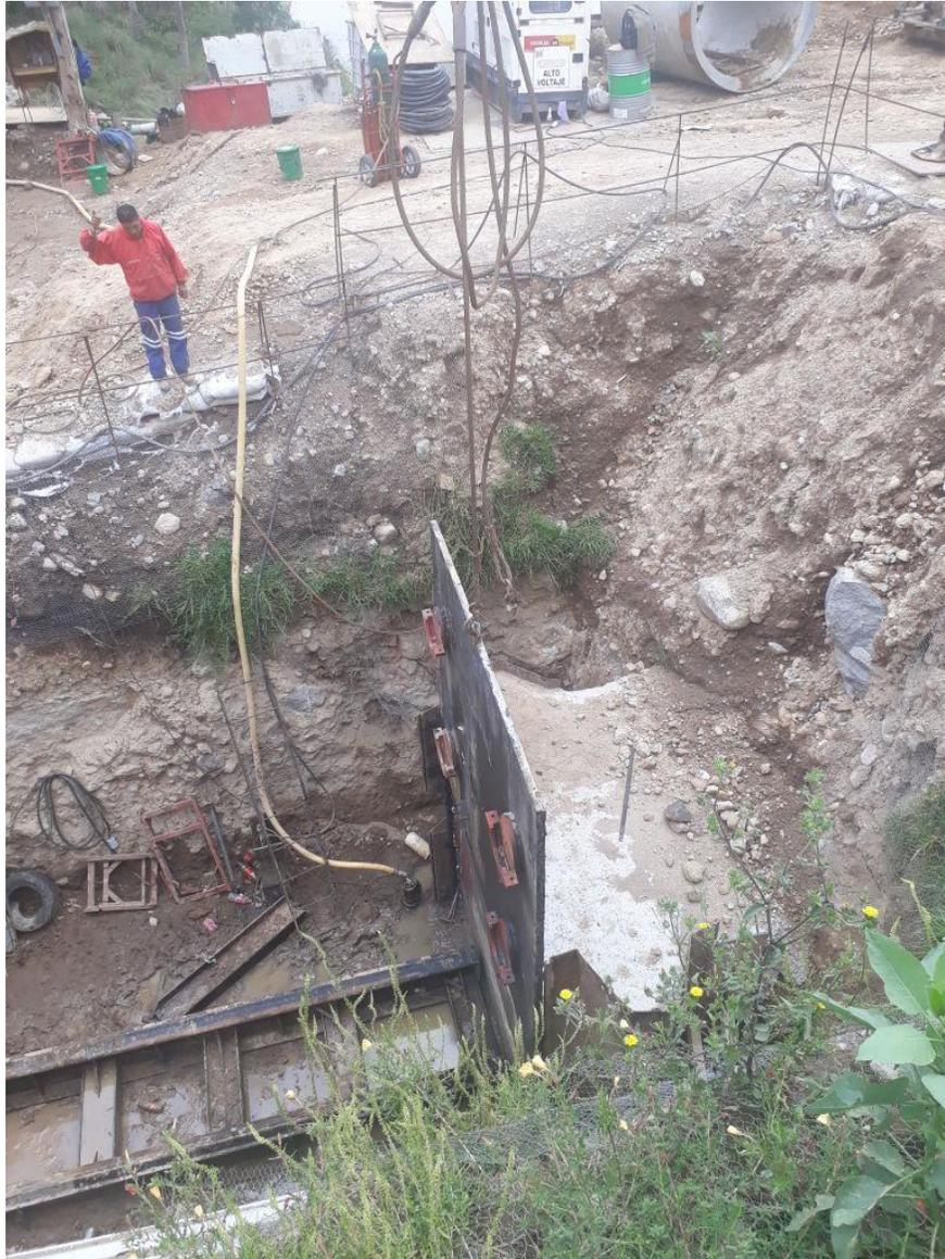
**Figura 6.4.10.b.** Desmantelamiento de lumbrera de empuje. Fuente: elaboración propia.
