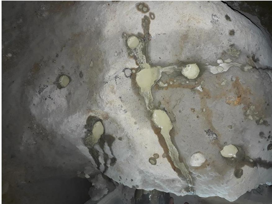
**Figura 6.6.2.d.** Aplicación de cemento expansivo. Fuente: elaboración propia.
