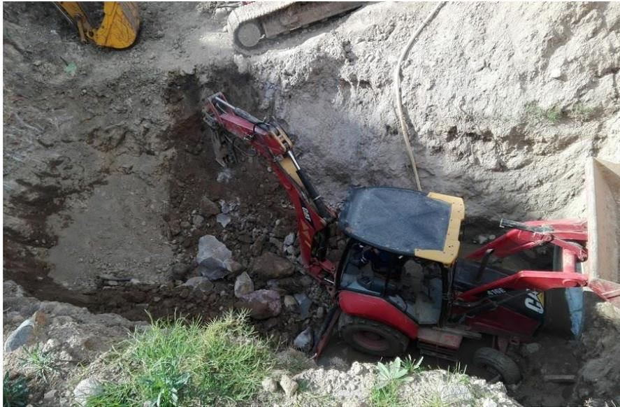
**Figura 5.4.2.f.** Continuación de la excavación de la lumbrera 4 con retroexcavadora. Fuente: elaboración propia.
