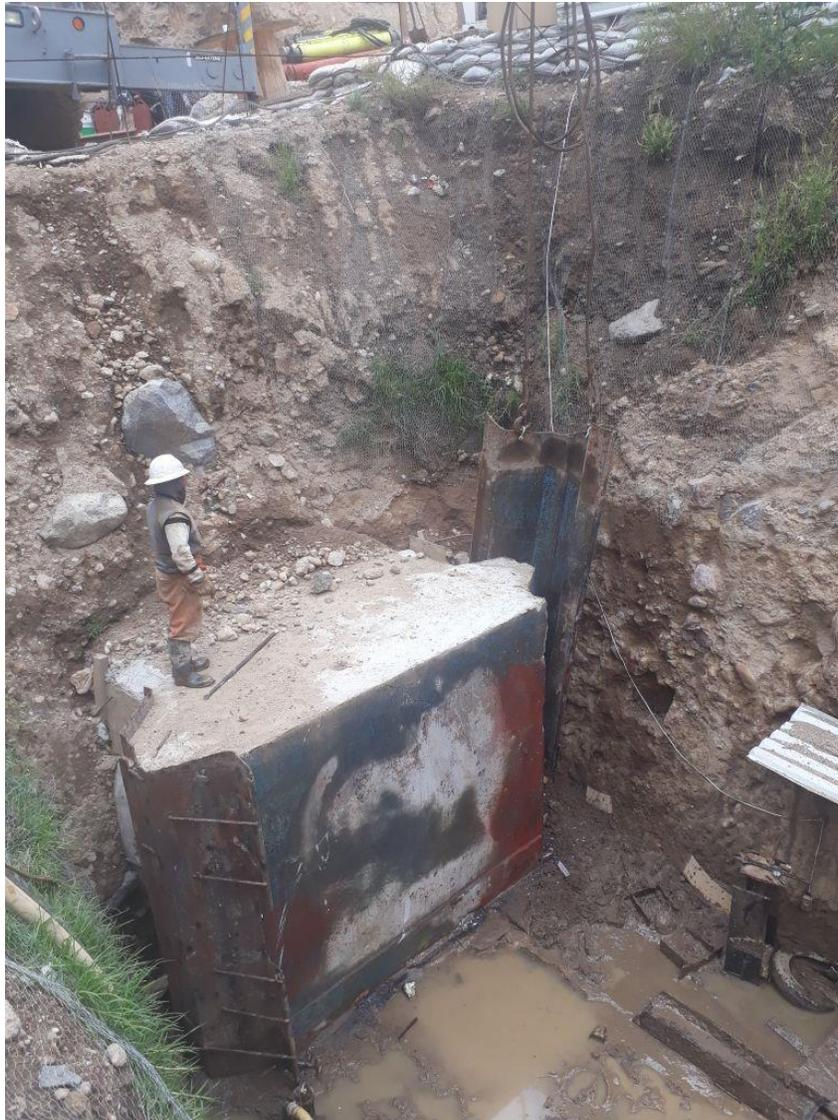
**Figura 6.4.10.c.** Desmantelamiento de lumbreira de empuje. Fuente: elaboración propia.
