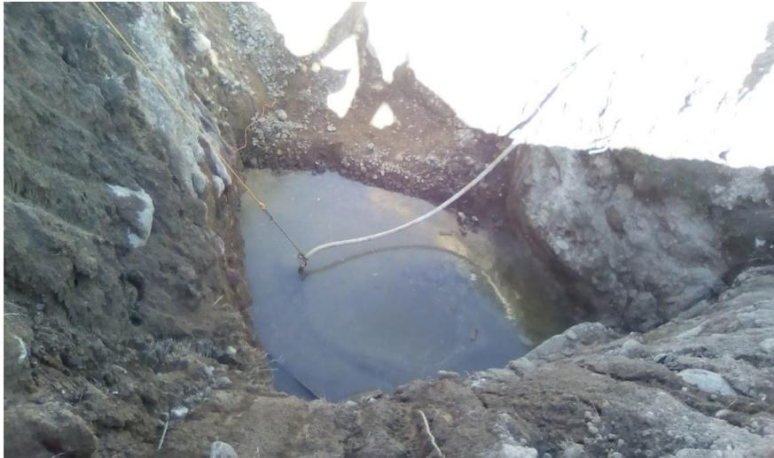
**Figura 5.4.2.g.** Expulsión de agua acumulada en excavación de la lumbreira de empuje. Fuente: elaboración propia.
