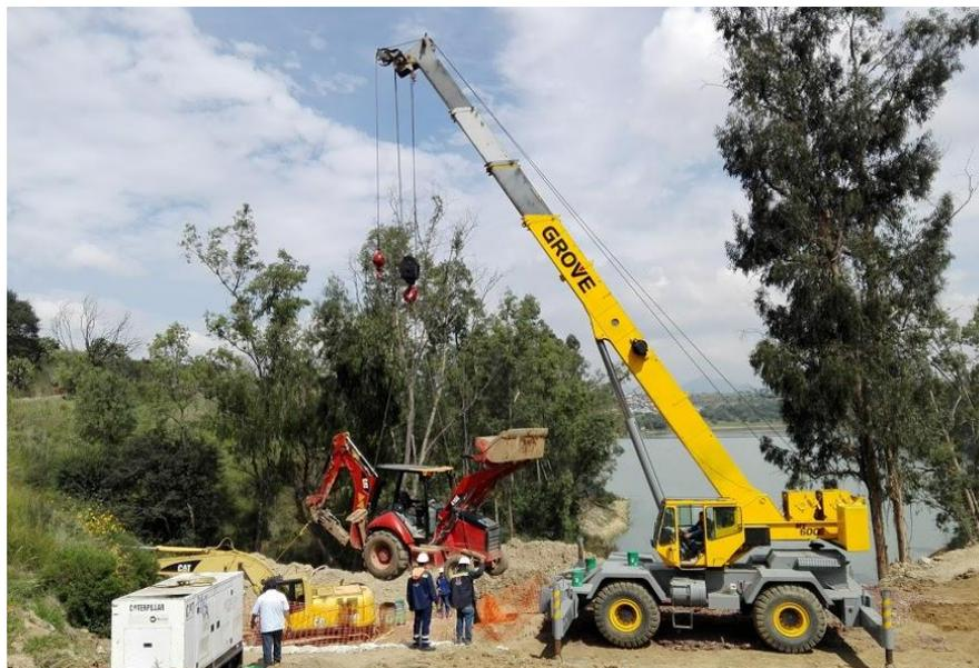
**Figura 5.4.2.e.** Se baja retroexcavadora para continuar excavación de lumbrera de empuje 4.
