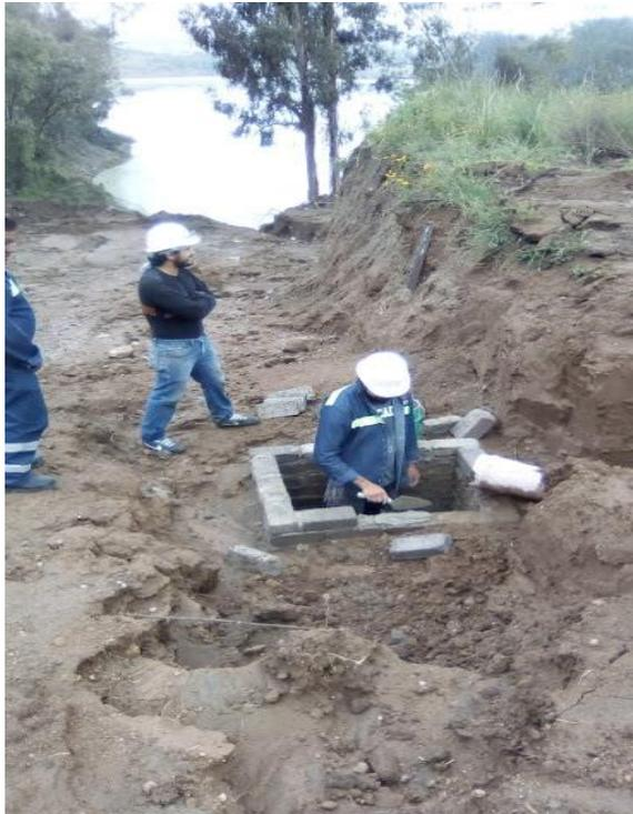
**Figura 5.e.** Construcción de registros para captar la precipitación pluvial. Fuente: elaboración propia.
