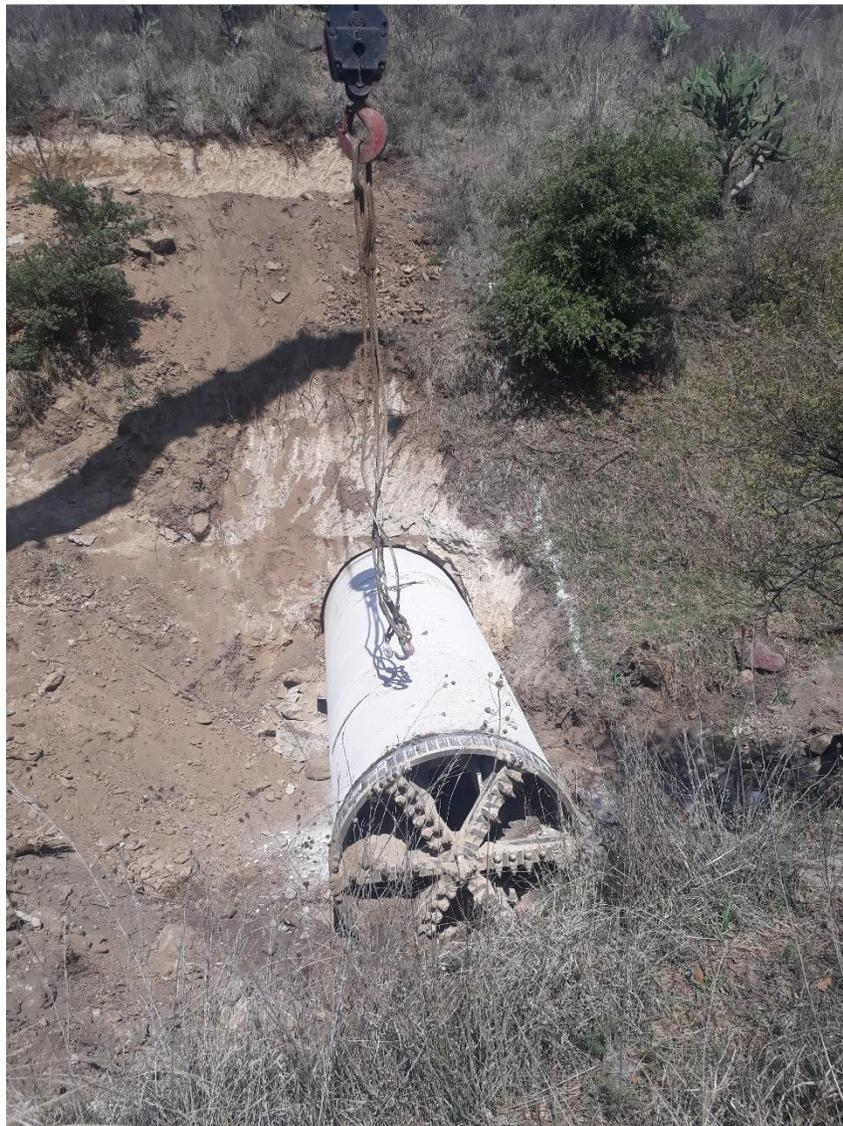
**Figura 6.4.9.b.** Retiro de escudo excavador del túnel. Fuente: elaboración propia.
