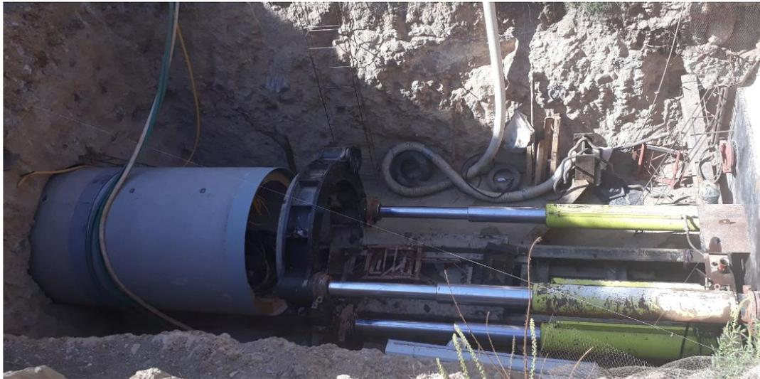
**Figura 6.4.6.b.** Retracción inicial de yoke y gatos telescópicos. Fuente: elaboración propia.
