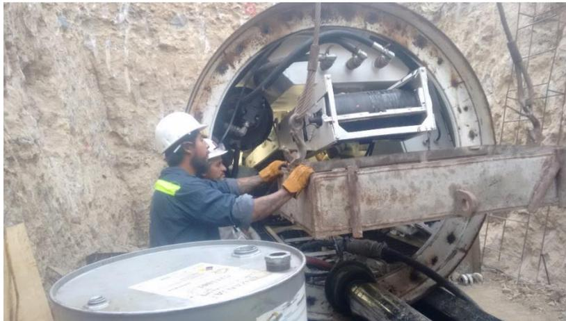
**Figura 6.4.3.c.** Acomodo de contenedor para recolectar material que comience a retirar la banda transportadora. Fuente: elaboración propia.
