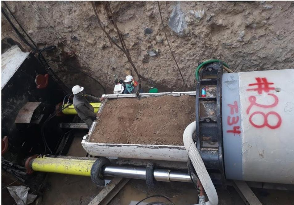
**Figura 6.4.5.a.** La tolva de material rezagado producto de la excavación se encuentra lista en la lumbrera de empuje para ser retirada por la grúa Groove. Fuente: elaboración propia.
