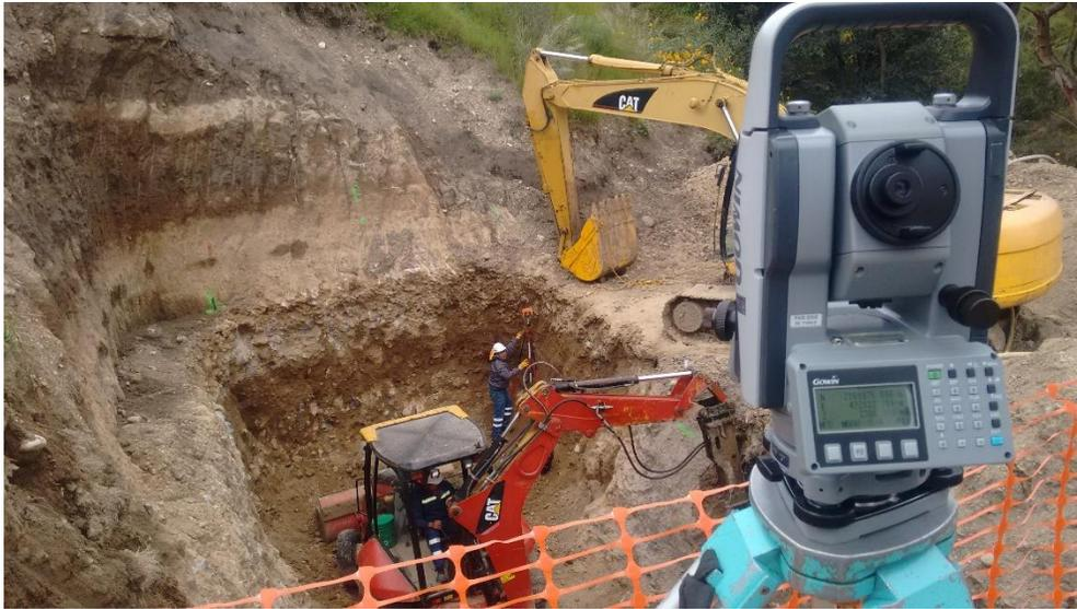
**Figura 5.4.2.k.** Vaciado de material excavado a orillas de la presa. Fuente: elaboración propia.
