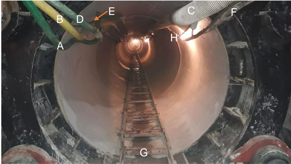
**Figura 6.4.4.a.** Localización de las ocho líneas elementales en el túnel. Fuente: elaboración propia.
