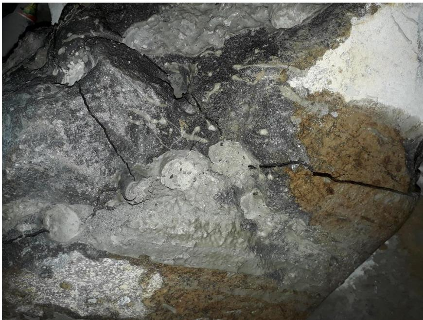
**Figura 6.6.2.e.** Roca fragmentada producto de la reacción del cemento expansivo. Fuente: elaboración propia.
