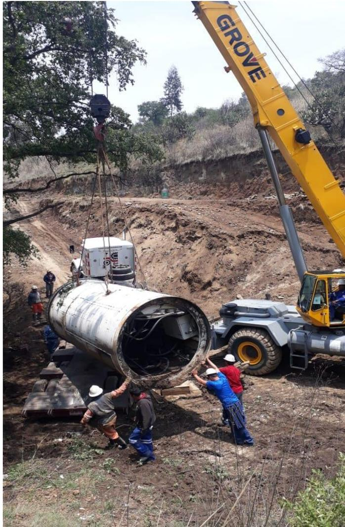
**Figura 6.4.9.c.** Maniobras para colocación de escudo en la plataforma. Fuente: elaboración propia.
