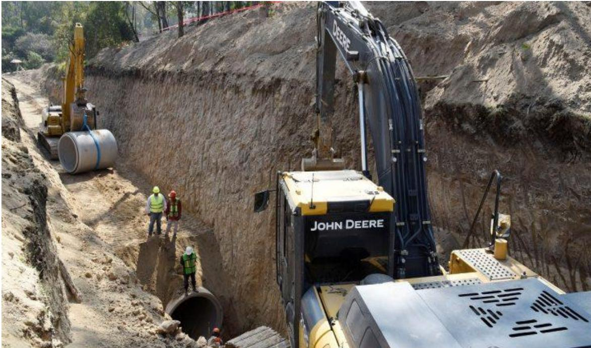
**Figura a.2.** Instalación de tubería a cielo abierto en tramo no recto. Fuente: elaboración propia.
