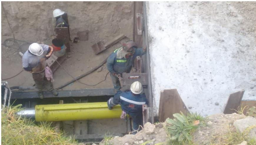
**Figura 6.4.3.b.** Colocación de gato telescópico detrás del escudo excavador. Fuente: elaboración propia.
