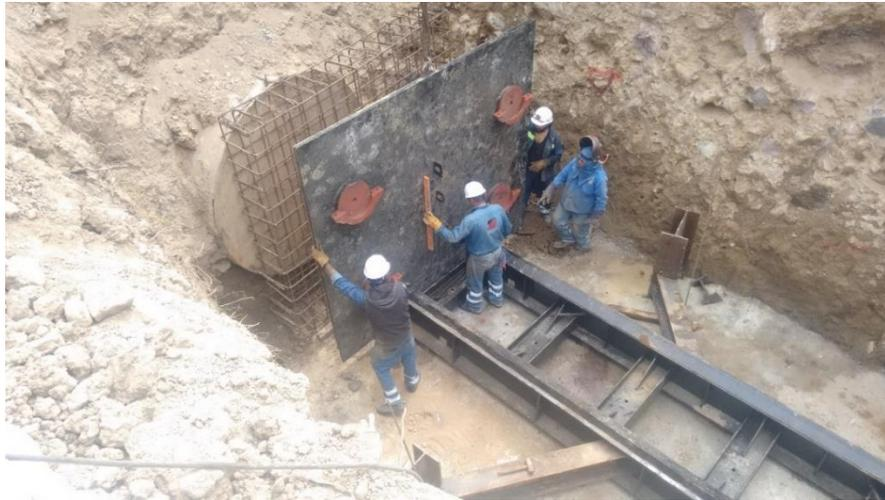
**Figura 5.4.4.c.** Colocación y alineación manual de la placa de soporte del muro. Fuente: elaboración propia.
