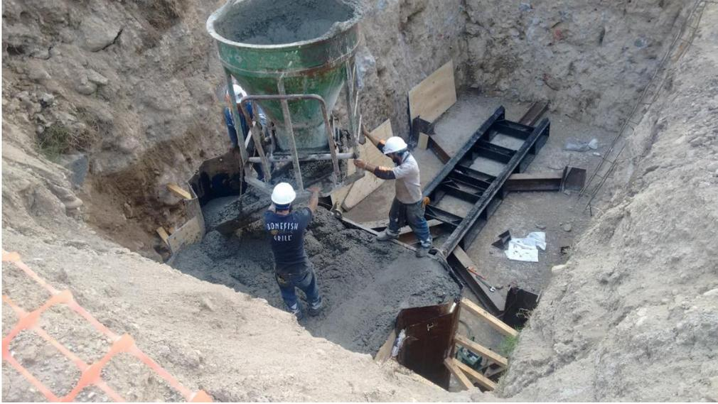
**Figura 5.4.4.f.** Vaciado de concreto premezclado en el muro de reacción. Fuente: elaboración propia.
