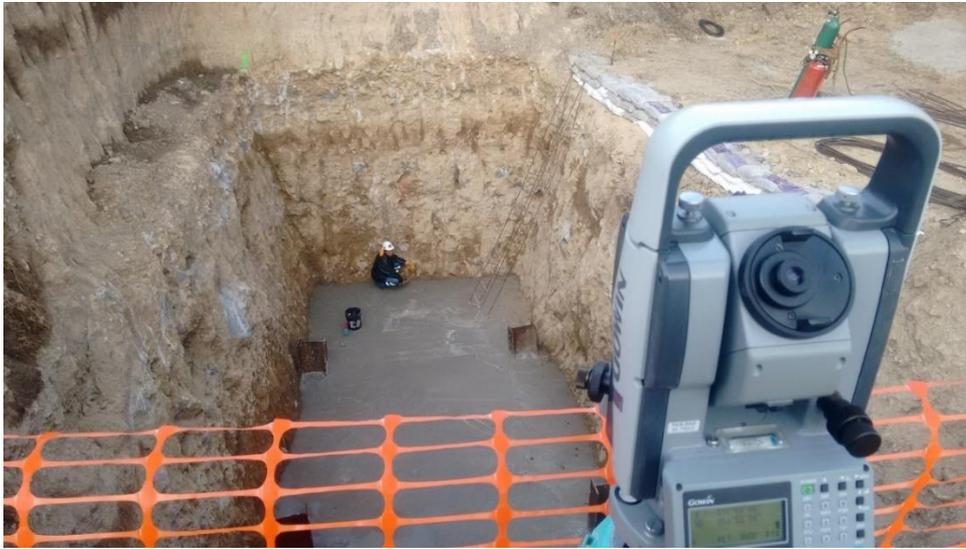
**Figura 5.4.3.c.** Revisión de los niveles de la losa de fondo con apoyo de la estación total. Fuente: elaboración propia.
