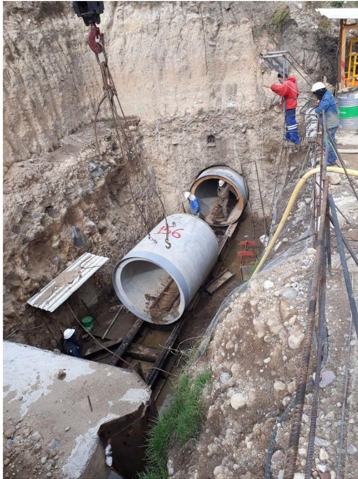
**Figura 6.4.10.d.** Retiro de tubería sobre la corredera. Fuente: elaboración propia.
