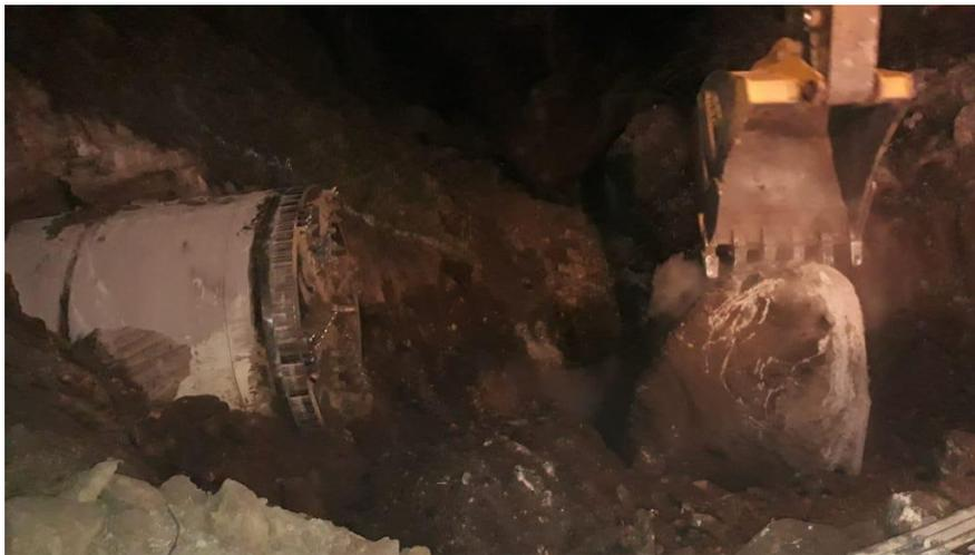
**Figura 6.4.9.a.** Retiro de rocas de gran diámetro por excavadora .Fuente: elaboración propia.
