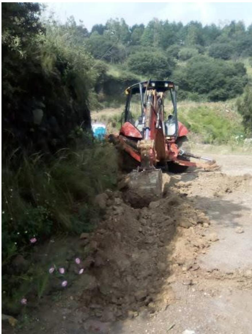
**Figura 5.d.** Excavación de zanjas por medios mecánicos. Fuente: elaboración propia.
