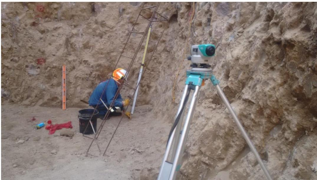
**Figura 5.4.3.a.** Revisión topográfica de los niveles de la losa de fondo de la lumbrera. Fuente: elaboración propia.
