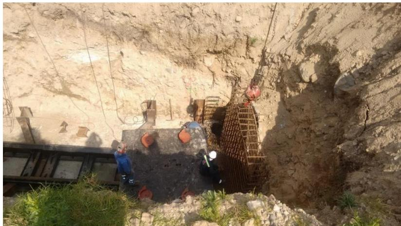
**Figura 5.4.4.b.** Colocación y alineación de acero de refuerzo del muro de reacción. Fuente: elaboración propia.
