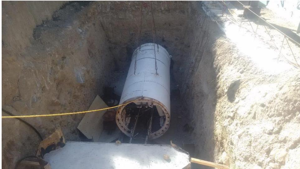
**Figura 6.4.3.a.** Se empotra escudo en respetando el eje delimitado por el topógrafo. Fuente: elaboración propia.
