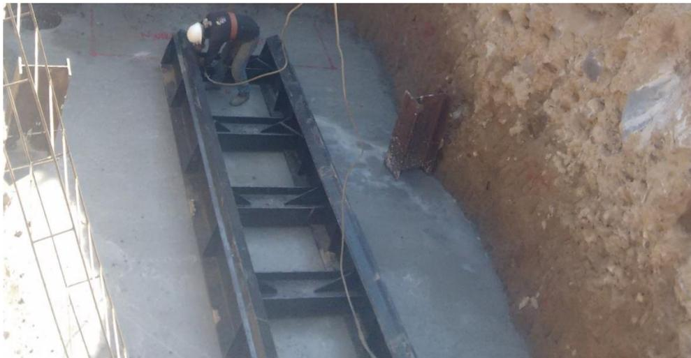
**Figura 5.4.3.f.** Se baja corredera a lumbrera de empuje del túnel 4. Fuente: elaboración propia.
