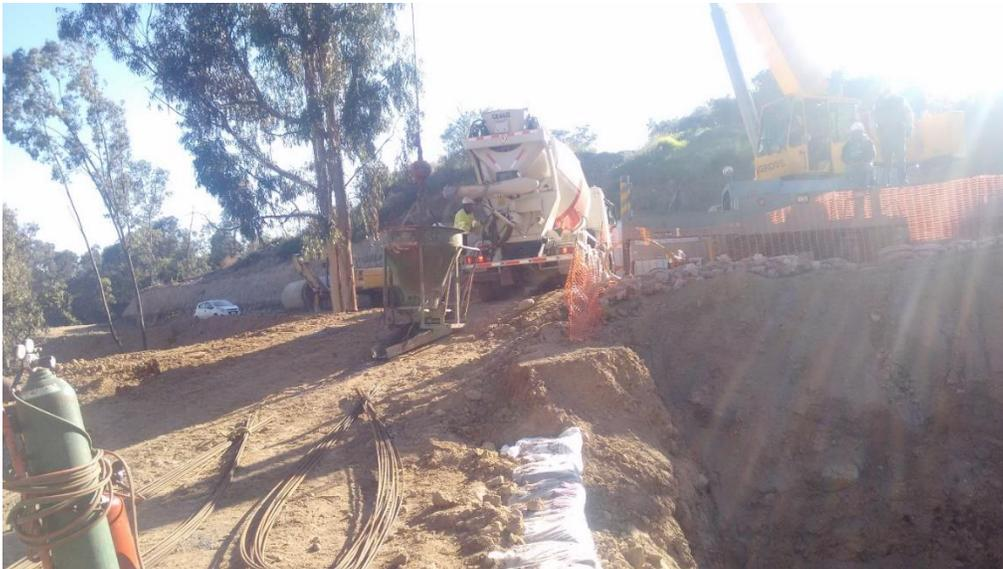
**Figura 5.4.4.e.** Suministro y traslado de concreto mediante tolva. Fuente: elaboración propia.
