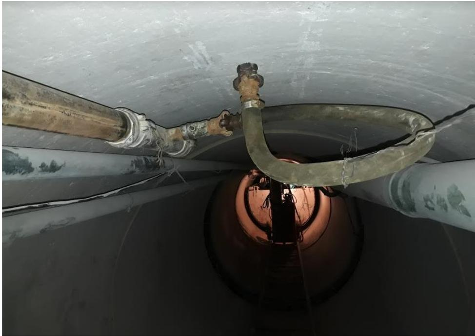
**Figura 6.4.8.a.** Salida del lodo bentonítico hacia el espacio anular .Fuente: elaboración propia.
