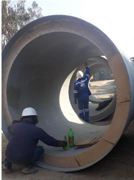
**Figura 6.4.1.b.** Habilitado de tubería de concreto en superficie. Fuente: elaboración propia.
