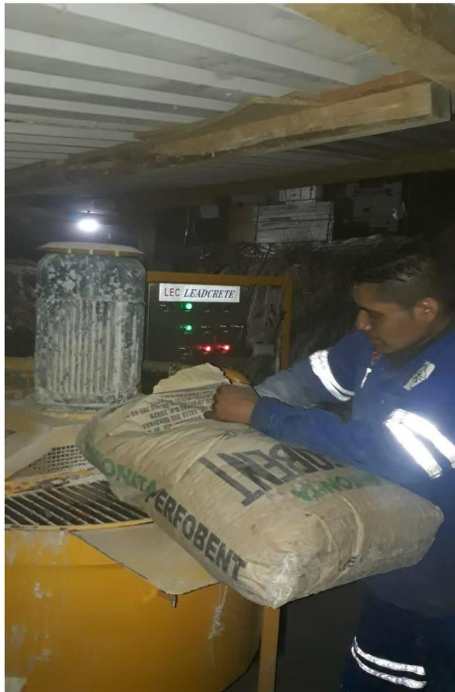
**Figura 6.4.8.c.** Preparación y dosificación de lodo bentonítico. Fuente: elaboración propia.
