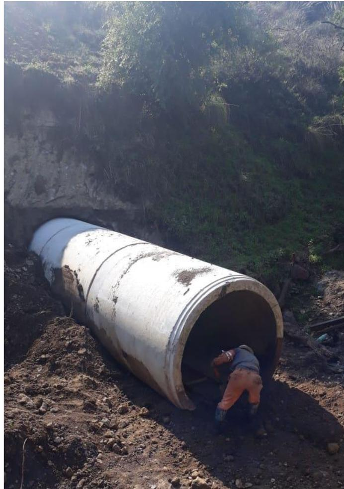
**Figura 6.4.9.d.** Preparación de tubos para conexión de túnel 3. Fuente: elaboración propia.
