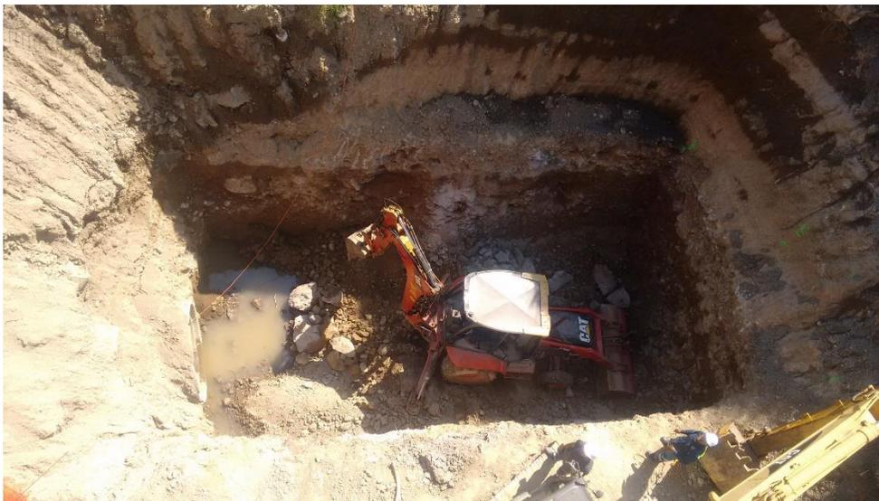
**Figura 5.4.2.l.** Perfilado de muros de la lumbrera de empuje. Fuente: elaboración propia.
