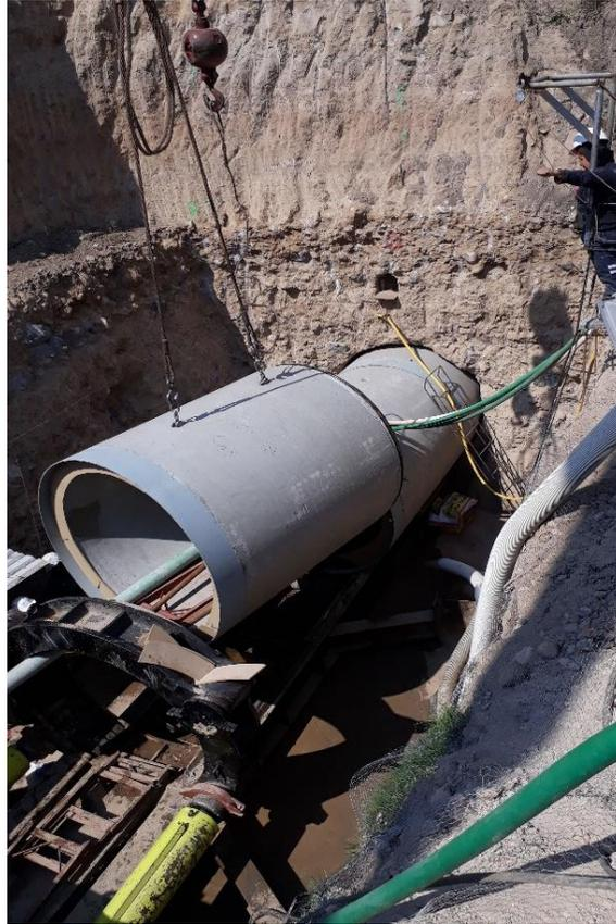
**Figura 6.4.6.d.** Adaptación de nuevo tubo de concreto al sistema actual. Fuente: elaboración propia.
