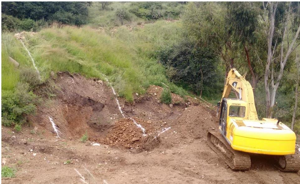
**Figura 5.4.1.c.** Perímetro efectivo de la lumbrera de empuje. Fuente: elaboración propia.
