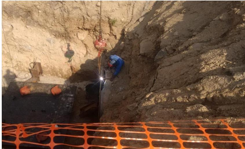
**Figura 5.4.3.e.** Se suelda “comal” de la boca de del último tramo de tubería instalada a cielo abierto. Fuente: elaboración propia.
