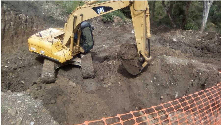
**Figura 5.4.2.d.** Proceso de excavación de la lumbrera 4. Fuente: Elaboración propia.
