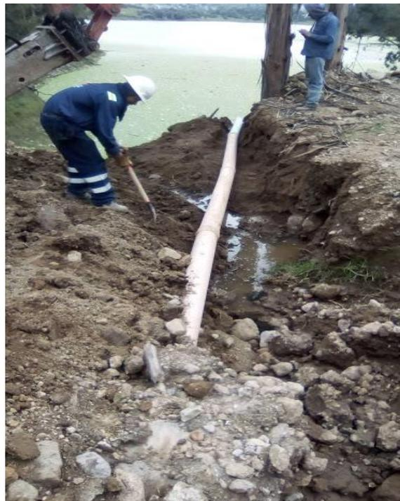
**Figura 5.f.** Desvío de ducto de PVC a pie de la presa Guadalupe. Fuente: elaboración propia.
