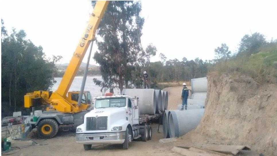
**Figura 6.4.1.a.** Suministro y acomodo de tubería de concreto. Fuente: elaboración propia.
