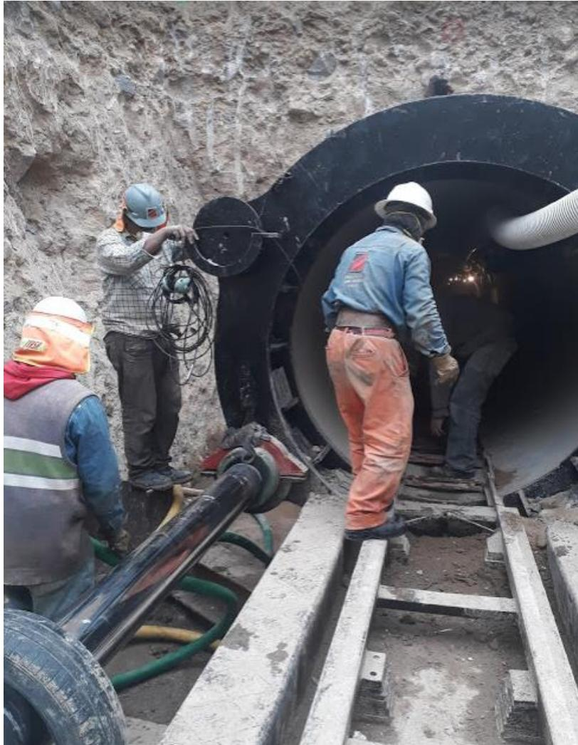
**Figura 6.4.6.a.** Desconexión de líneas principales del escudo. Fuente: elaboración propia.
