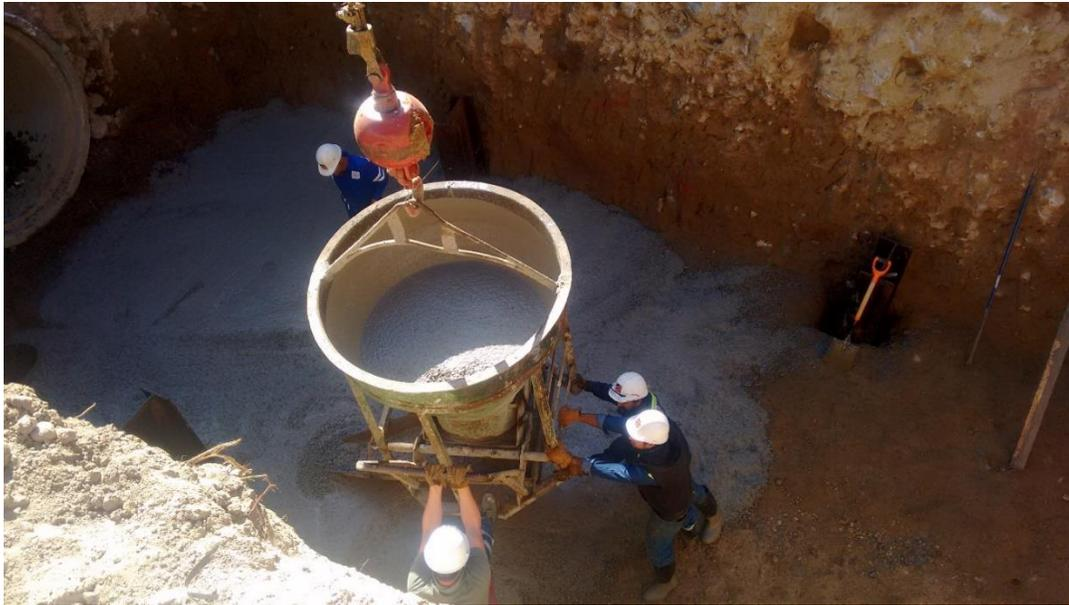
**Figura 5.4.3.b.** Supervisión del colado de la losa de fondo de la lumbrera de empuje del túnel 4.
