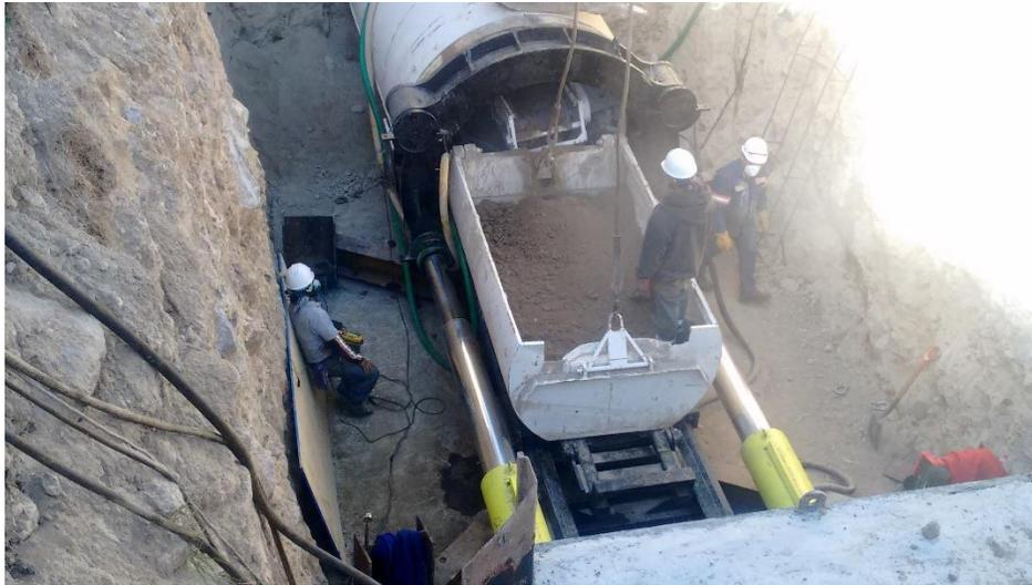
**Figura 6.4.3.d.** Recolección de material excavado para el llenado de la primera tolva. Fuente: elaboración propia.
