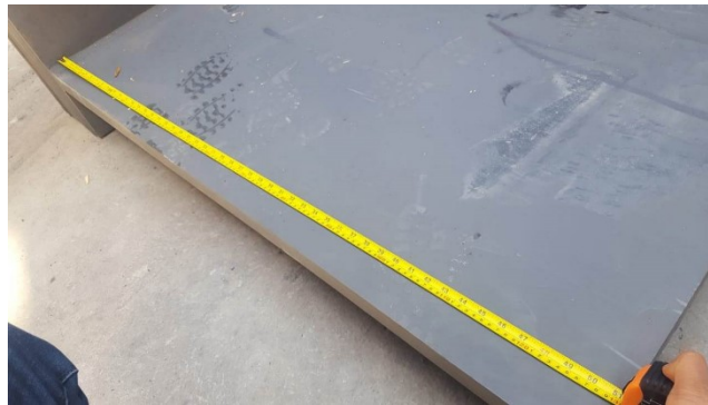
Figura 1.24 Detalles marcados en rojo , cota requerida por proyecto estructural 1500 mm y en físico tiene 1300 mm FUENTE : Detalles marcados por supervisión indicados posición donde se encuentran los problemas Obra Ciudad de México .
