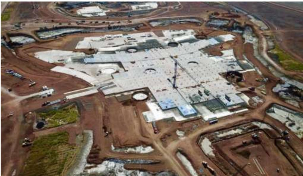
*Imagen 3.16, Avance de la Losa de Cimentación en el Edificio Terminal del NAICM.
