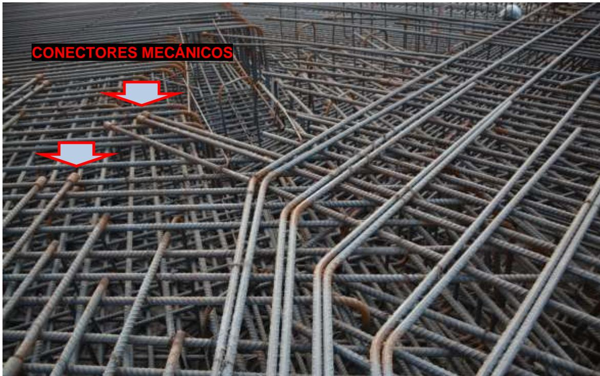
*Imagen 3.12, Armado Superior de Sub-Losa*
