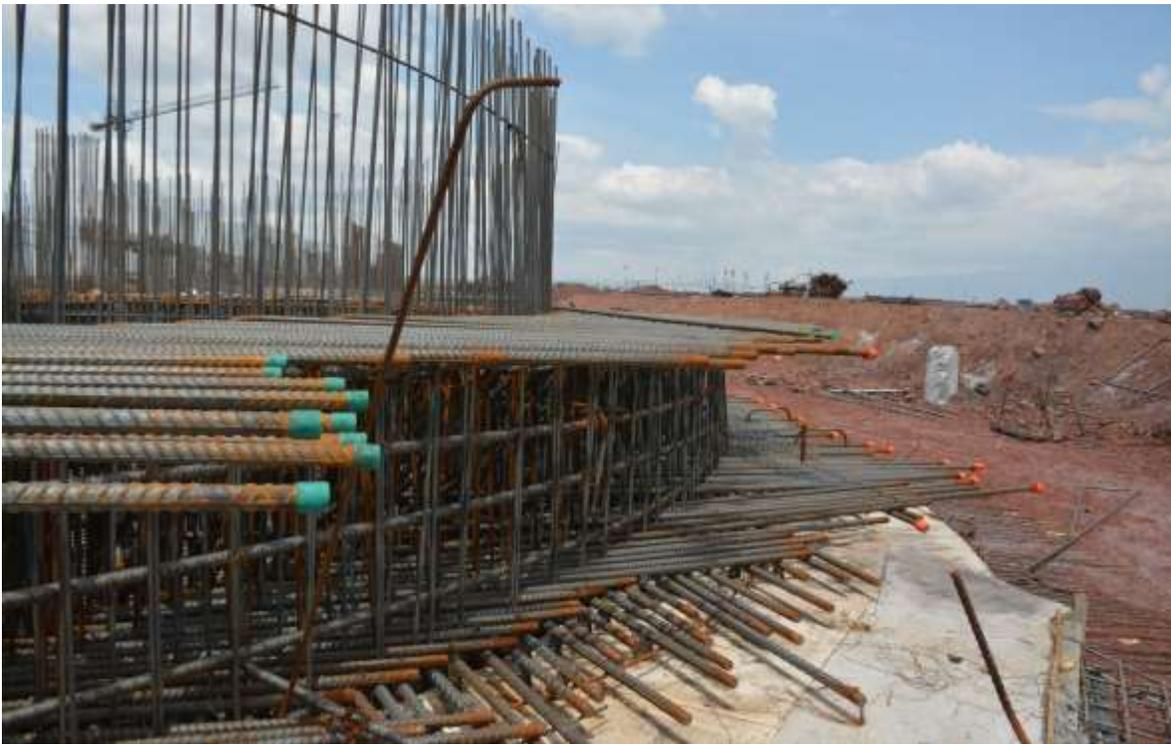
*Imagen 3.6, Corte de Rellenos y Perfil de un Armado de Losa para Fonil.*
