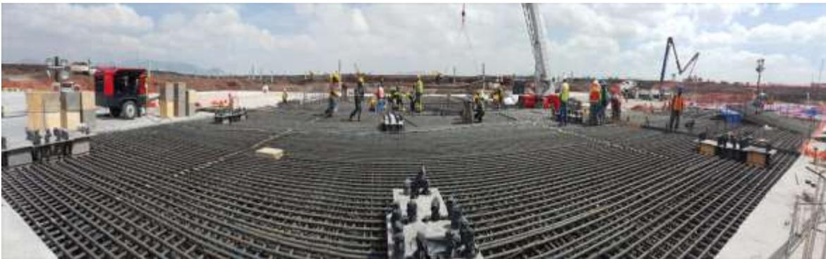
*Imagen 4.6, Armado de Forma en Losa*
