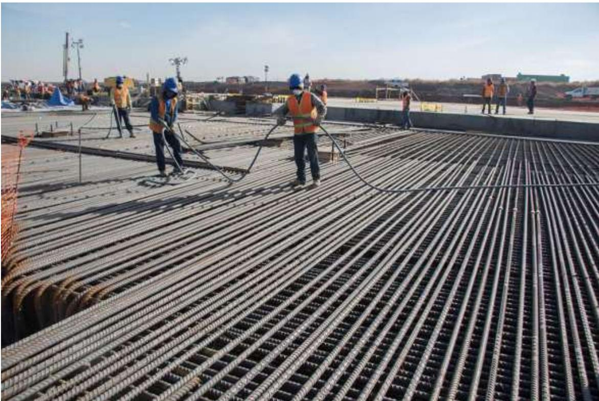
*Imagen 3.17, Armado de Losa y Limpieza para Colado*
