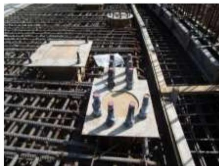
*Imagen 3.24, Ejemplo de Anclas de Losa Unitaria para Columna Principal (Imagen Izquierda), y Columna Secundaria (Imagen Derecha).*
