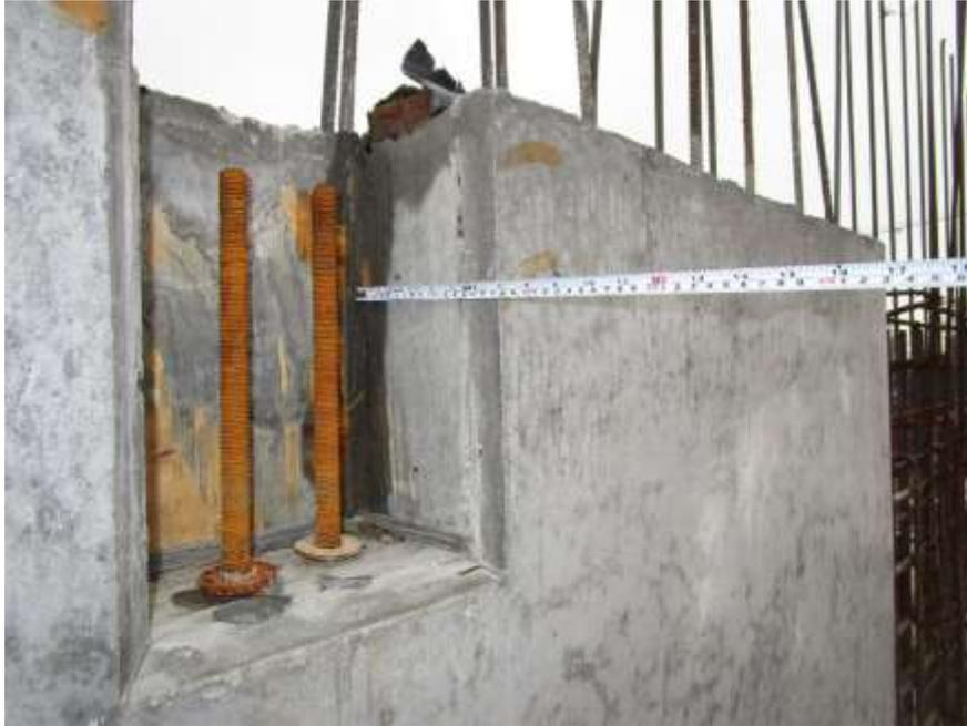
**Imagen 3.27,** Anclas de Anclaje para Trabes de Entrepiso con Muro Perimetral de la Losa del NAICM.
