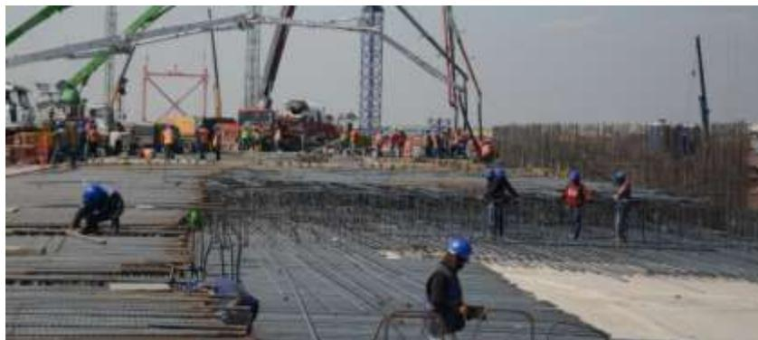
*Imagen 3.8, Colocación de Losas de Cimentación sobre capa de Impermeabilizante.*
