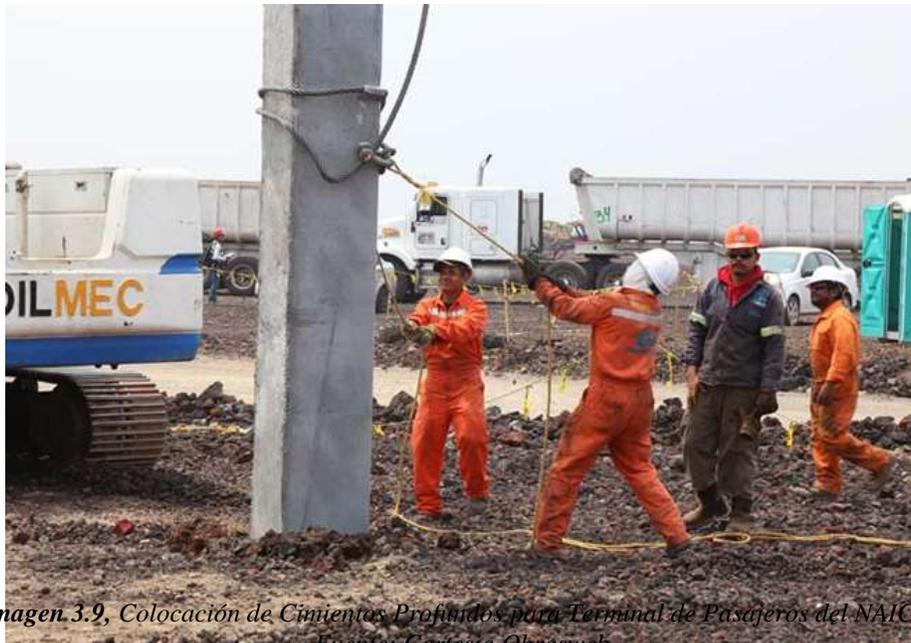
*Imagen 3.9, Colocación de Cimentas Profundas para Terminal de Pasajeros del NAICM.
