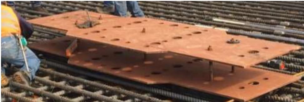
*Imagen 3.24, Ejemplo de Placa Base Tipo, para Anclas de Losa Unitaria #151.
