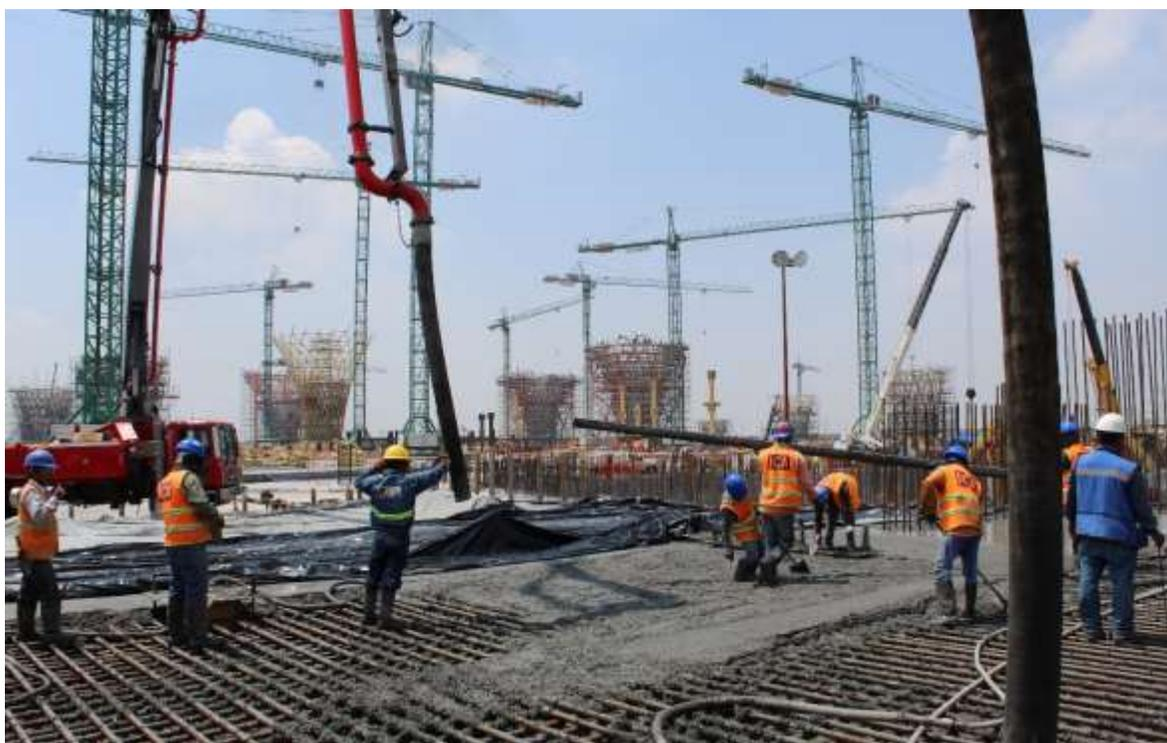
*Imagen 3.11, Suministro de Concreto en la última Sub-Losa colada de la Losa de Cimentación del NAICM.*
