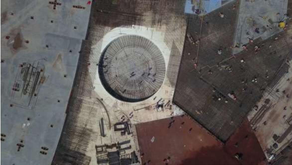
*Imagen 3.15, Armado en diferentes direcciones en losas unitarias del Edificio Terminal del NAICM.
