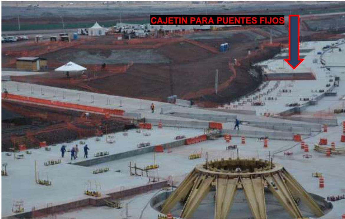
*Imagen 3.18, Losa de Cimentación con Proceso de Armado de un Fonil y Cajetines preparados para Puentes Fijos.*
