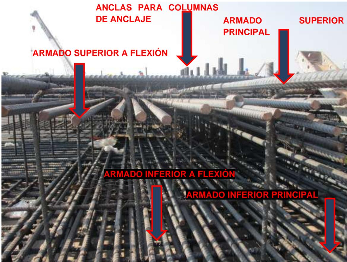
*Imagen 3.13, Armado de Sub Losa de Cimentación.*
