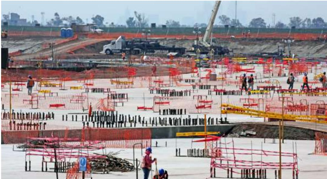
*Imagen 3.25, Vista al Sur de la Losa de Cimentación de la Terminal.
