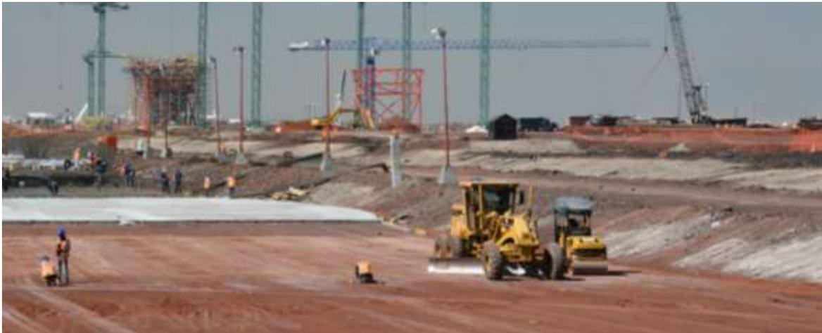
*Imagen 3.4, Nivelaciones y Compactaciones en el Terreno junto a Talud de Proyecto.*
