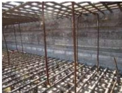
**Imagen 3.23,** Junta Constructiva en Sub Losa de Cimentación del NAICM.
