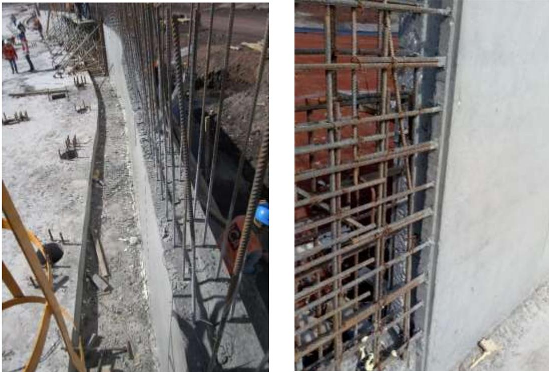
**Imagen 3.22,** Junta Constructiva en Muro de forma Vertical en Muros Perimetrales de la losa de Cimentación del NAICM.
