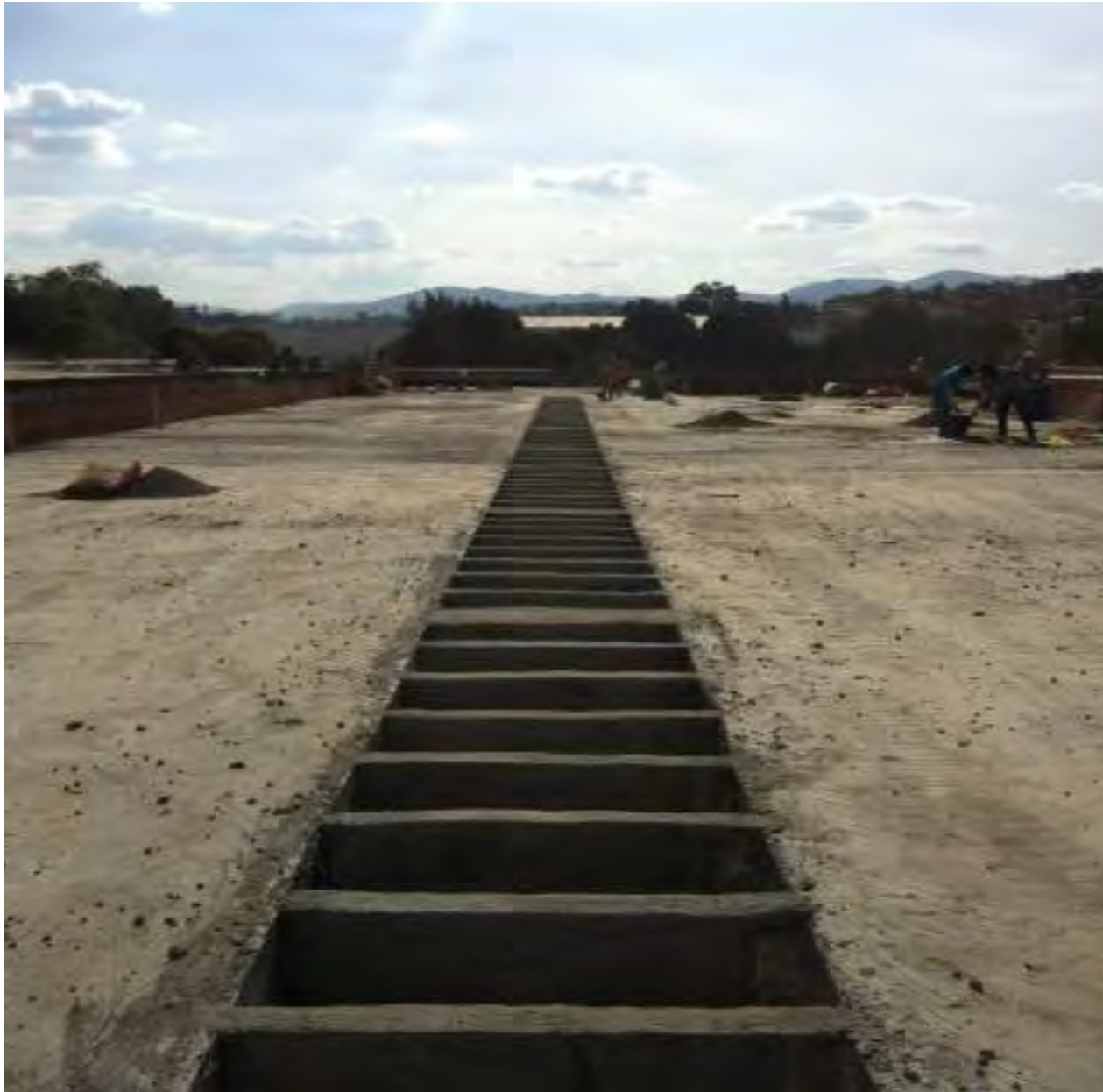
Fotografía de la losa ya colada y fraguada del edificio B, en donde se aprecian las nervaduras sin casetones que permiten el paso de la luz a través de domos de cristal posteriormente a colocar.
