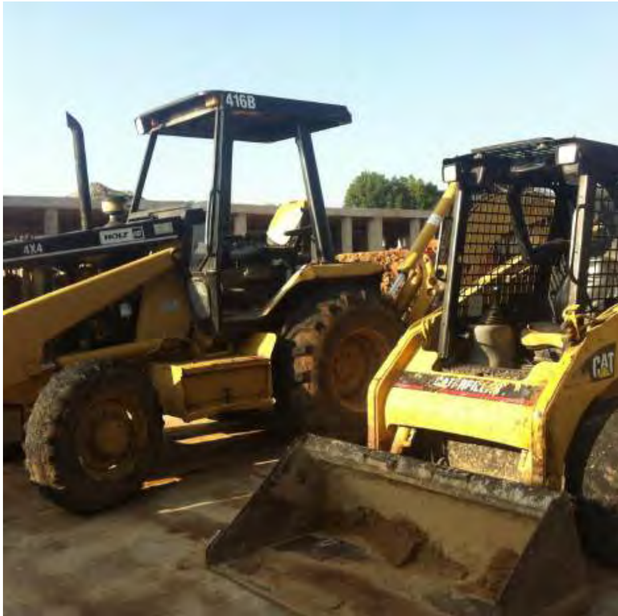
Fotografía de retroexcavadoras utilizadas para la etapa de limpieza del terreno, movimiento de cascajo, y apertura de cepas para la cimentación.
