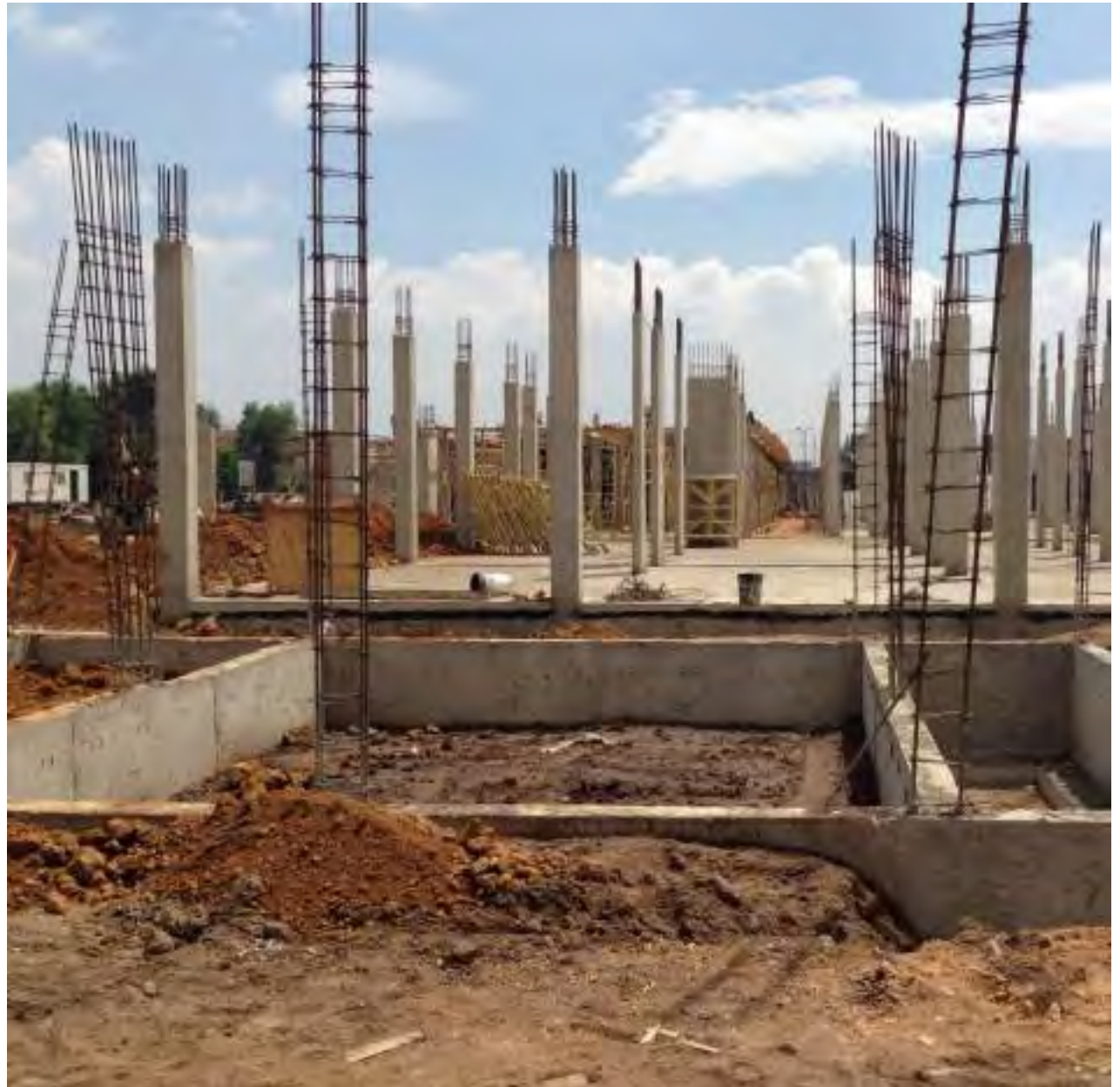
Fotografía mostrando el relleno de cepas con tierra compactada en capas de 20 centímetros. Se aprecia el armado de las futuras columnas que darán pie al edificio.
