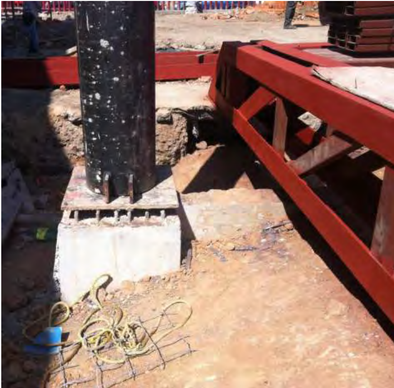
Fotografía de la contratrabe de concreto que se unió mediante una soldadura a la columna metálica y de sección circular que soportará la armadura del edificio A.
