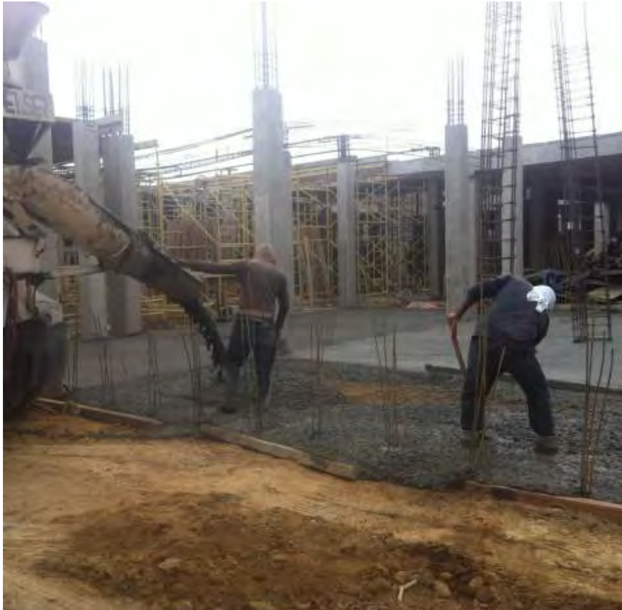
Fotografía del colado de un firme de concreto en donde vemos la olla de concreto de parte de Gelser liberando el material a la zona cimbrada, sin embargo, se aprecia el descuido al cimbrar el perímetro de este firme.
