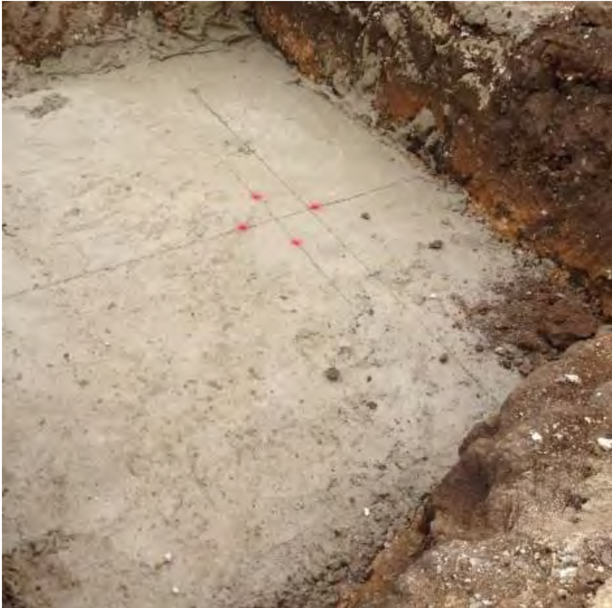
Fotografía del firme de la cepa de una de las zapatas aisladas, señalando con rojo el eje del fuste de la misma.
