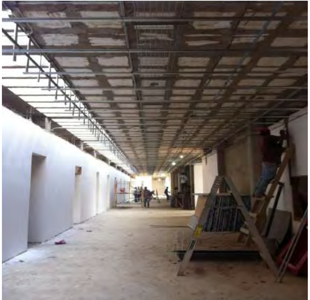
Fotografía en la que se aprecian los muros enyesados del corredor de consultorios del edificio B. Además, se aprecia la estructura de aluminio que soportará el plafón de yeso y cubrirá la holgura de instalaciones.
