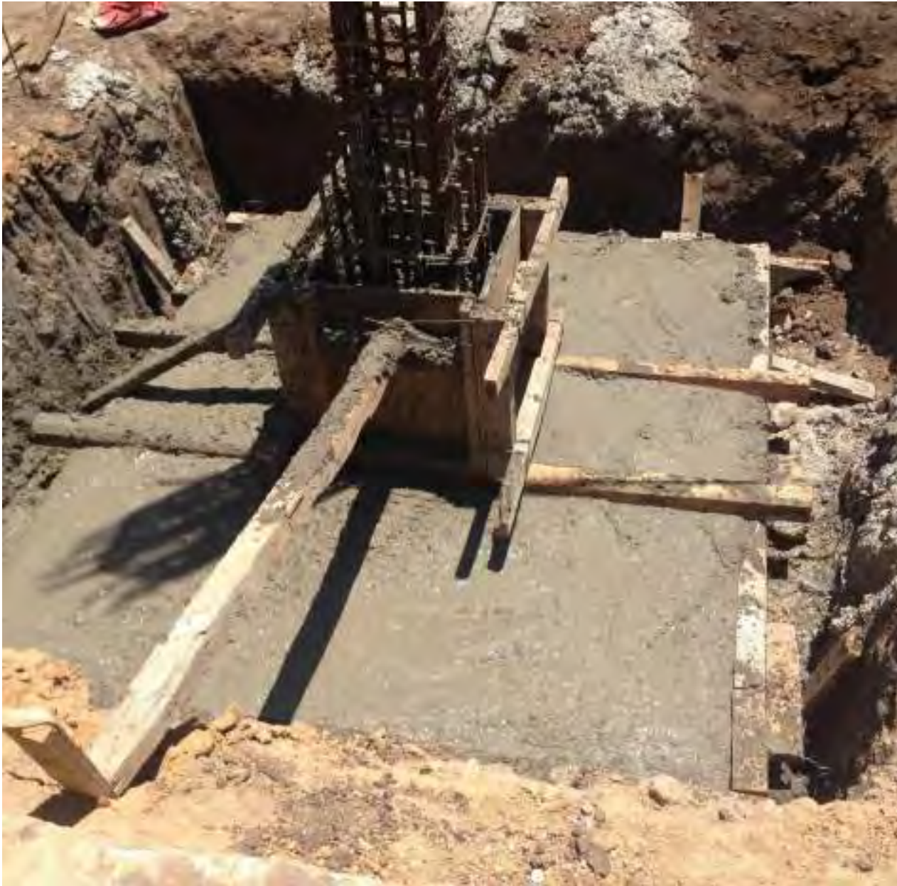
Fotografía de zapata de concreto armado ya colada definida por la cimbra anteriormente construida. La cimbra se retirará hasta que el concreto termine de fraguar.
