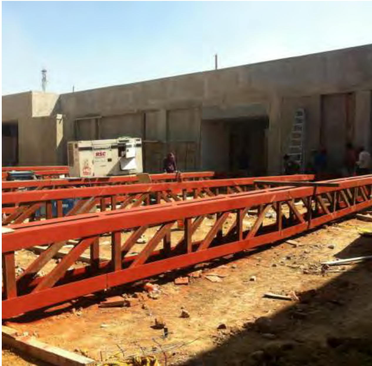
Fotografía de la armadura metálica que conforma la losa del edificio A. También se puede apreciar la planta de luz temporal para los trabajos necesarios de electricidad.
