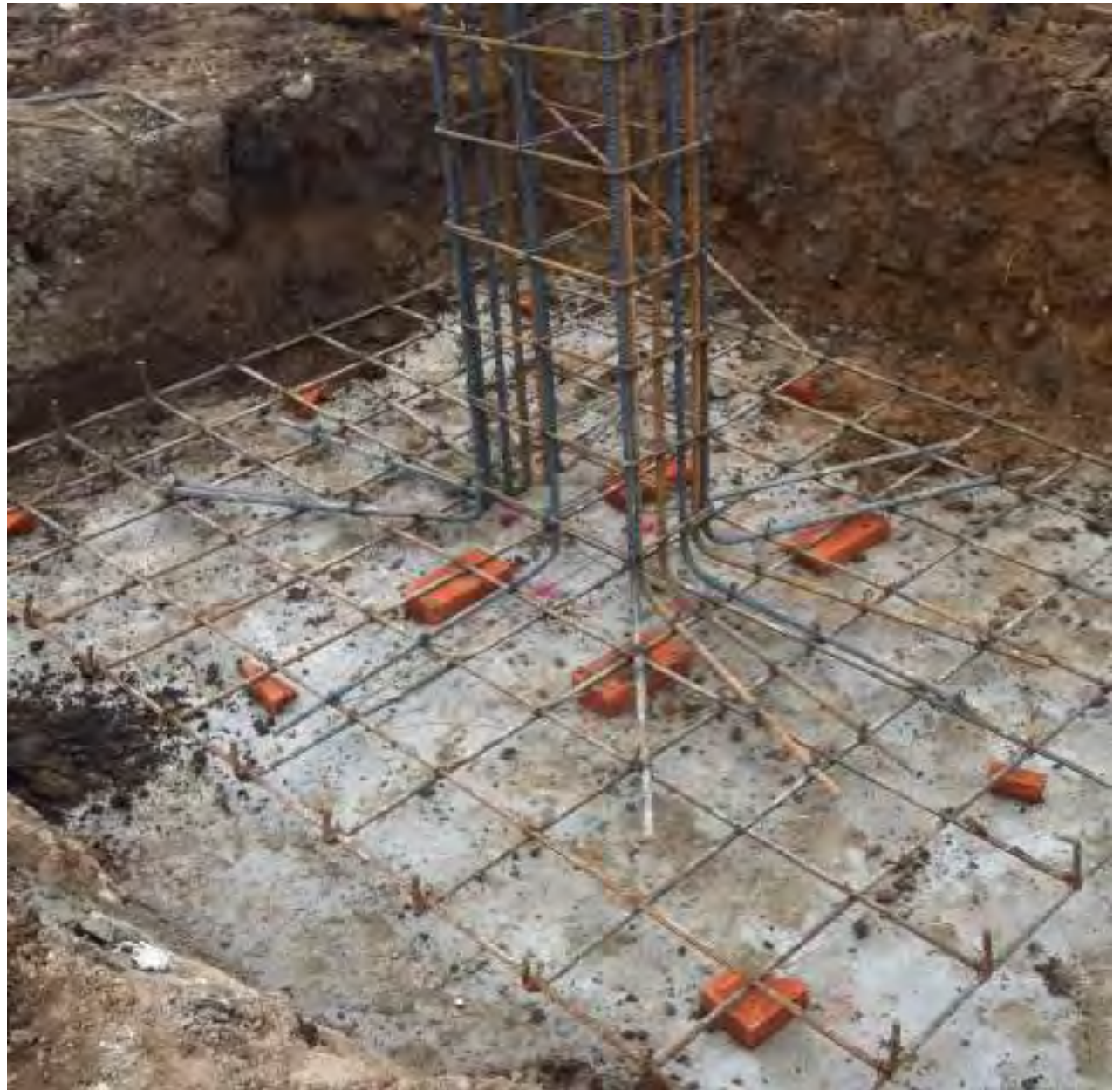
Fotografía de cepa para zapata asilada, en la que se aprecia el armado de varillas y bastones de la base y el fuste, además de la separación por norma que tiene que existir entre el armado, el concreto y la superficie.
