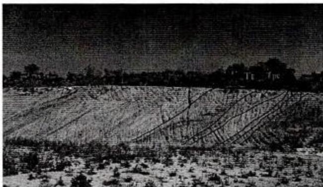
**Fotografía 14.** Vista frontal del talud ubicado enfrente del talud analizado en la Av. Vasco de Quiroga, donde se observa una secuencia pseudo-estratificada piroclástica de eventos volcánicos constituidos por depósitos de lahar y tobas líticas en el talud.
