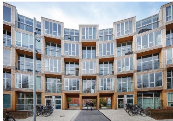
Gráfico 24. Vista de la fachada con el portal peatonal-ciclista y las cicloestaciones de la Residencia Dortherverj. Bjarke Ingels Group. 2018
