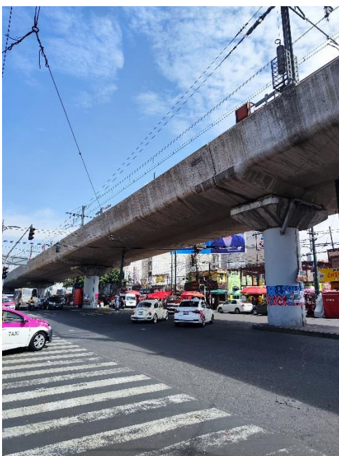
Gráfico 34. Vista de la infraestructura del metro sobre Av. Tláhuac. Elaboración propia. 2023
