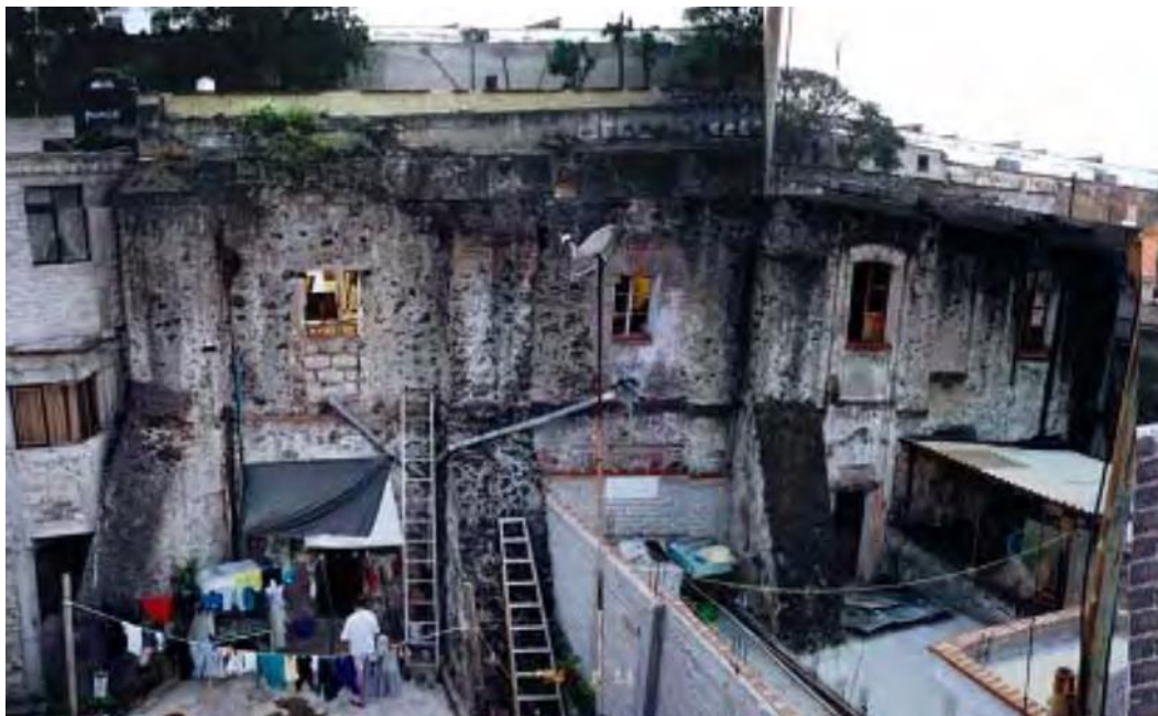
Imagen 70: Estado más actualizado de la fachada sur de la fábrica.
