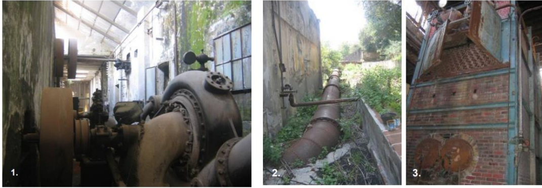
Imagen 51: Cuarto de turbinas. Imagen 52: Sistema de captación de agua. Imagen 53: Caldera de la ex fábrica “La Constancia Mexicana” en Puebla.
