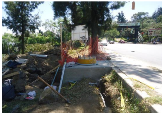
Imagen12. Obra civil, pilote de 4.5mts. Autoría propia CDMX; abril 2010
