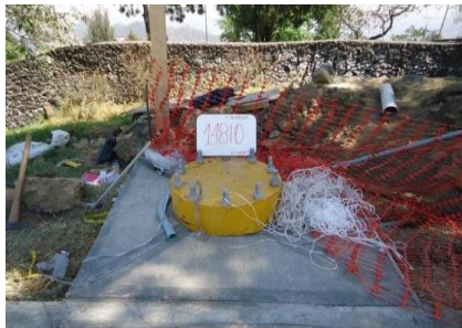
Imagen11. Obra civil, pilote de 4.5mts. Autoría propia CDMX; abril 2010
