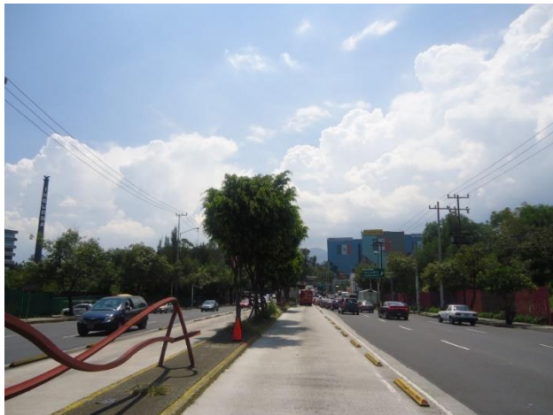
Imagen 17. Lugar estratégico para la instalación del ANPR carril del metrobús. Autoría propia. CDMX; septiembre 2014.
