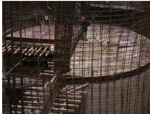
Imagen 2.2.1.3 Cimbrado de Tornillos de rampas, Foto tomada por Sergio Mendoza, Santa Fe 2007
