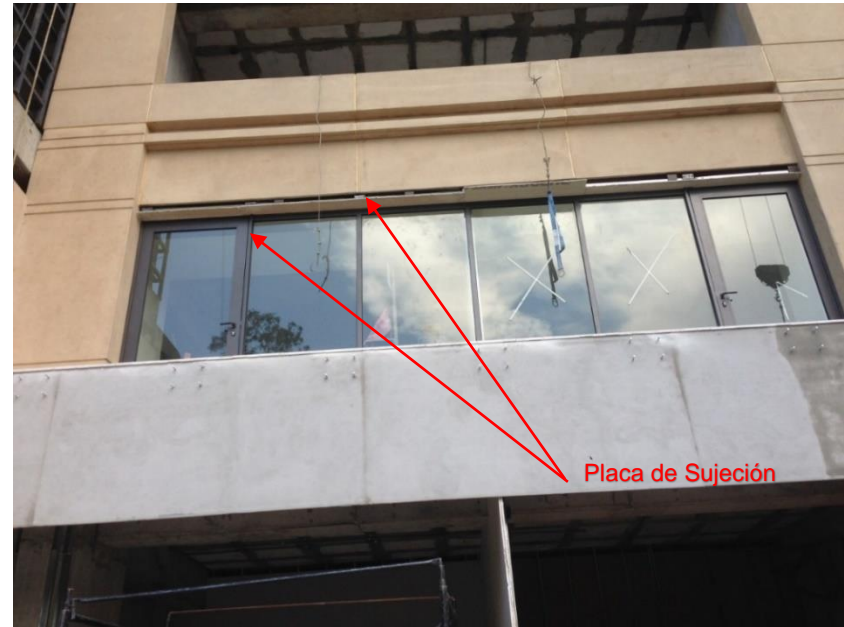
Imagen 2.2.1.15 Cancel y parasol en fachada principal, Foto tomada por Sergio Mendoza, CDMX, 2016
