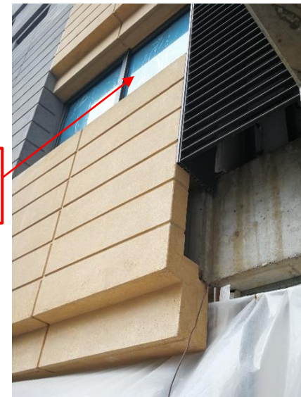
Imagen 2.2.1.17 Ventana en fachada posterior, Foto tomada por Sergio Mendoza, CDMX, 2016
