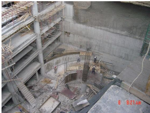
Imagen 2.2.1.2 Desplante de tornillos de rampas, Foto tomada por Sergio Mendoza, Santa Fe 2007
