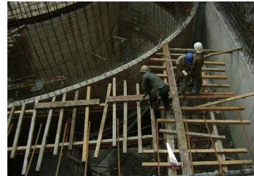
Imagen 2.2.1.4 Cimbrado de losa plana en la parte tangente de Tornillo de las rampas, Foto tomada por Sergio Mendoza, Santa Fe 2007
