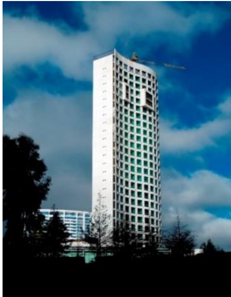
Imagen 2.2.1.1 Perspectiva del edificio semi terminado, Foto tomada por Poul Camhi, Archivo interno de Idea Asociados de México, Santa Fe 2010
