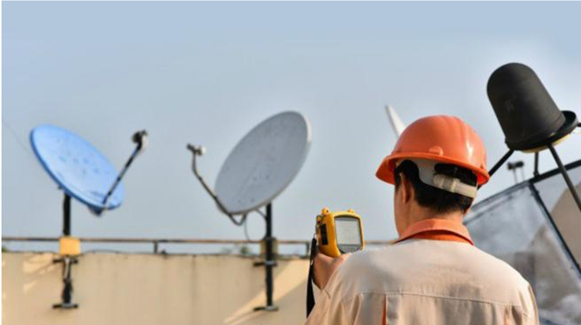
Figura 36. Instalador en campo.
