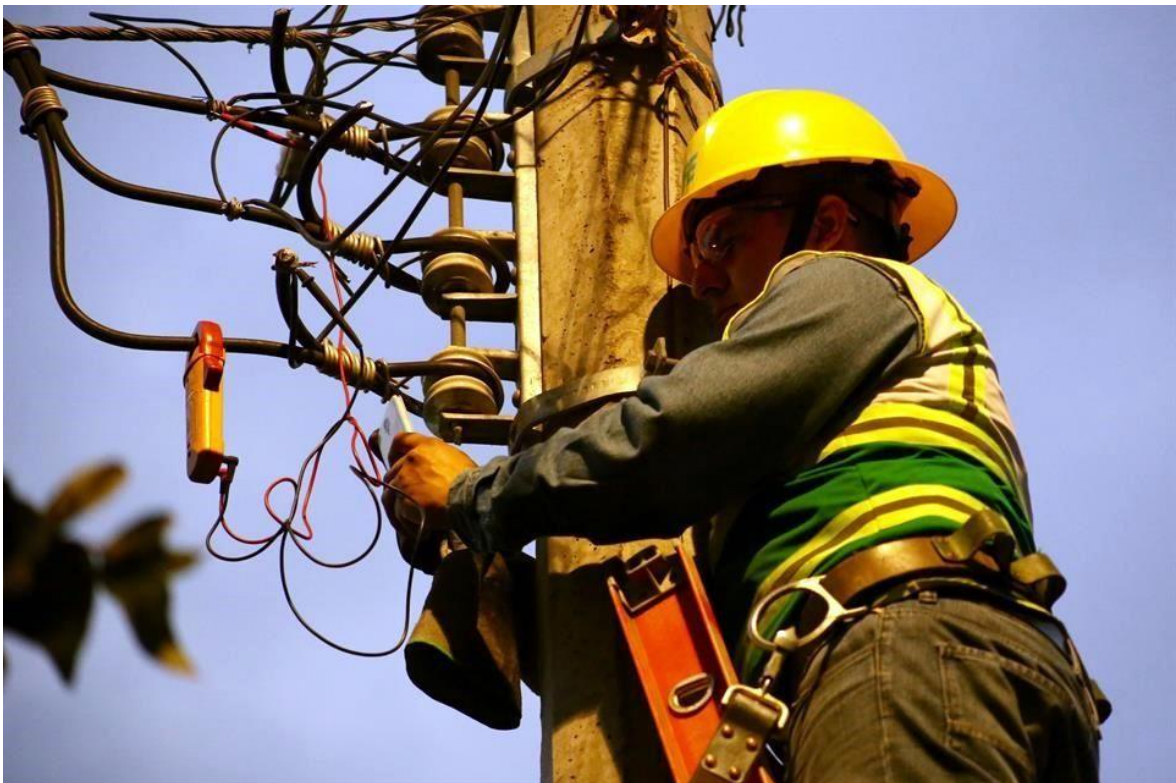
Figura 37. Uso de equipo de seguridad de instalador en poste.
