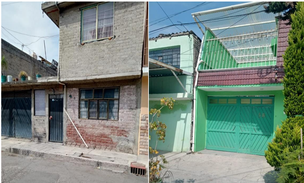
Imagen 17. Casas con canalización hacia la calle en Iztapalapa
