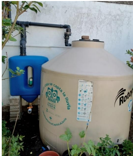
Imagen 32. Tlaloque y Tanque de almacenamiento en Santa Cruz Xochitepec
