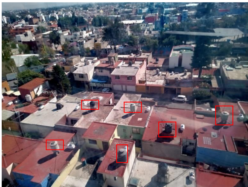
Imagen 4. Azoteas con tinacos en viviendas de la Ciudad de México
