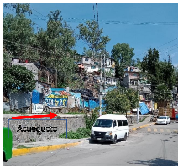
Imagen 23. Acueducto de la colonia San Gregorio Atlapulco
