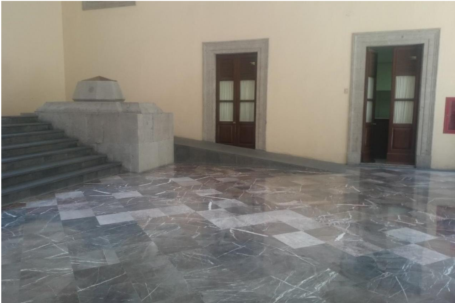
Fotografía 11. Mostrando que algunos accesos a espacios bloquean entradas a puertas, que aunque permanezcan cerradas en una situación de emergencia podrían abrirse.
