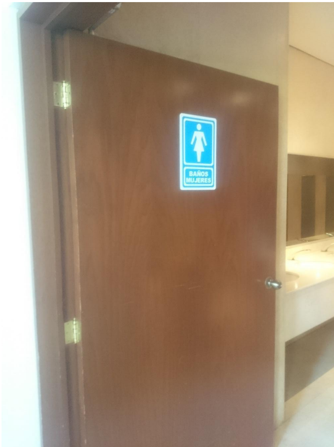
Fotografía 25. Se muestra la entrada al sanitario de mujeres con su señalización.
