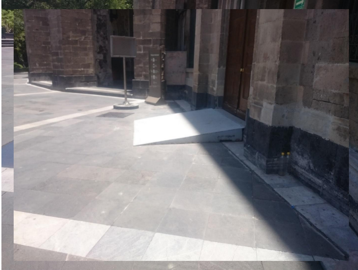
Fotografía 1. Se muestra rampa para acceso de personas en sillas de ruedas.
