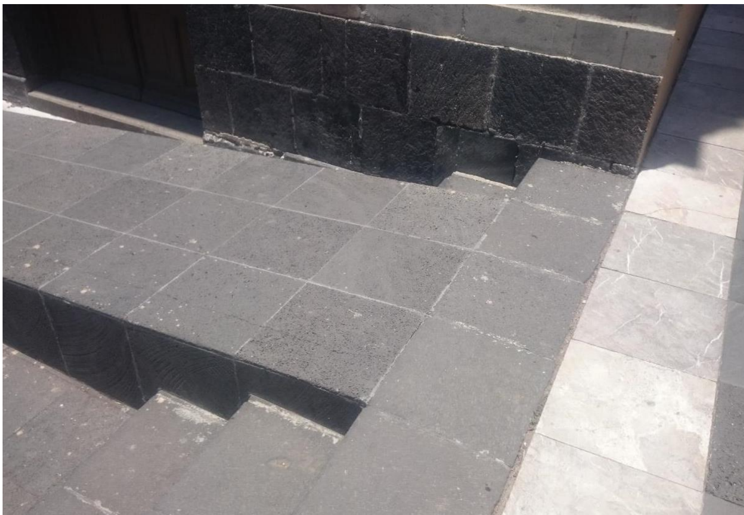
Fotografía 9. Rampa con escalera de piedra.
