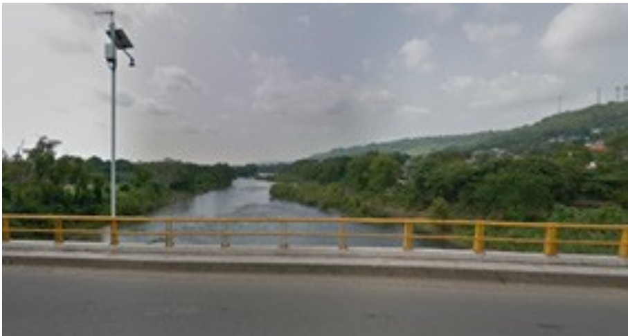
IMAGEN 11. Vista del Puente hacia el Río Cazones, Fuente: Google Maps
