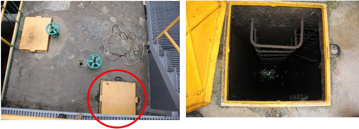
Figura 17. Toma de muestra efluente PTARCA.
