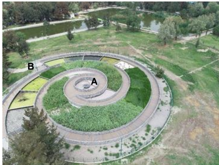
Figura 13. Humedal Artificial del bosque de San Juan de Aragón (SHADE). A) Toma de muestra influente. B) Toma de muestra efluente. Fuente: Luna Pabello
