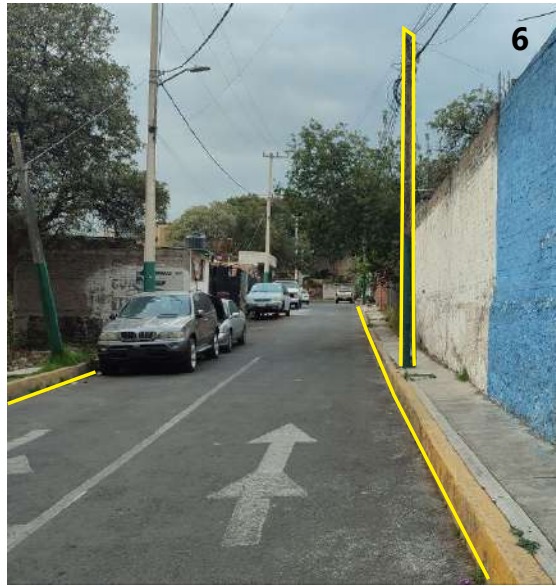
Figura 26. Fotografía propia. Calle Tehuizco, aunque cuenta con banquetas, las personas no pueden caminar en ellas, tomada en marzo de 2023.
