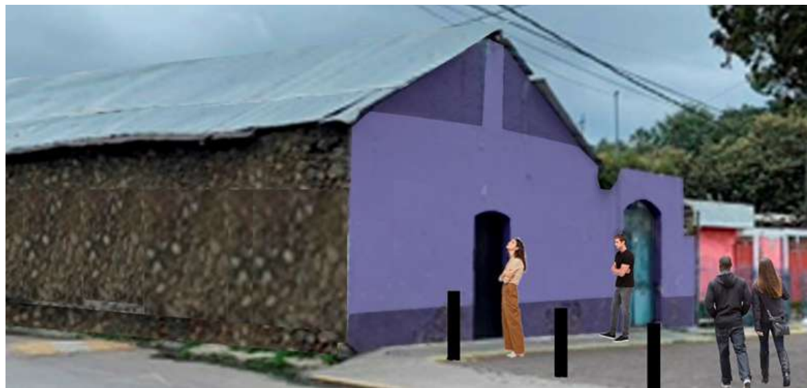
Figura 132. Fotografía propia. Casa-Habitación que se encuentra en Avenida 5 de mayo. Se propone recuperar estos inmuebles con su uso original, o una nuevo, respetando su pasado, 2023.
