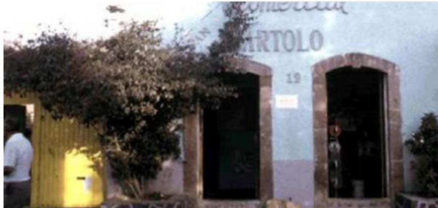
Figura 70. Coordinación N. de Monumentos Históricos. Fachada principal de la casa-habitación, comercio, del inmueble histórico. La fachada tiene aplanada blanco.
