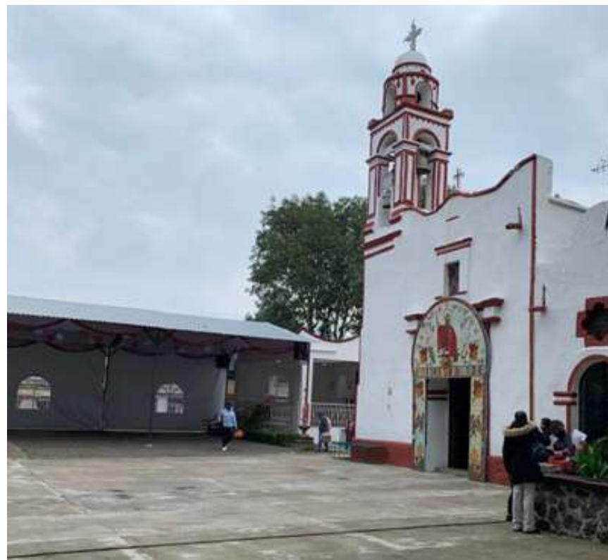
Figura 144. Fotografía propia. Fachada principal de la Iglesia de San Bartolomé Xicomulco, en el fondo se observa una estructura de acero, lugar donde actualmente se celebran las misas dominicales. Tomada en noviembre de 2022.
