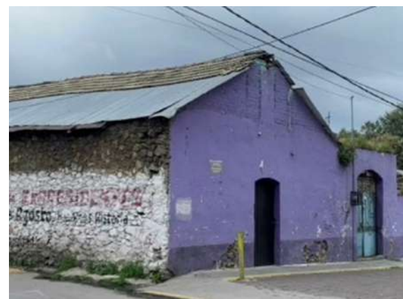
Figura 78. Fotografía propia. Fachada principal de la casa del rancho, 2022.
