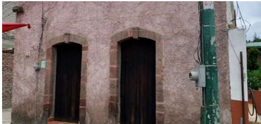
Figura 72. Fotografía propia. Fachada actual del inmueble, 2022. Conserva su estructura, pero no su color, ni función, 2023.
