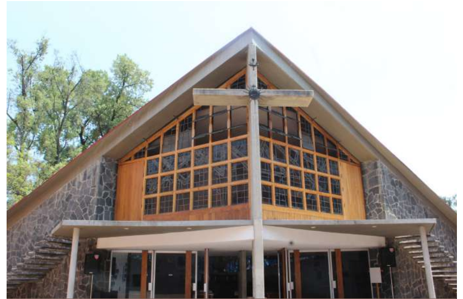
Figura 149. Fotografía tomada por Diana Servin Monroy. Fachada principal de la Capilla de Nuestra Señora de la Soledad, destacan los materiales principales como es la piedra y el concreto. Tomada el 21 de abril de 2023.
