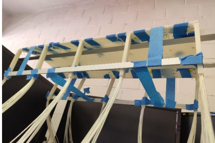
Figura 5.9 Proceso alineación de columnas y secado de la fijación de las mangueras en la cubierta
