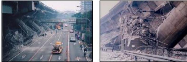
Figura 2.2.16. Colapso del viaducto Fukae, sismo de Kobe 1995, (Amini et al., 2010).
