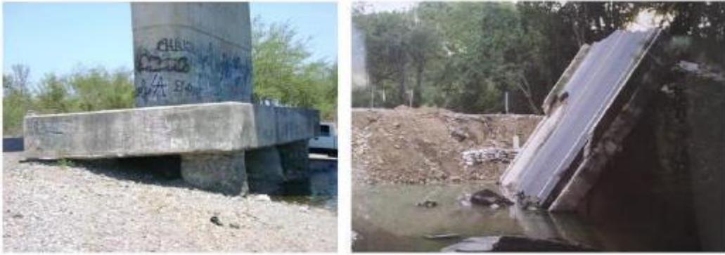
Figura 2.2.39. Falla en puentes por socavación de pilas, (Jara et al., 2011).
