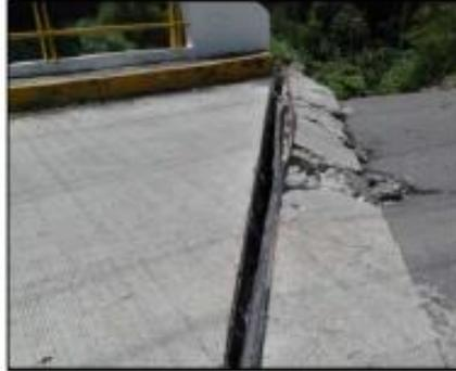
Figura 2.2.11. Desplazamiento de junta correspondiente al asentamiento y rotación de estribo, sismo México, 2017, (Foto cortesía de Rivera D. 2017).
