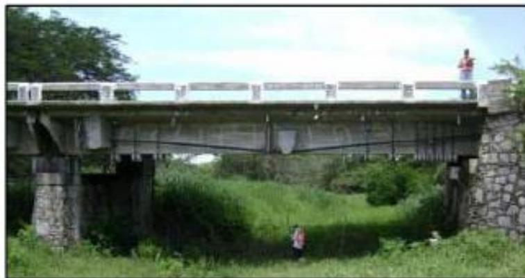
Figura 4.4.2. Refuerzo mediante el uso extremo de cables de presfuerzo. (Jara J., & Jara M., 2010).
