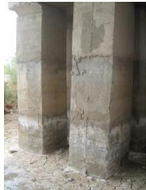
*Foto 3. Grietas longitudinales en las pilas.*
