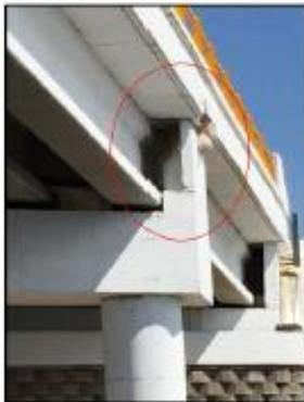
Figura 2.2.15. Falla de tope sísmico en puente de Morelos, sismo de México, 2017, (Foto de cortesía de Rivera D., 2017).
