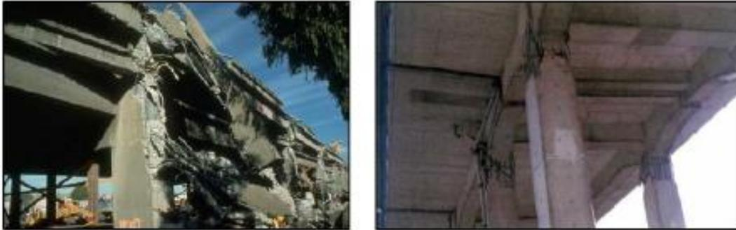
Figura 2.2.25. Falla de cabezal y unión pila-cabezal, (Caltrans, 2006).
