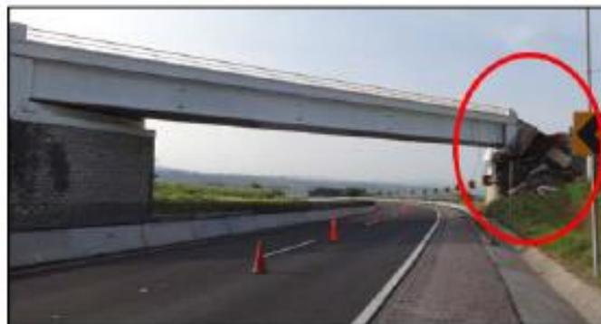
Figura 2.2.28. Daño en puente carretero de Morelos, presentando falla por asentamiento de estribos, (Foto cortesía de Rivera D., 2017).
