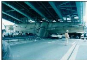
Figura 2.2.17. Colapso del viaducto Takashio, sismo de Kobe 1995. (Amini et al., 2010).
