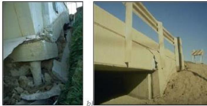
Figura 2.2.19. Movimiento de un terraplén de acceso. b) Asentamiento de un terraplén de acceso, (Quiroz, Ayala, 2018).
