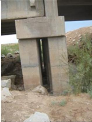
*Foto 5. Desplomo en las pilas No. 3 y agrietamiento en el cabezal.*
