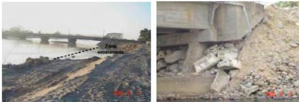
Figura 2.2.37. Daño severo en los puentes de Ciudad Hidalgo y Huehuetán, (Rivera D. et al., 2006).
