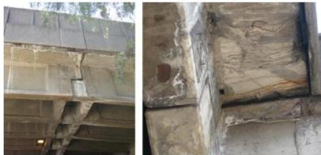
Figura 2.2.33. Problemas de corrosión en la superestructura por drenaje pluvial deficiente. (Fotos cortesía de Rivera D., 2017).
