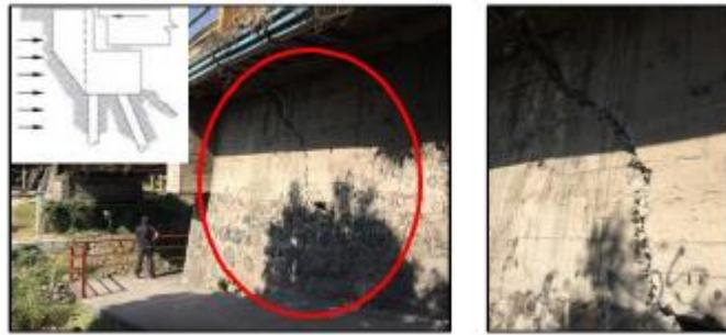
Figura 2.2.29. Fisuras presentadas por rotación y asentamiento de estribo en puente carretero de Morelos, (Foto cortesía de Rivera D., 2017).
