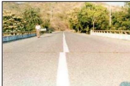
Figura 2.2.6. Movimiento Transversal de la Superestructura, (Hernández I. & Campos L., 2008).
