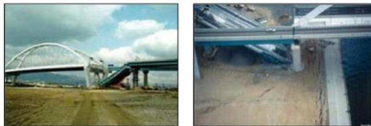
Figura 2.2.2. Desplome del acceso al Puente Nishinomiya-ko sobre la vía rápida de Wangan, (Jara et al., 2006).
