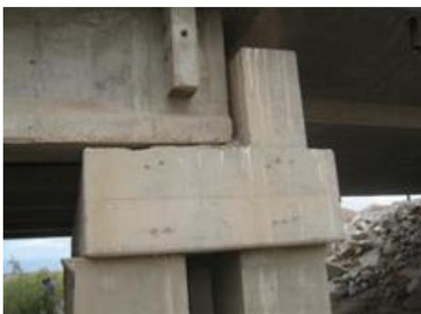
*Foto 4. Grietas en el cabezal.*
