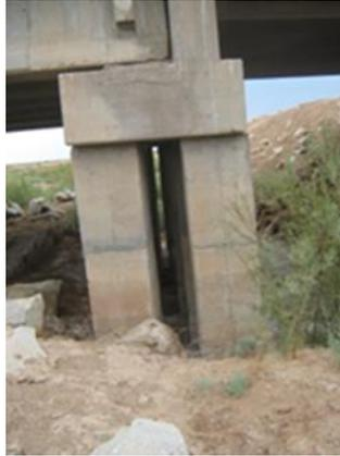
*Foto 5. Desplome en las pilas No. 3 y agrietamiento en el cabezal.*
