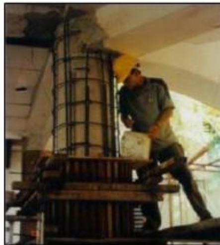
Figura 4.4.12. Rehabilitación de una columna con encamisado de concreto. (Chhabra Y., 2004).
