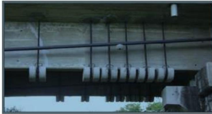
Figura 4.4.3. Uso de presfuerzo vertical para incrementar la capacidad a cortante de las nervaduras. (Jara J., & Jara M., 2010).
