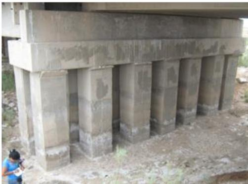
*Foto 2. Corrosión en la parte inferior de las pilas.*
