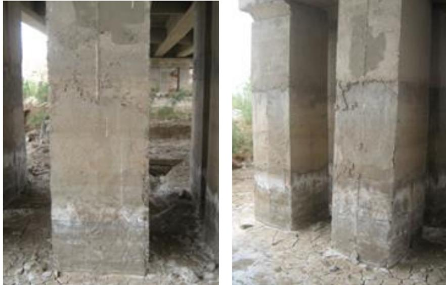
*Foto 3. Grietas longitudinales en las pilas.*
