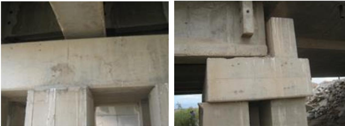
*Foto 4. Grietas en el cabezal.*
