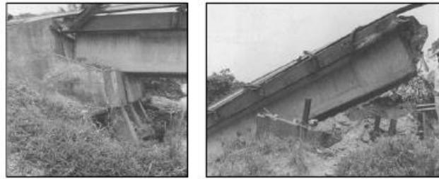
Figura 2.2.26. Hundimiento y falla de rotación del estribo, puente Río Banano, sismo de Costa Rica, 1990, (Priestley et al., 1996).
