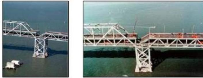
Figura 2.2.1. Colapso de una sección de la superestructura del Puente de la Bahía Oakland-San Francisco, sismo de Loma Prieta en 1989, (Jara M. et al., 2006).
