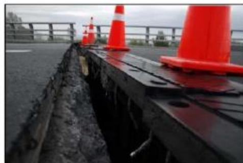
Figura 2.2.10. Junta de dilatación con daño tras terremoto, (PREANSA, 2010).
