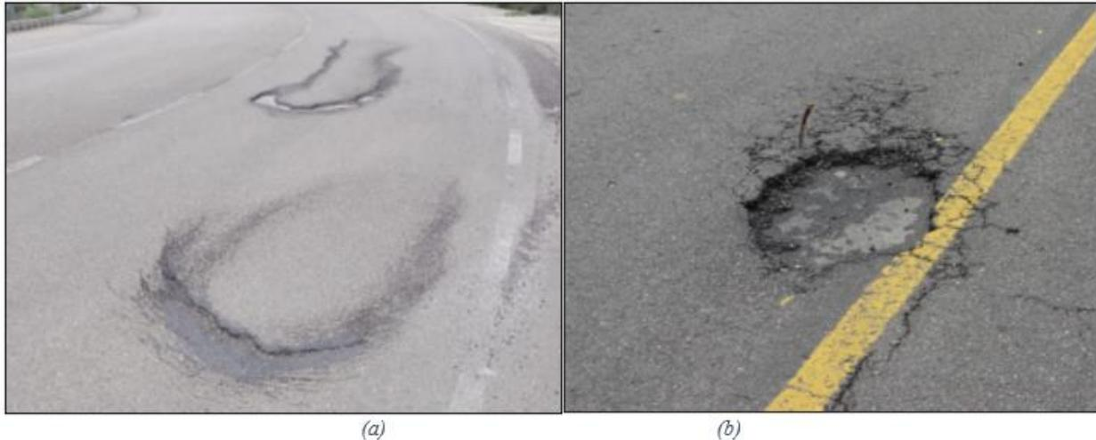
Figura 4. Deterioros del pavimento (a) grietas parabólicas (b) desprendimientos o baches [32,33]
