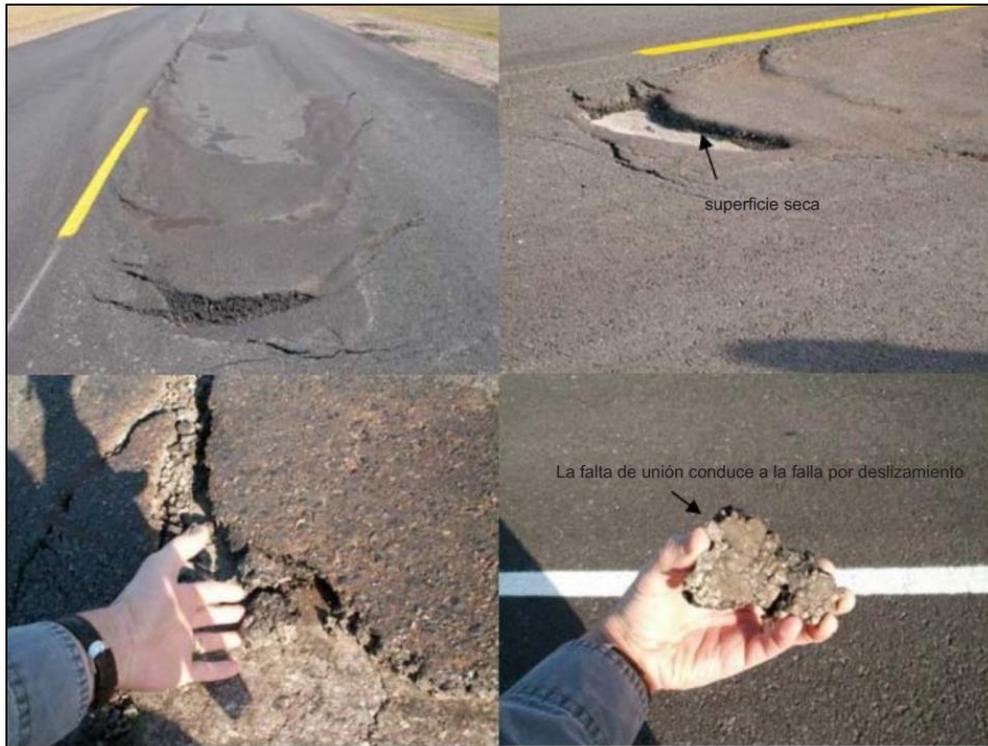
Figura 11. Falla prematura con grietas en forma de medialuna un día después de abrirse al tránsito. [50].
