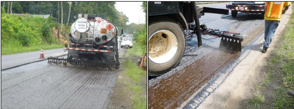
Figura 2. Instalación de riego de liga [16].
