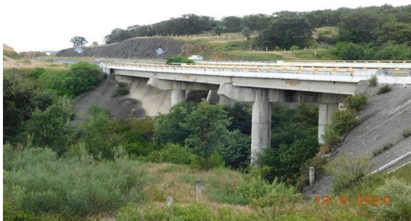
Figura 3.1 Vista panorámica del puente bajo estudio
