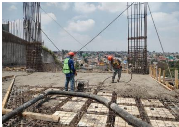
Ilustración 33. Colado y vibrado en losa. / Ilustración propia: tomada en obra.
