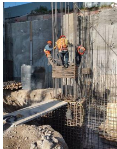
Ilustración 28 y 29. Armado de columnas. / Ilustración propia: tomada en obra.
