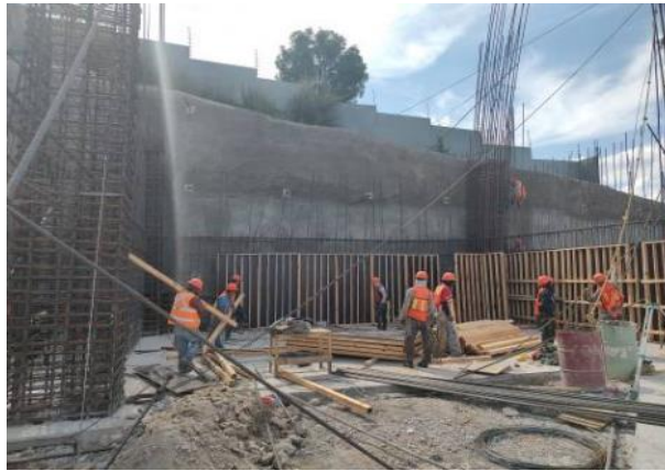
Ilustración 31. Cimbra en muros. / Ilustración propia: tomada en obra.
