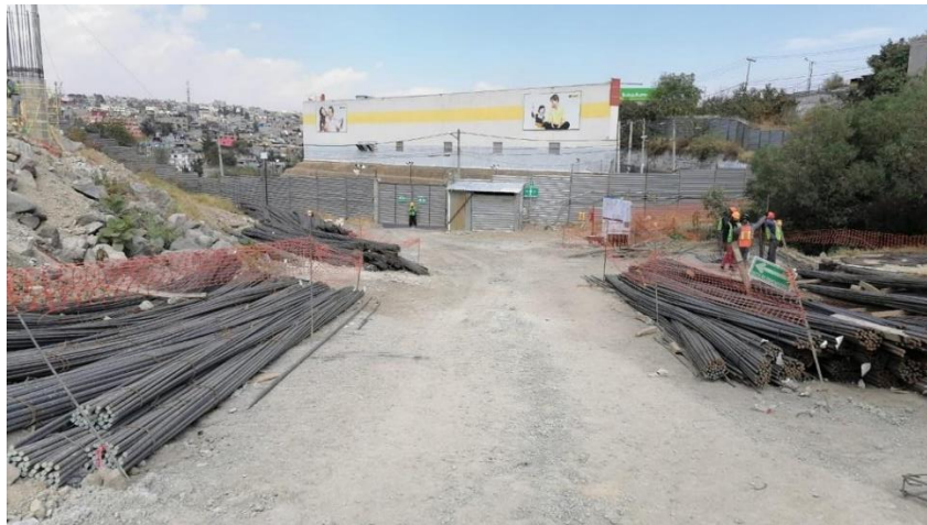
Ilustración 46. "Almacén de materiales-ANTES". / Fuente: CUMBRES HERRADURA.
