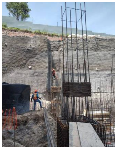
Ilustración 28 y 29. Armado de columnas. / Ilustración propia: tomada en obra.
