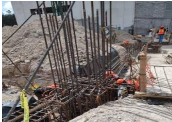
Ilustración 27. Armado de dados. / Ilustración propia: tomada en obra.
