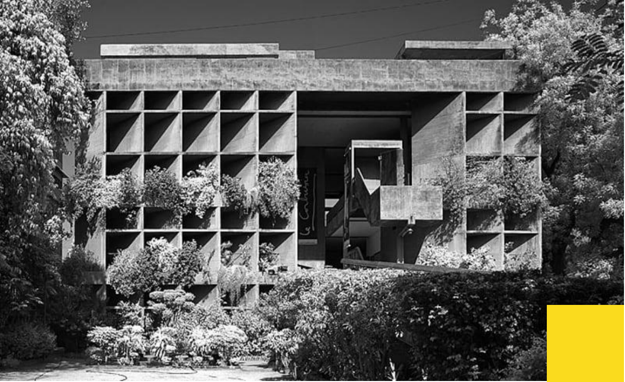
Figura 6. Fachada con los Brise-soleil del edificio. Fuente: Cemal Edmen. Divisare Books.
