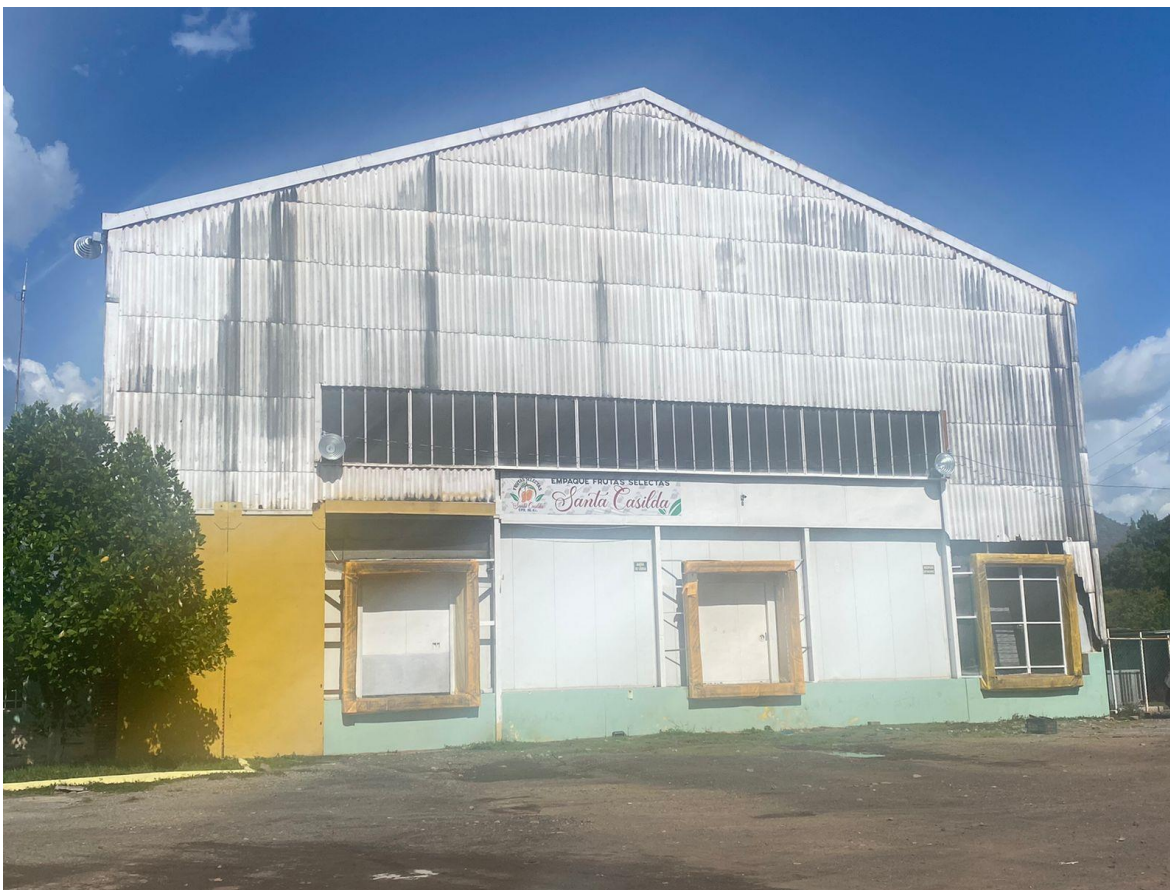
Figura 4.3 Infraestructura de la empresa (frente).
