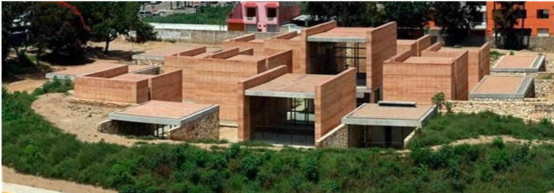
VISTA AEREA DE ESCUELA DE ARTES PLASTICAS DE OAXACA
