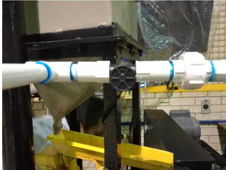
Figura 38. Instalación del sensor de flujo YF-S201.
