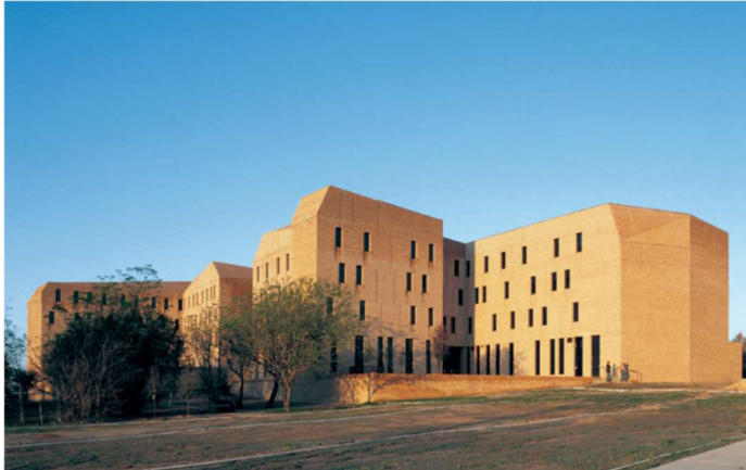
Ilustración 39. Fachada de edificios. [Fotografía] Por: Alejandro Aravena, por: Alejandro Aravena, 2008, ArchDaily, < https://www.archdaily.com/31771/st-edwards-university-new-residence-and-dining-hall-alejandro-aravena >
