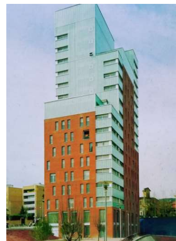
Ilustración 8. Fotografía donde se aprecia el cambio de niveles en el edificio. Obtenido de: ibidem (p.51)
