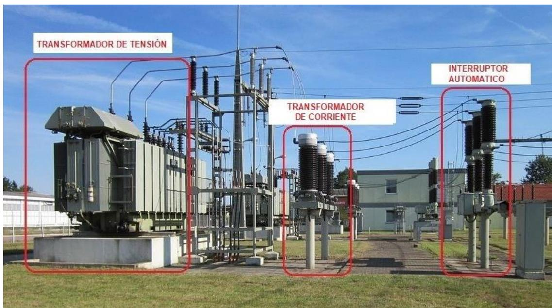
Figura 3.3 Instrumento de medición TC's Tipo pedestal
