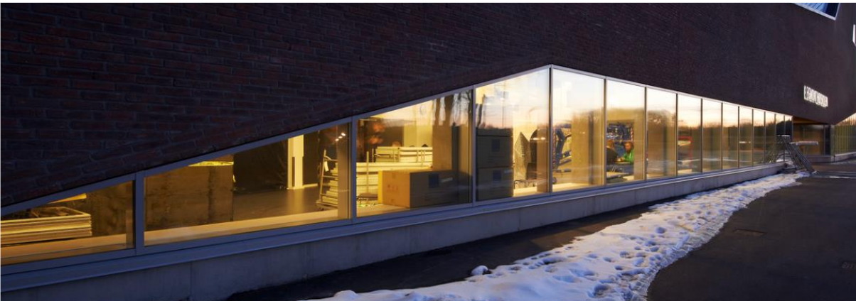
Facha lateral del centro de rehabilitación “Vandhalla”
