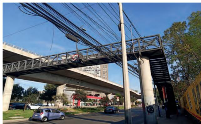
5- La banqueta tiene un espacio insuficiente para circular, la obstrucción es por los postes de luz que se encuentran muy cerca del puente peatonal. Además de que existen cables eléctricos a muy baja altura que atraviesan el puente, lo cual resulta peligroso y descuidado.
