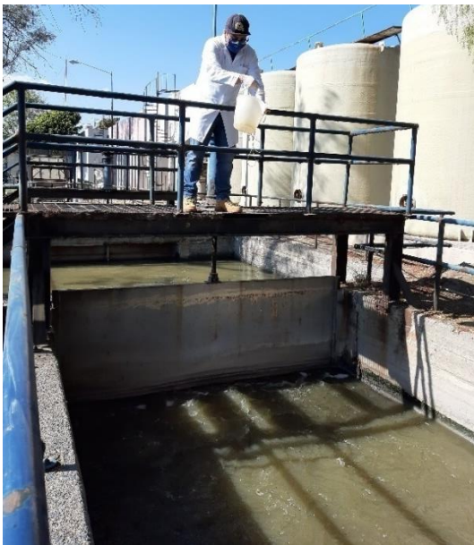
Figura 3.8. Toma de muestra en el cárcamo de recepción de agua residual, PTAR Cerro de la Estrella
