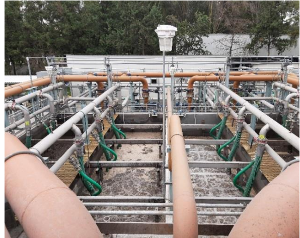
Figura 3.15 Módulos de membranas de ultrafiltración
