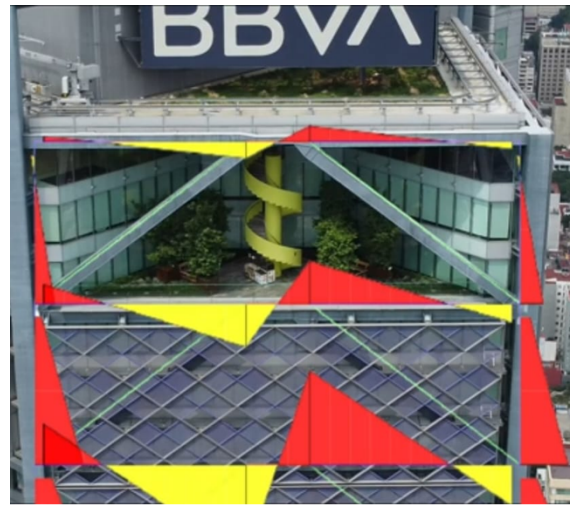
Figura 5.8: Diagrama de momentos. Fuente: Torre BBVA Bancomer. Por el Canal de YouTube: Estructuristeando.
