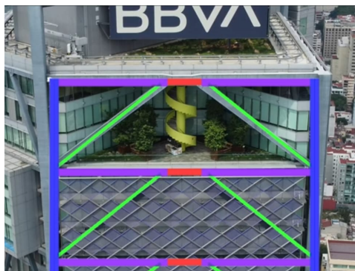
Figura 5.6: Arriostramientos estructurales. Fuente: Torre BBVA Bancomer. Por el Canal de YouTube: Estructuristeando
