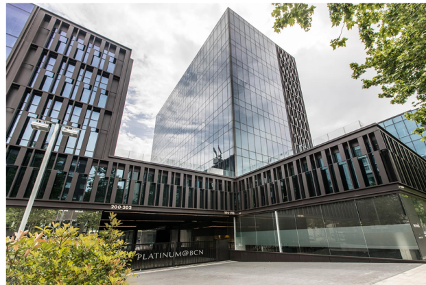
Figura 5.11: Vista del complejo de oficinas Platinum BCN. Fuente: Página oficial del Platinum BCN.
