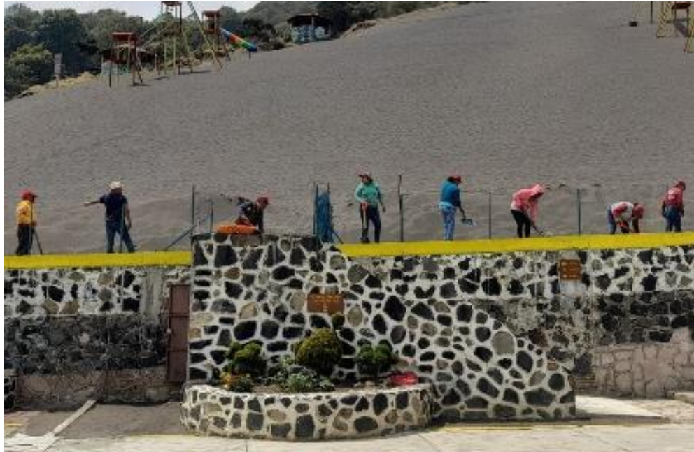
Figura 58. Labores de reacomodo de la ceniza, para la contención del material del Arenal de manera que las instalaciones del Ecoparque no se llenen de este, estas labores son realizadas por los brigadistas CORENADR de la zona de conservación de Magdalena Petlalcalco.
