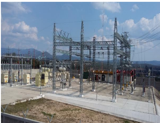
Especificaciones: ampliación de subestación eléctrica “115 Kv, IT-3F-30 MVA115/13.8. Kv-0/6 A-1.2 MVAR alimentadores”
