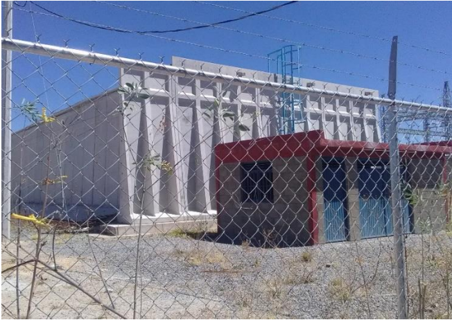
Especificaciones: Tanque superficial 1900m 3 de capacidad
