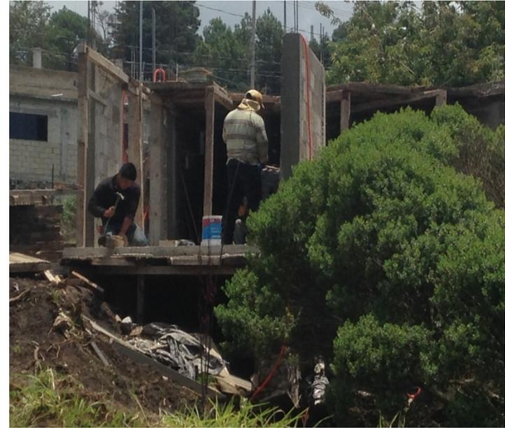
Imagen 155. Fotografía de elementos estructurales donde se reutilizó la varilla recuperada en demolición. Autoría propia. Huitzilac, Mor 2015
