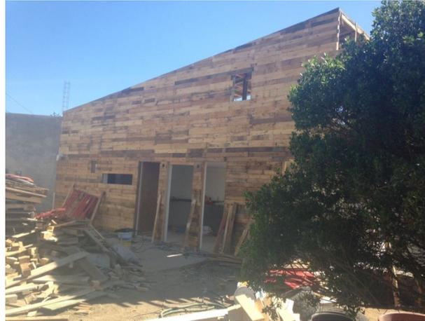
Imagen 165. Fotografía colocación de las tablas en la fachada.
