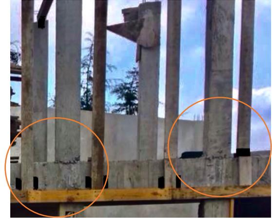
Imagen 170. Fotografía detalle de soportería para estructura de lambrín.
