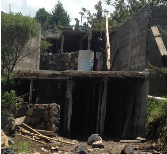
Imagen 154. Fotografía de elementos estructurales donde se reutilizó la varilla recuperada en demolición. Autoría propia. Huitzilac, Mor 2015
