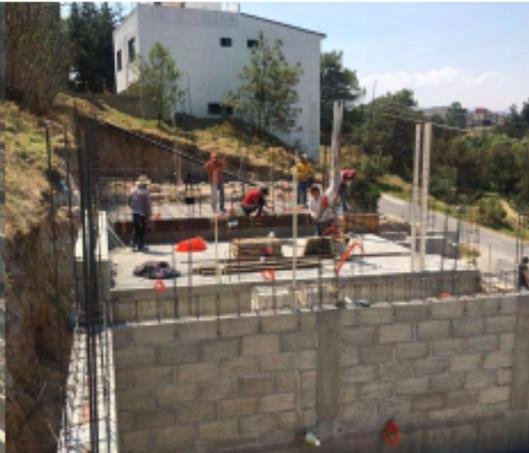
Imagen 72. Fotografía de construcción de losas de planta baja. Autoría propia. Ocoyoacac.
