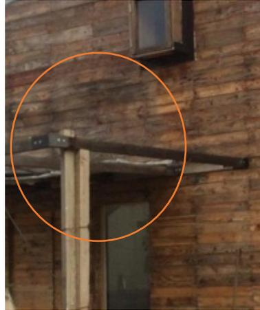
Imagen 169. Fotografía detalle de soportería en techumbre para pórtico.
