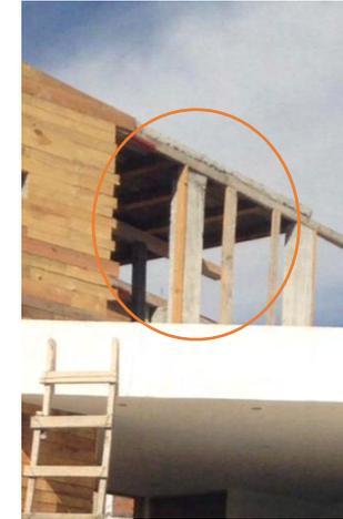
Imagen 162. Fotografía madera de cimbra para base de losa en la cubierta.
