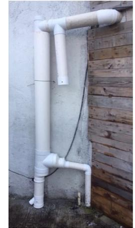
Imagen 143. Fotografía de filtro instalado para agua de lluvia. Autoría propia. CDMX 2015.
