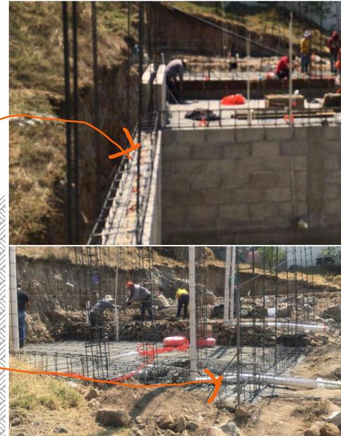
La humedad y/o escurrimientos serían dirigidos por medio de un chafalán en medio de los muros a una tubería de PVC con pendiente hacia un registro previo al drenaje general. (ver imagen 80, 81 y 82).
