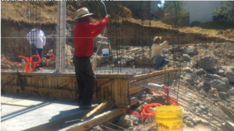
Imagen 71. Fotografía de construcción de losas de cimentación. Autoría propia. Ocoyoacac. Edo. Mex. 2022.
