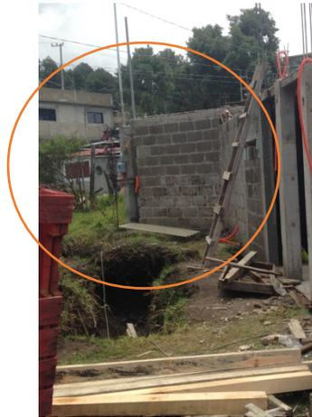
Imagen 151. Fotografía muro de colindancia construidos con block recuperado de demolición. Autoría propia. Huitzilac. Mor 2015.
