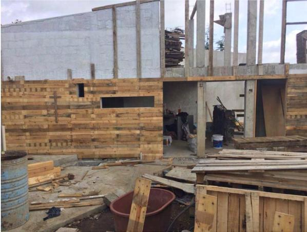
Imagen 164. Fotografía habilitación de la madera para su posterior colocación.
