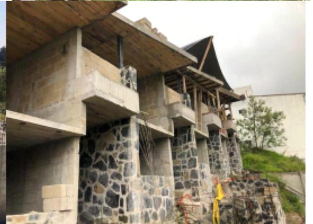
Imagen 73. Fotografía de construcción losa de pasillo exterior. Autoría propia. Ocoyoacac. Edo. Mex. 2022.
