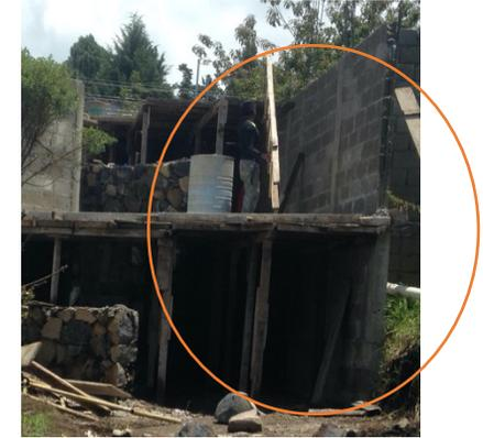
Imagen 152. Fotografía muro de colindancia construidos con block recuperado de demolición. Autoría propia. Huitzilac. Mor 2015.
