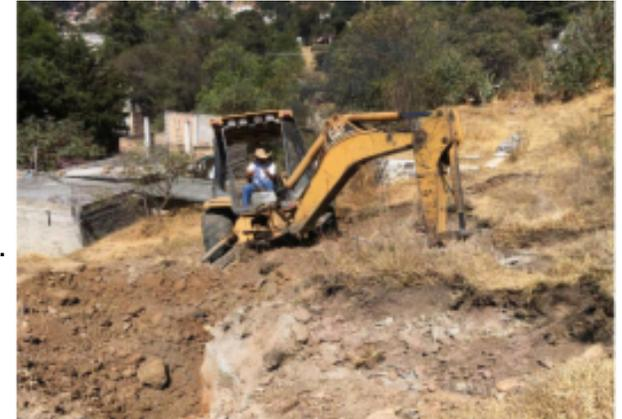
Imagen 70. Fotografía de excavación para muro de contención. Autoría propia. Ocoyoacac. Edo. Mex. 2022.
