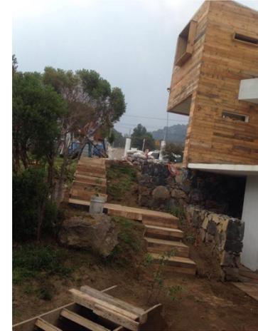
Imagen 166. Fotografía colocación escalones con bases de tarima de embalaje.
