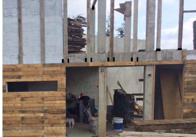
Imagen 161. Fotografía madera de cimbra para refuerzo estructural para la cubierta.
