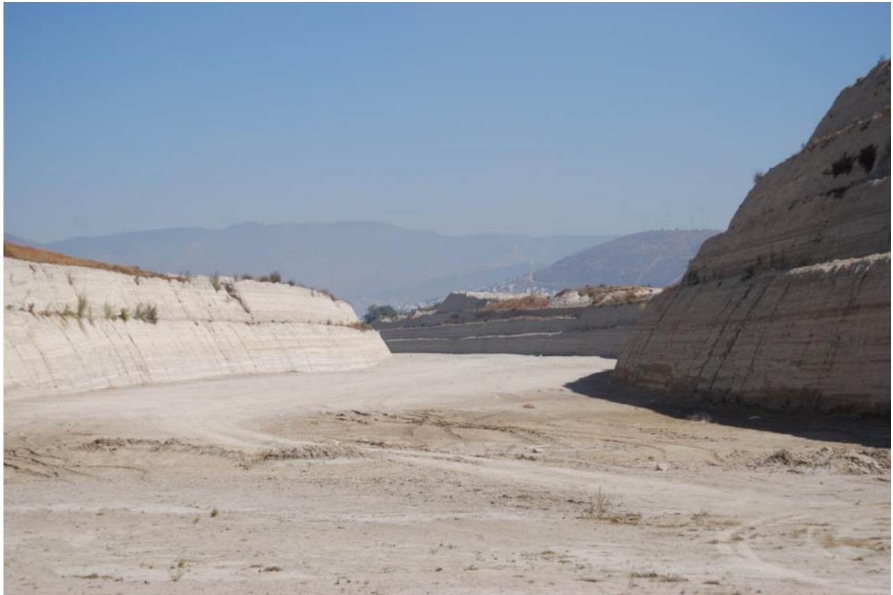
Figura 16 Jales de mina en septiembre del 2010, cercanos al campo de golf en la ciudad de Pachuca, Hgo. El corte se hizo para la construcción del Boulevard Nuevo Hidalgo. Foto Jannu Lira Alatorre.
