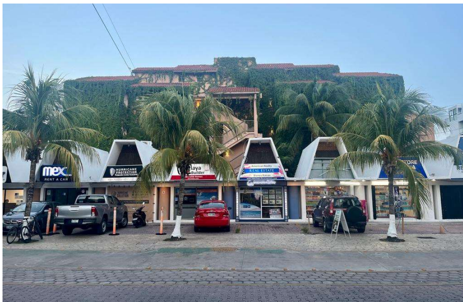
Fig. 14 Locales comerciales sobre Av. 10 entre Calle 14 y 16 Nte. Fotografía: Xatria Manzo
