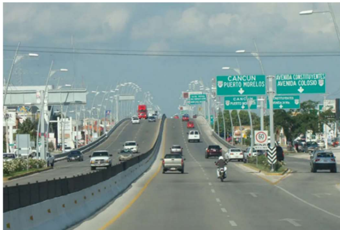
Fig. 24 Vista del acceso al puente con dirección a Cancún. Fuente: Precaución: Cerrarán tramo de carretera Cancún-Playa por mantenimiento (meganews.mx)
