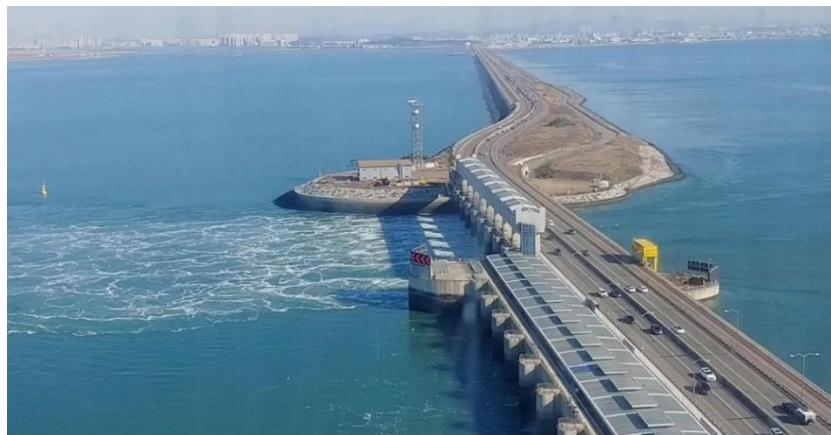
Figura 2-4. Planta de Energía Mareomotriz Sihwa Lake, Corea del Sur. Tomado de [15]
