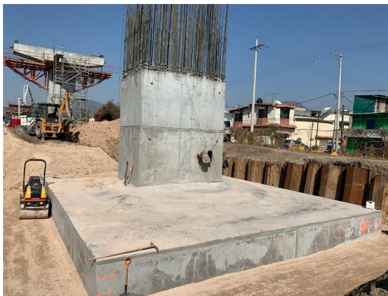
Figura 3.6. Vibración por actividad constructiva. Proyecto Macrolibramiento Mexiquense Tramo 4.1, Edomex. México
