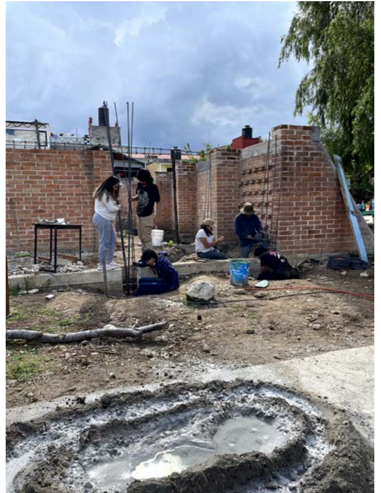
Excavación para columnas.
