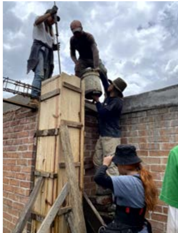
Cimbra en columnas.
