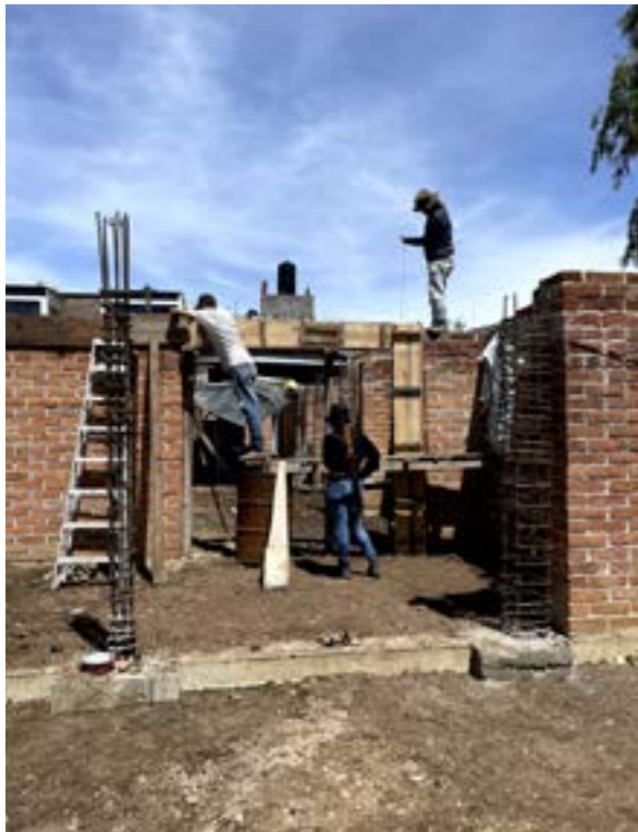
Cimbra de traves.
