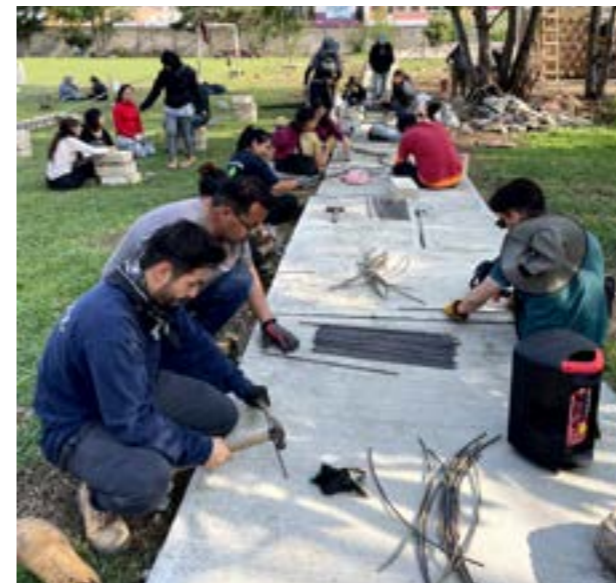
Tramos de alambón para estribos.
