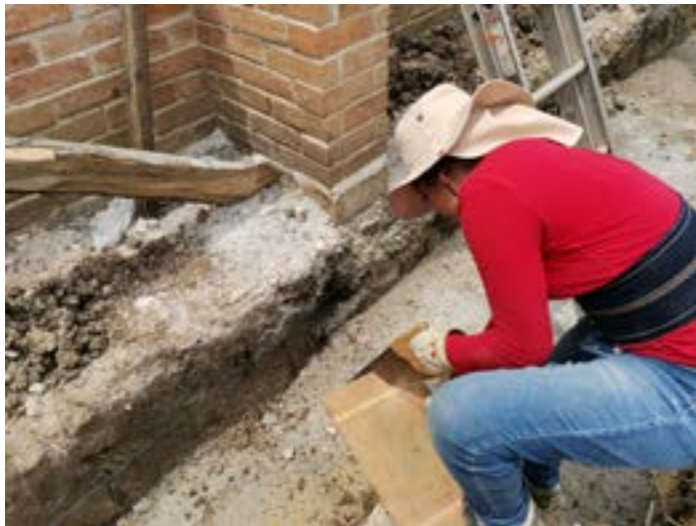
Corte de madera para cimbra de lavabo.
