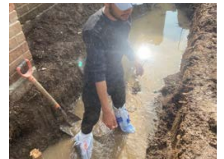
Inundación por lluvia.
