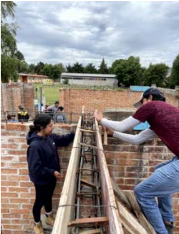
Cimbra en columnas y traves (cerramiento).
