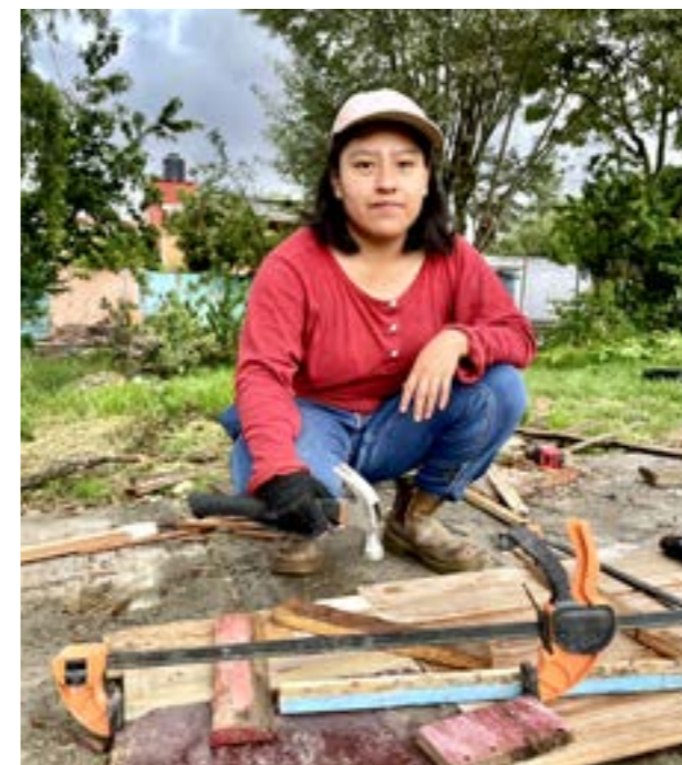
Armado de cimbra con material reciclado.
