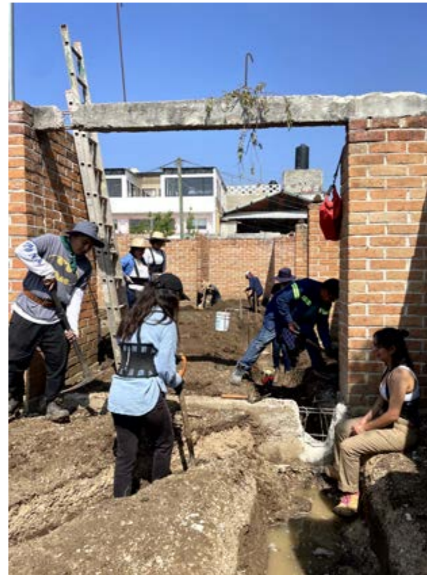
Excavación para contratrabes.
