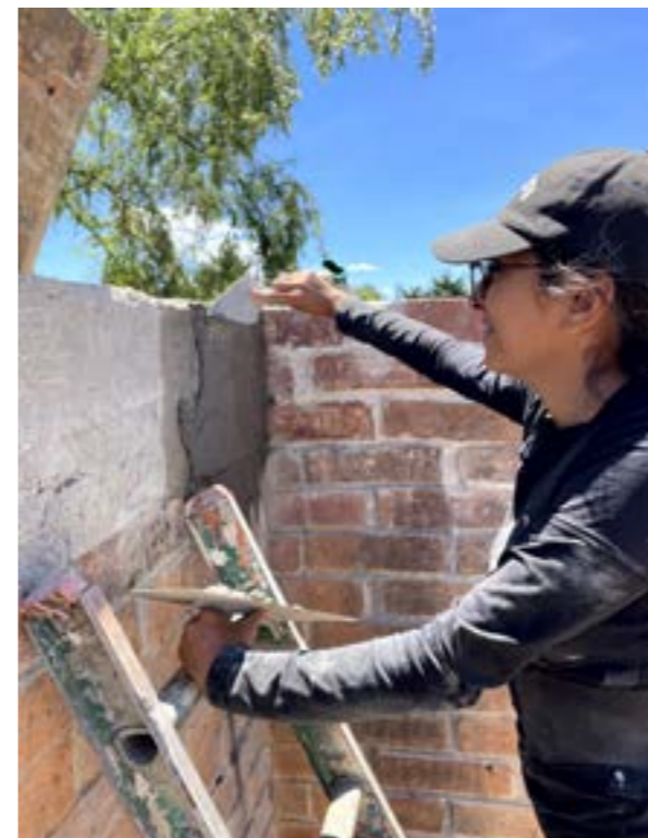
Acabado final de cerramiento.
