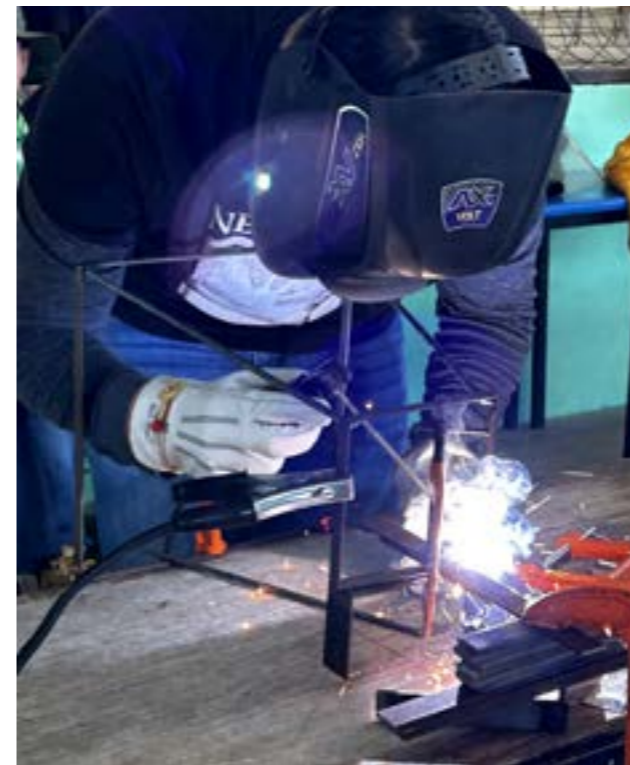
Cimbra en columnas con placa paracubierta.
