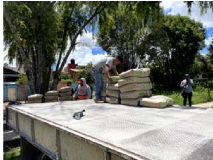
Llegada de material a obra.
