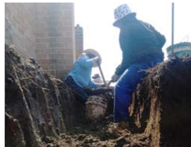
Nivel de la excavación.
