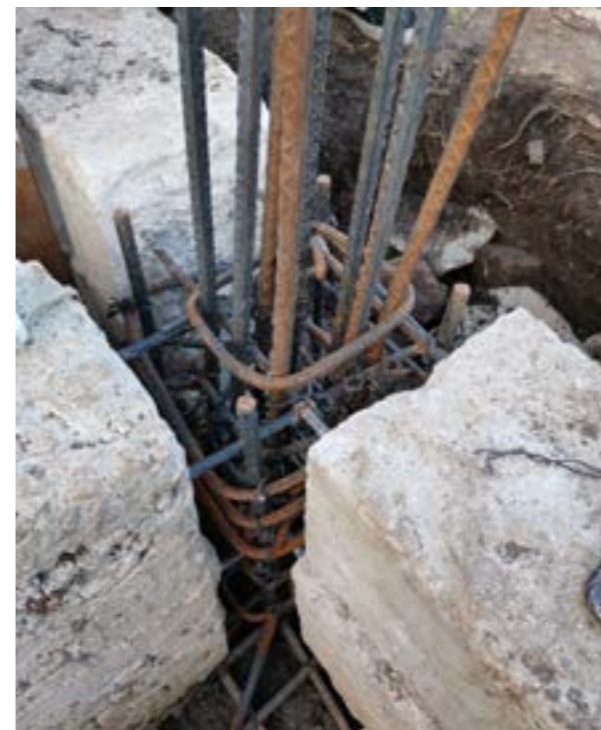
Armado de dado de cimentación.
