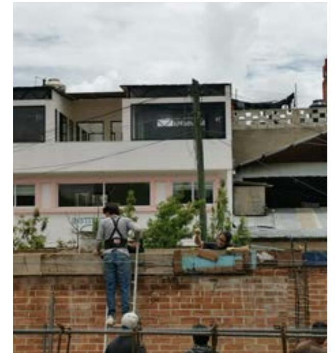
Cimbra de traveses (cerramiento).
