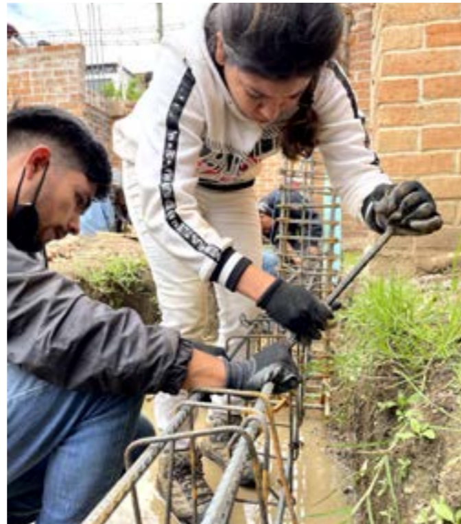
Armado de trabe (cerramiento) 0.20*0.15 m
