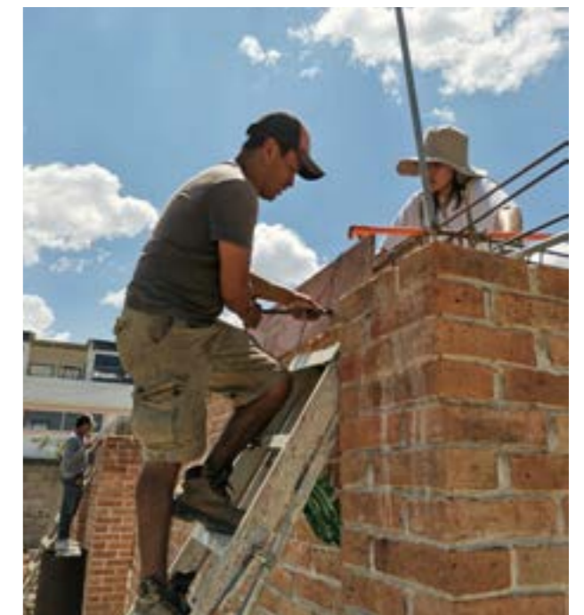
Amarrado de cimbra de trabe.
