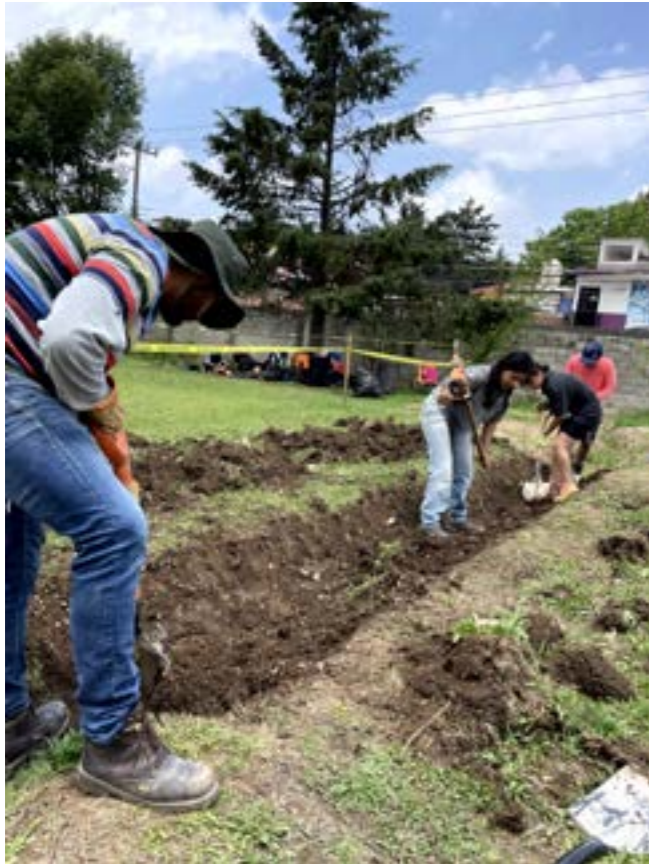
Excavación de canal al exterior del aula.
