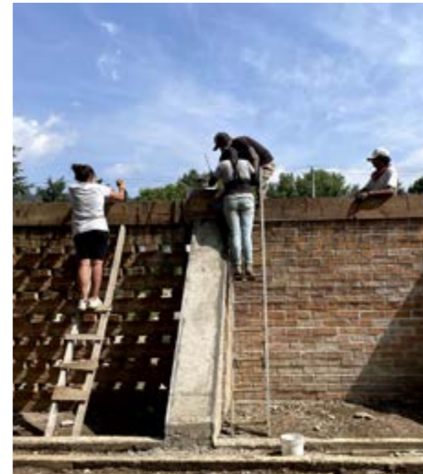
Cimbra de trabe principal.
