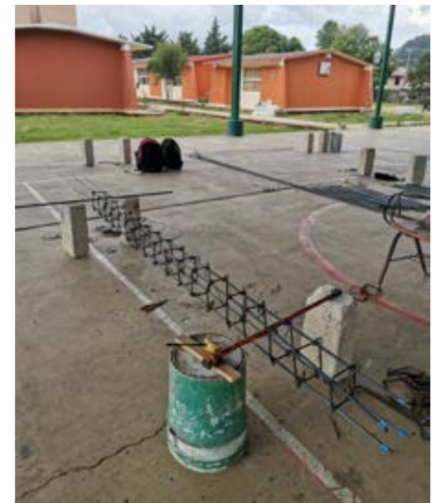
Armado de castillo de 0.15*0.15 m
