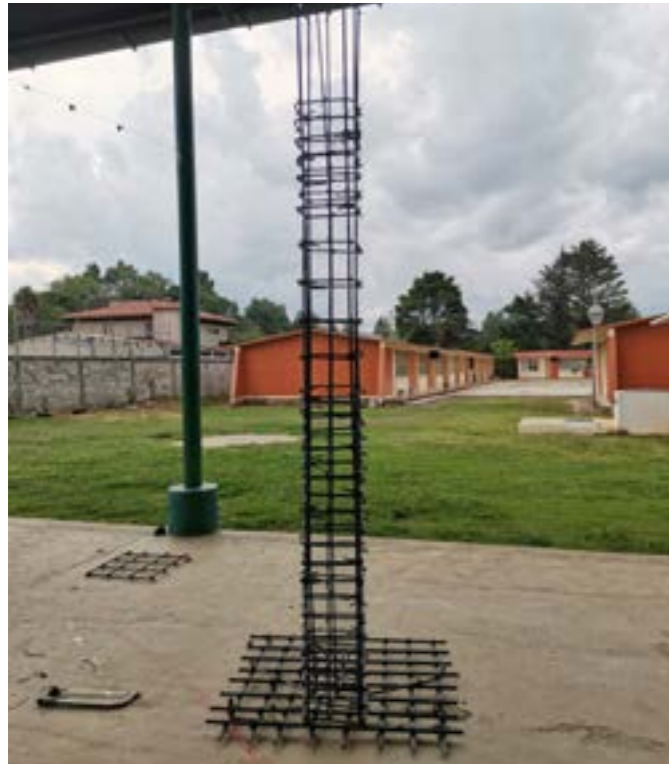
Armado de columna con zapata.
