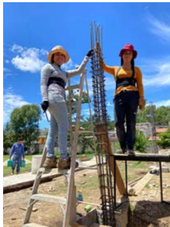
Armado de columna 0.30*0.30 m.
