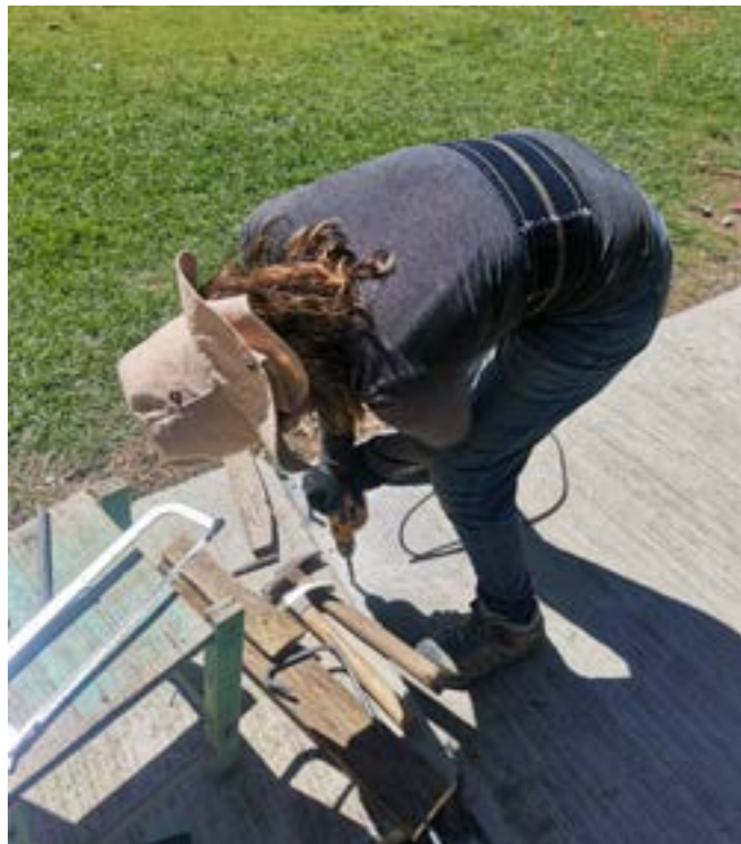
Base para hacer estribos en suelo.
