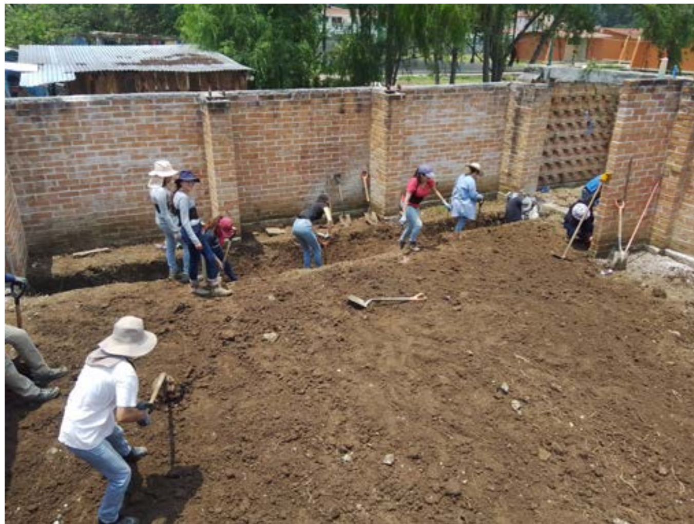
Excavación para la cimentación.
