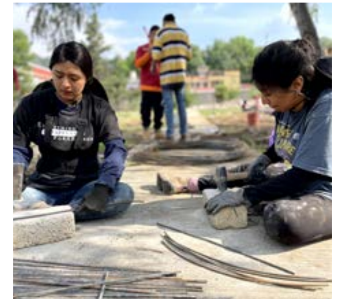
Aplanado de alambón para estribos.
