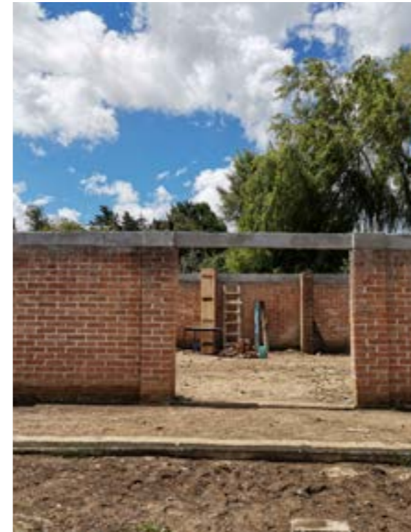
Acabado final de cerramiento.
