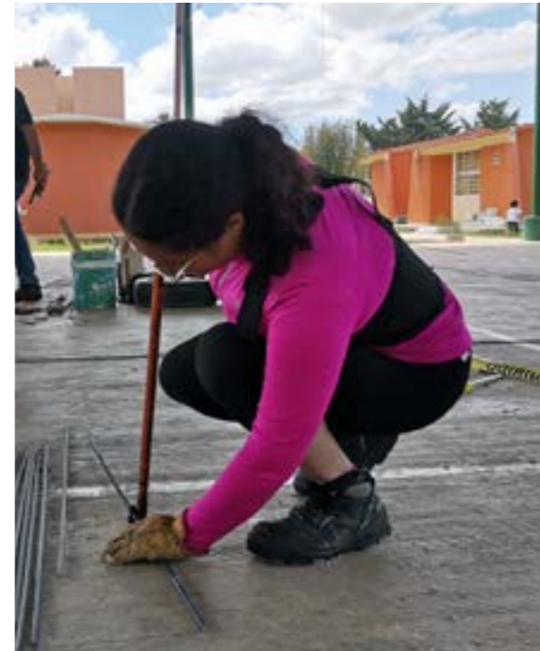
Desdoble de varilla con grifa y tubo metálico.
