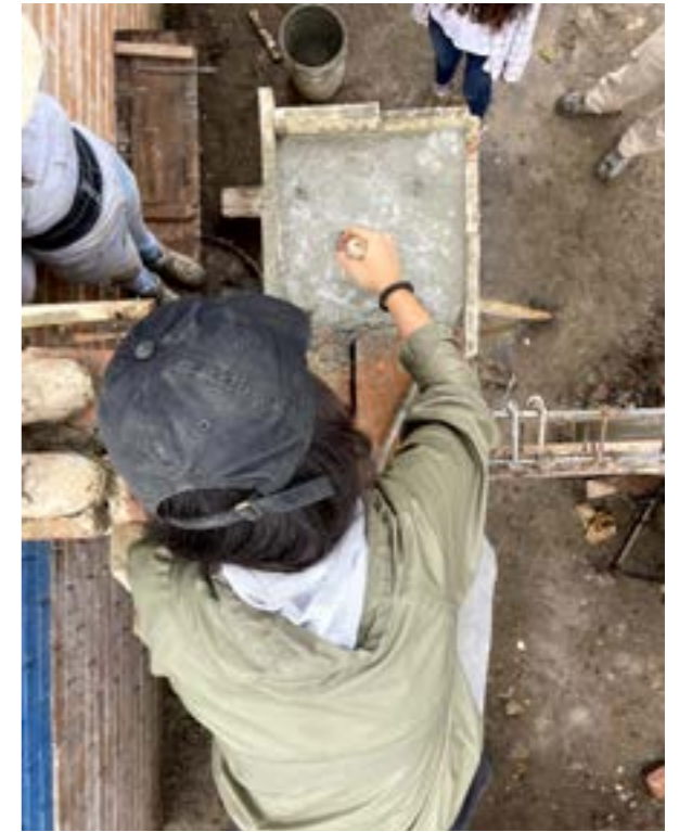
Vibración de colado.
