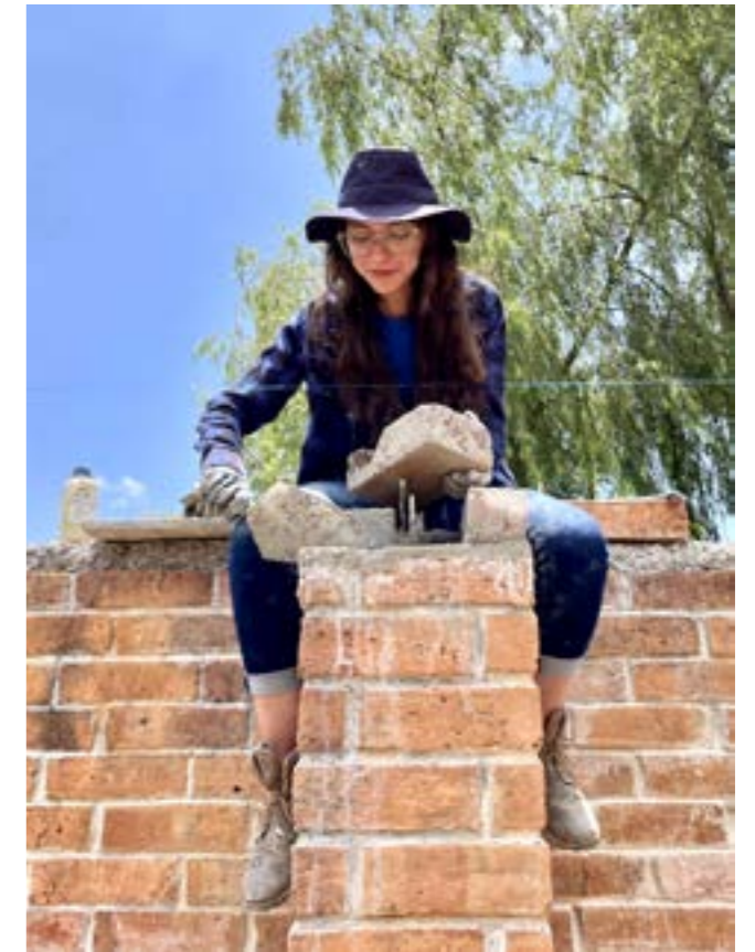
Terminación de nivel de muro.
