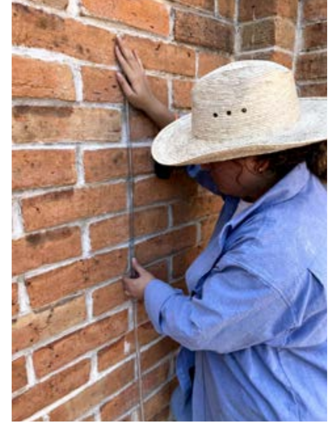
Nivelación de muro.
