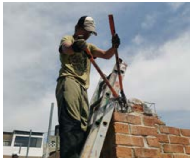
Demolición de cerramiento y primer hilada de muro.
