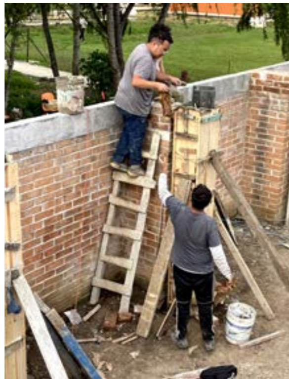
Cimbra en columnas con placa paracubierta.
