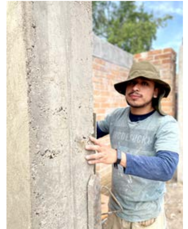
Acabado final de columnas.
