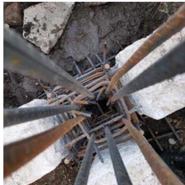
Ensamble de armado con estructura preexistente.
