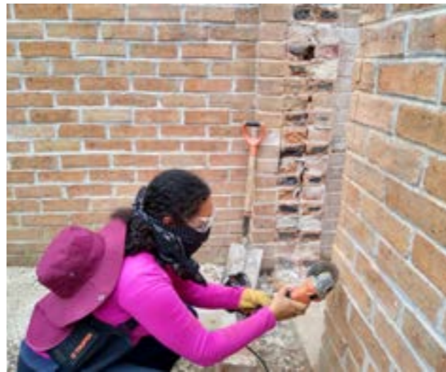
Demolición de un tramo de muro interior.
