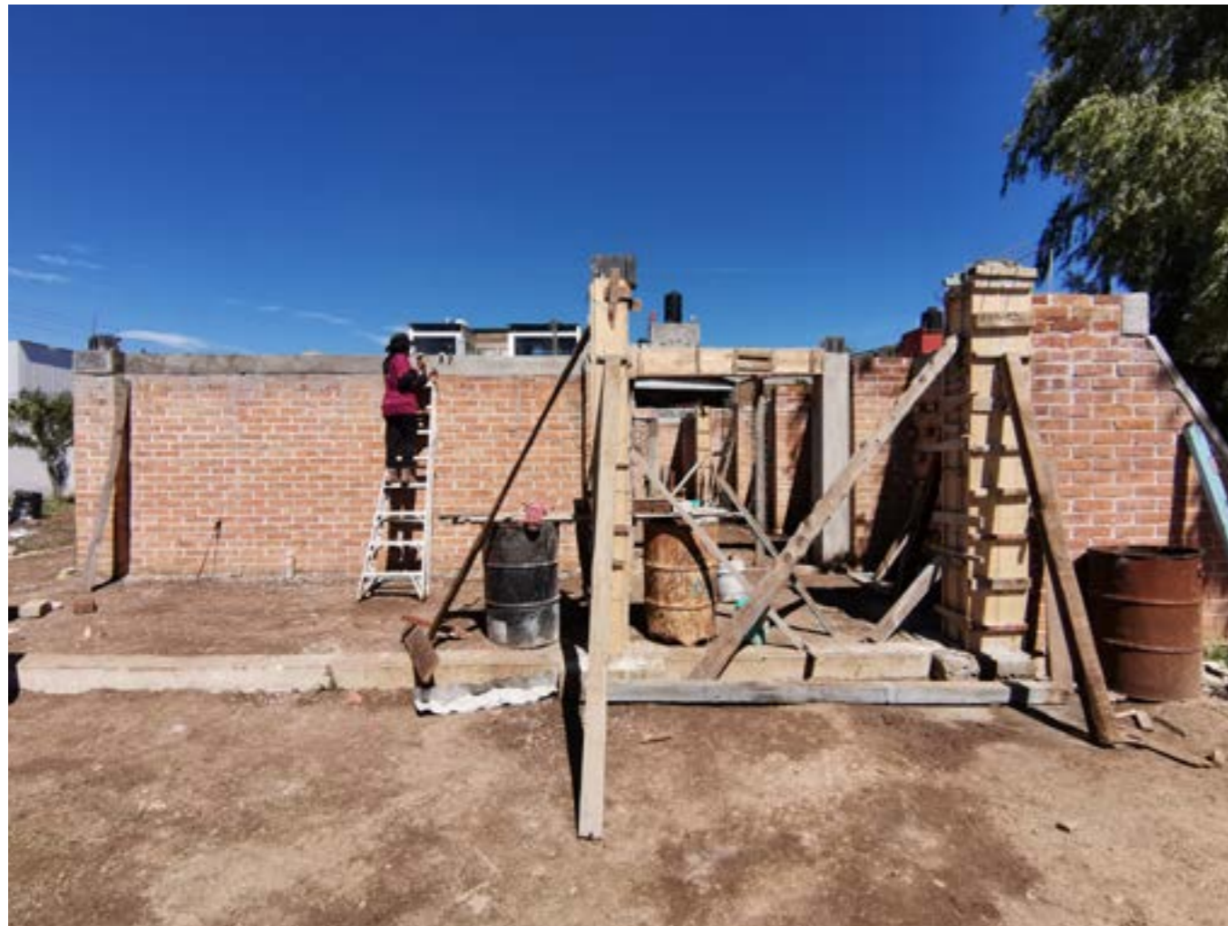
Cimbra en columnas y traveses (cerramiento).
