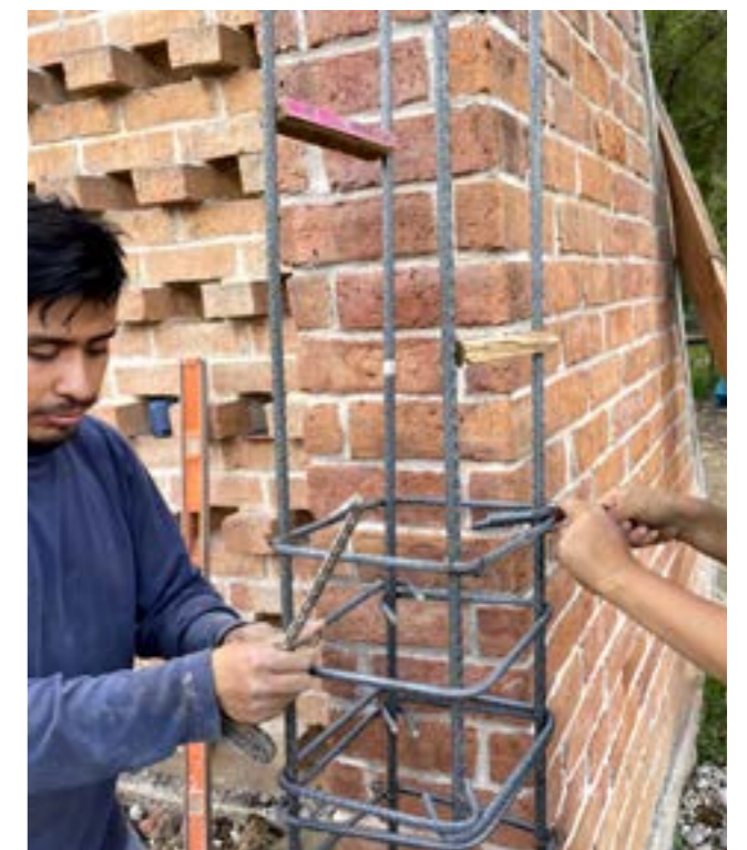
Armado de columna para pórtico.
