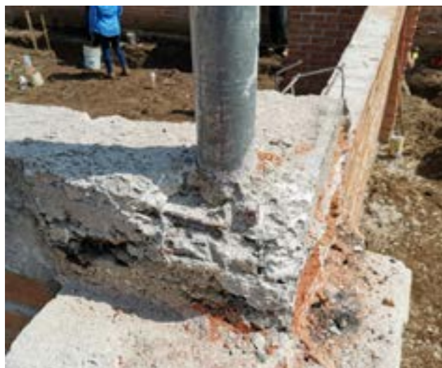
Demolición de cerramiento en la parte de columna
