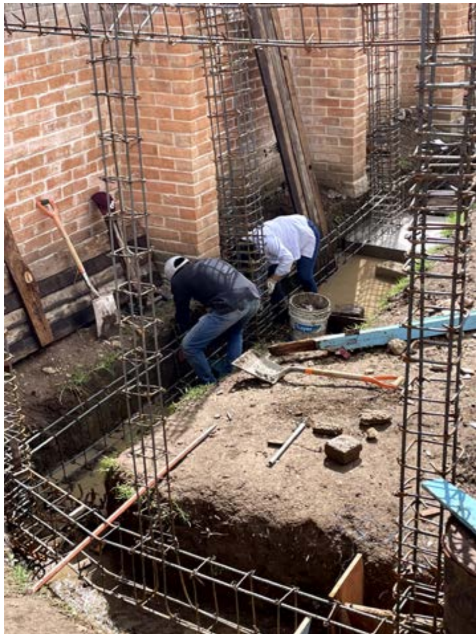
Armado de la nueva estructura.
