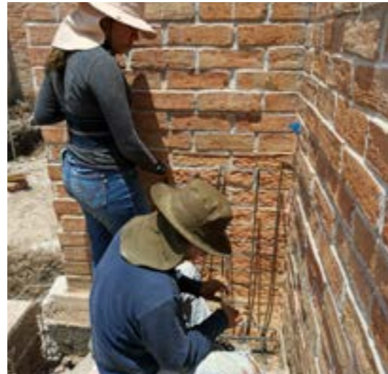
Armado de zapata para lavabo.
