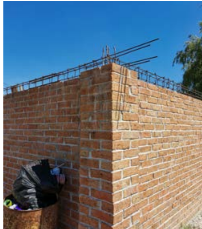
Armado de cerramiento presentado en muro.
