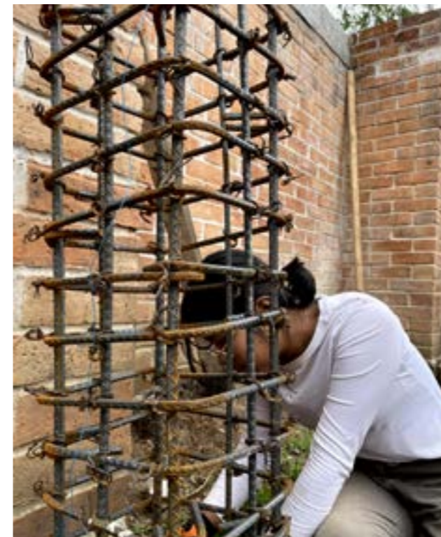
Armado de columna.
