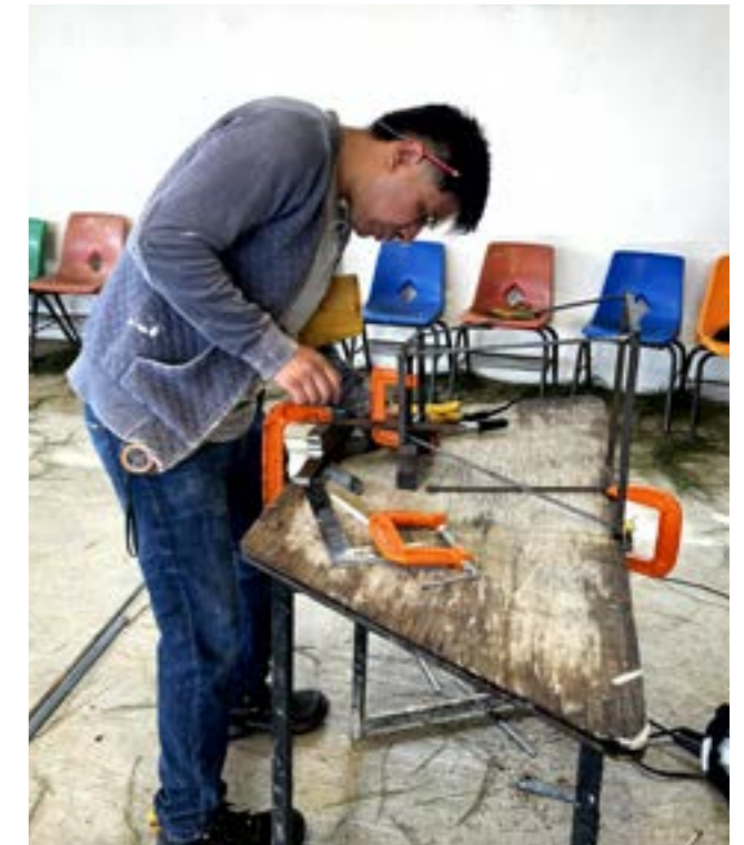
Cimbra en columnas con placa paracubierta.
