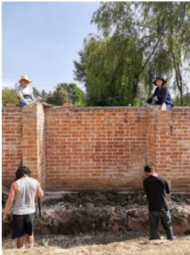
Terminación de nivel de muro.
