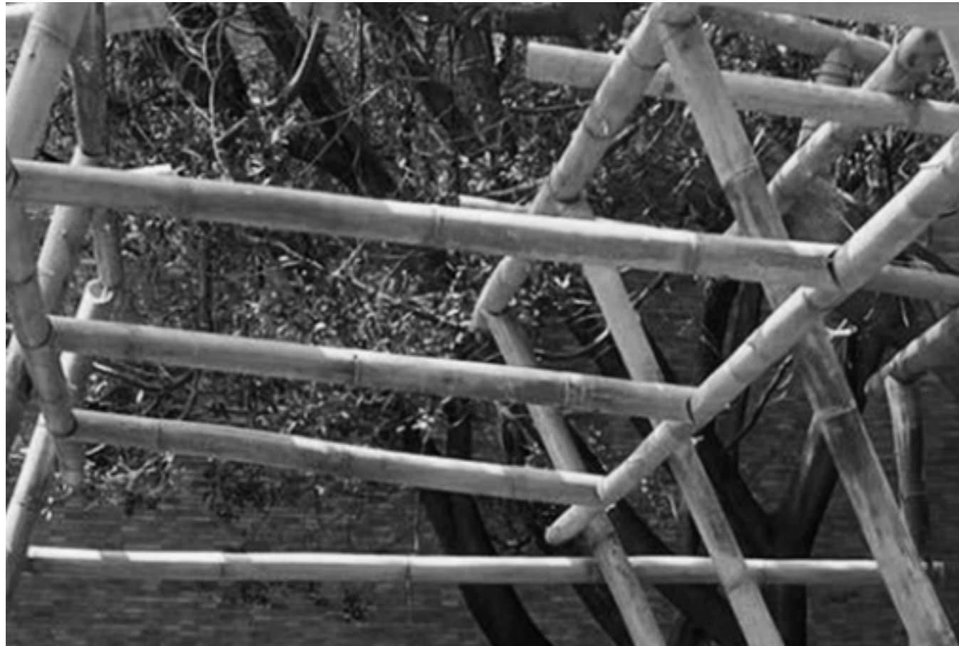
Fig.16_ Fotografía tomada en Facultad de Arquitectura en Ciudad Universitaria (UNAM), del pabellón de bambú realizado por el Seminario Experimental.
