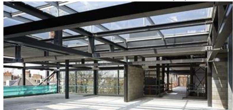
**Figura 62.** Estructura de acero en el nivel 3. *Raftery, P. (2014).*
