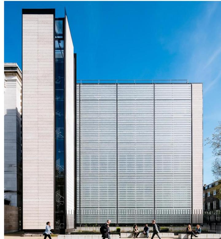
**Figura 57.** Fachada con placas de vidrio termoformado. *Stirk, R. (2014).*
