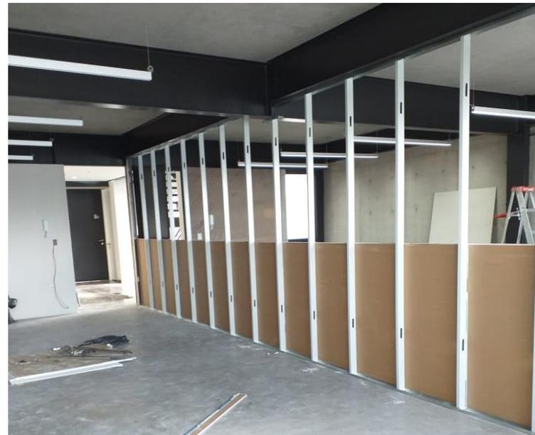
**Figura 127.** Ejemplo de colocación de muro de panel de yeso. ACR Mantenimientos. (s.f.)
