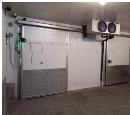
Figura 16. Interior de cámara de refrigeración previa a las cámaras de congelación. Foto: Hernández, 2022.
