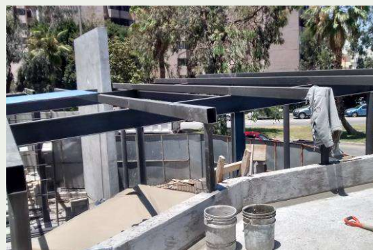
Remate de largueros con edificio de servicio
