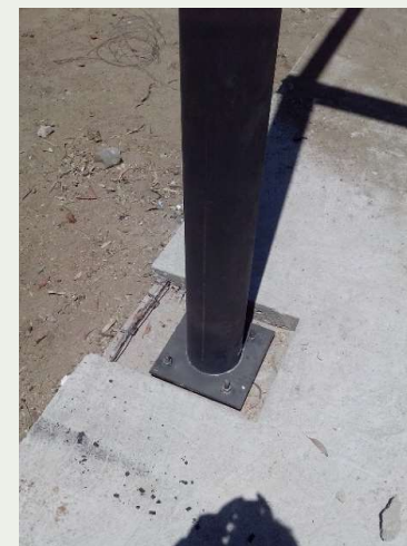
Hincado de columnas tipo OR a placas de acero
