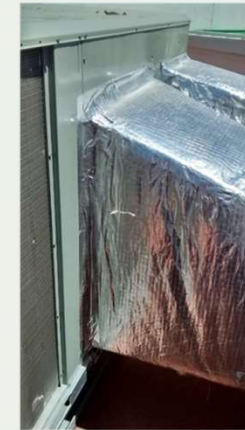
Sellado de ductos de salida y retorno de aire al equipo.
