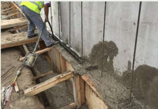
Colado de contratraves y zapatas corridas
