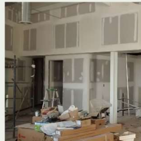
Terminación de Tablarocas.
