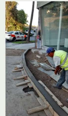
Colado de guarnición de jardín. Inicio de jardinería exterior.
