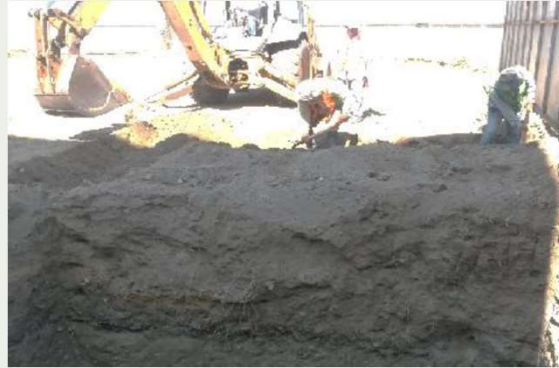
Inicio de Excavaciones para Cimentación
