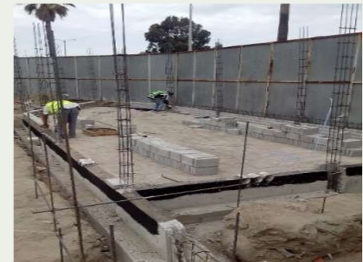
Inicio de desplante de muros de tabique
