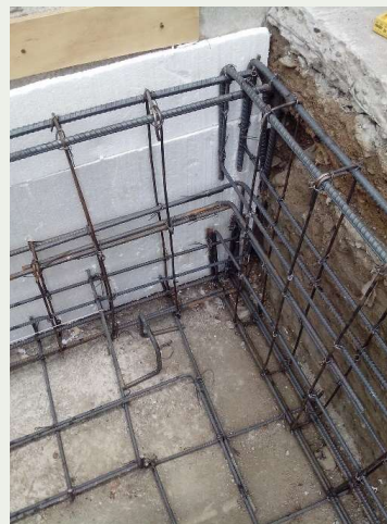
Detalle de armado de zapatas y contratrabes
