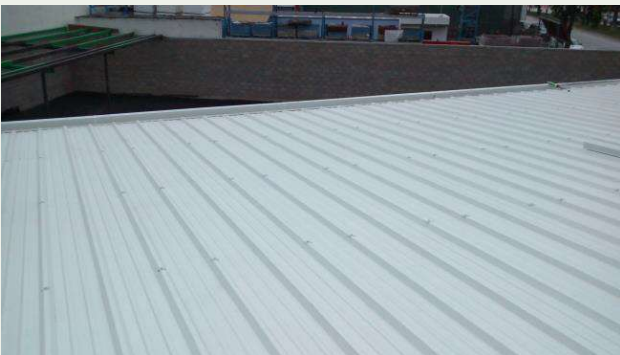
Colocación de cubierta Glamet RV, de Metecho
