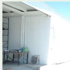
Sellado y pintado de muros exteriores de Durock.
