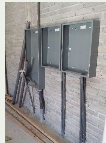
Preparación de tableros de distribución
