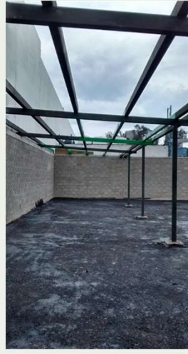
Estructura de estacionamiento techado a base de PTR
