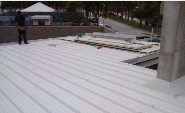
Colocación de cubierta Glamet RV,
