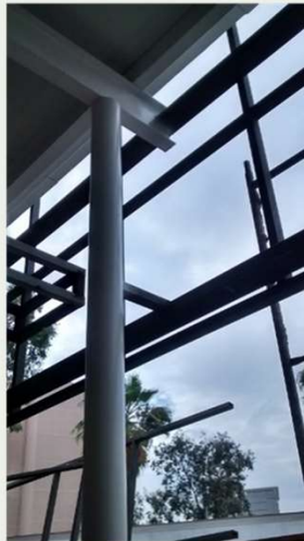
Colocación de ángulos de refuerzo.
