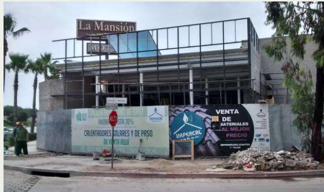
Estructura de faldón de fachada a base de PTR de 2x3"
