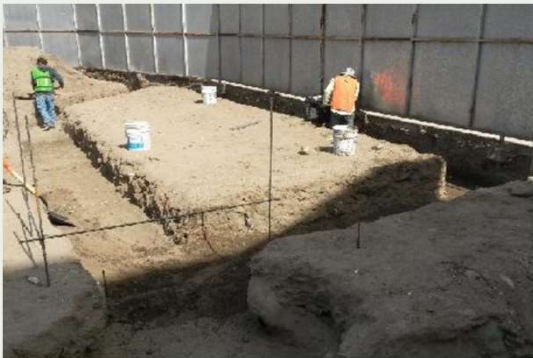
Excavación de cepas para cimentación
