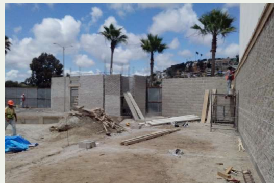
Enrase de bardas de block cara de piedra
