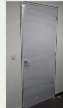
Colocacion de puertas.
