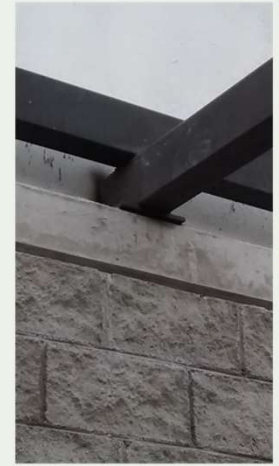
Apoyo de vigas de PTR sobre barda cadena de desplante distribuida en la barda perimetral.
