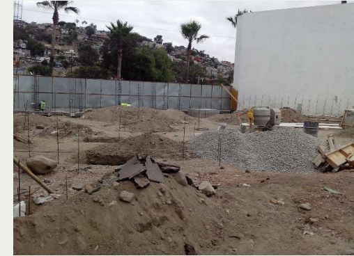
Trazo y nivelación del terreno
