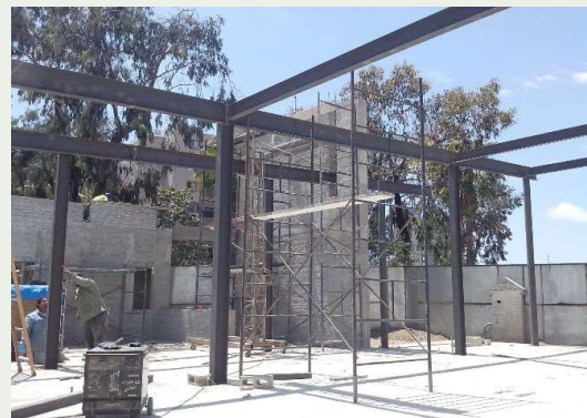
Estructura interior de área temática a base de vigas IPR
