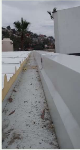
Canalón de agua pluvial y remate de lámina.
