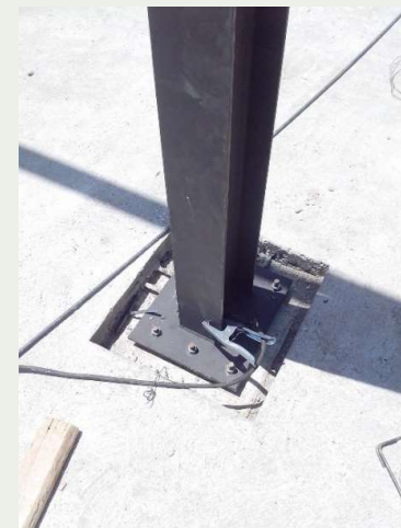
Hincado de columnas metálicas a placas de acero
