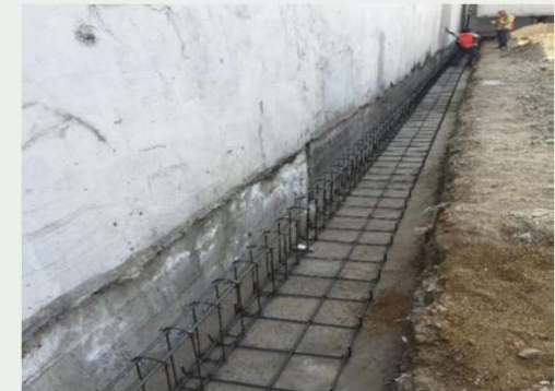
Armado de contratraves de colindancia
