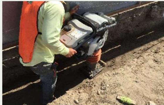
Compactación de plantilla de Zapatas
