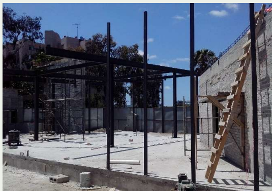
Estructura perimetral a base de PTR de 3x3"
