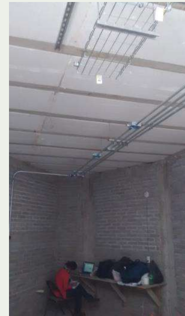
Tendido de tubería galvanizada y Cablofil en área de servicios
