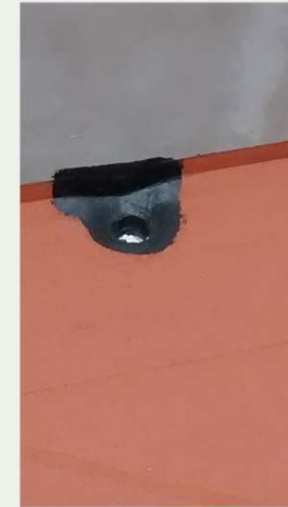
Sellado de bajadas pluviales.
