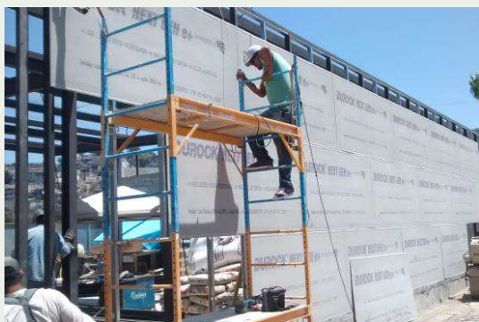
Construcción de muros exteriores a base de Durock
