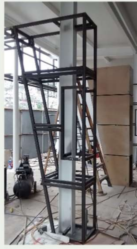
Armado de estructuras de "Sietes" de área temática a base de PTR de 11/2 x 11/2"
