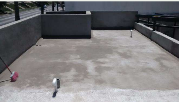
Azotea, con rellenos de perlita para dar pendientes. Sellado con lechada de cemento.
