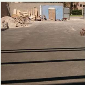
Asfalto en estacionamiento.
