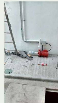
Instalación de bomba centrífuga y alimentación eléctrica.
