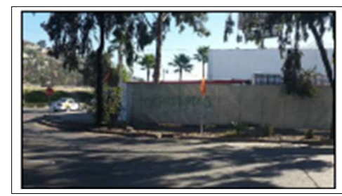
FOTO 3-MURO DE LAMINA Y ARBOL QUE SE VA A RETIRAR
