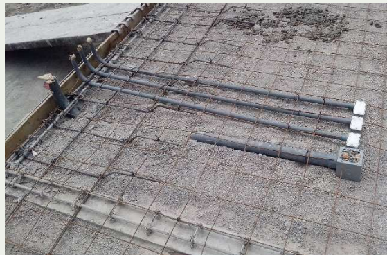
Detalle de armado de firme, colocación de bastones de refuerzo
