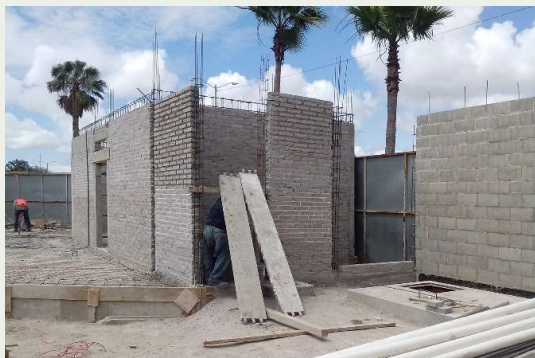
Enrase de muros internos y de colindancia
