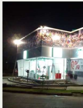
Fachada Principal con Imagen
